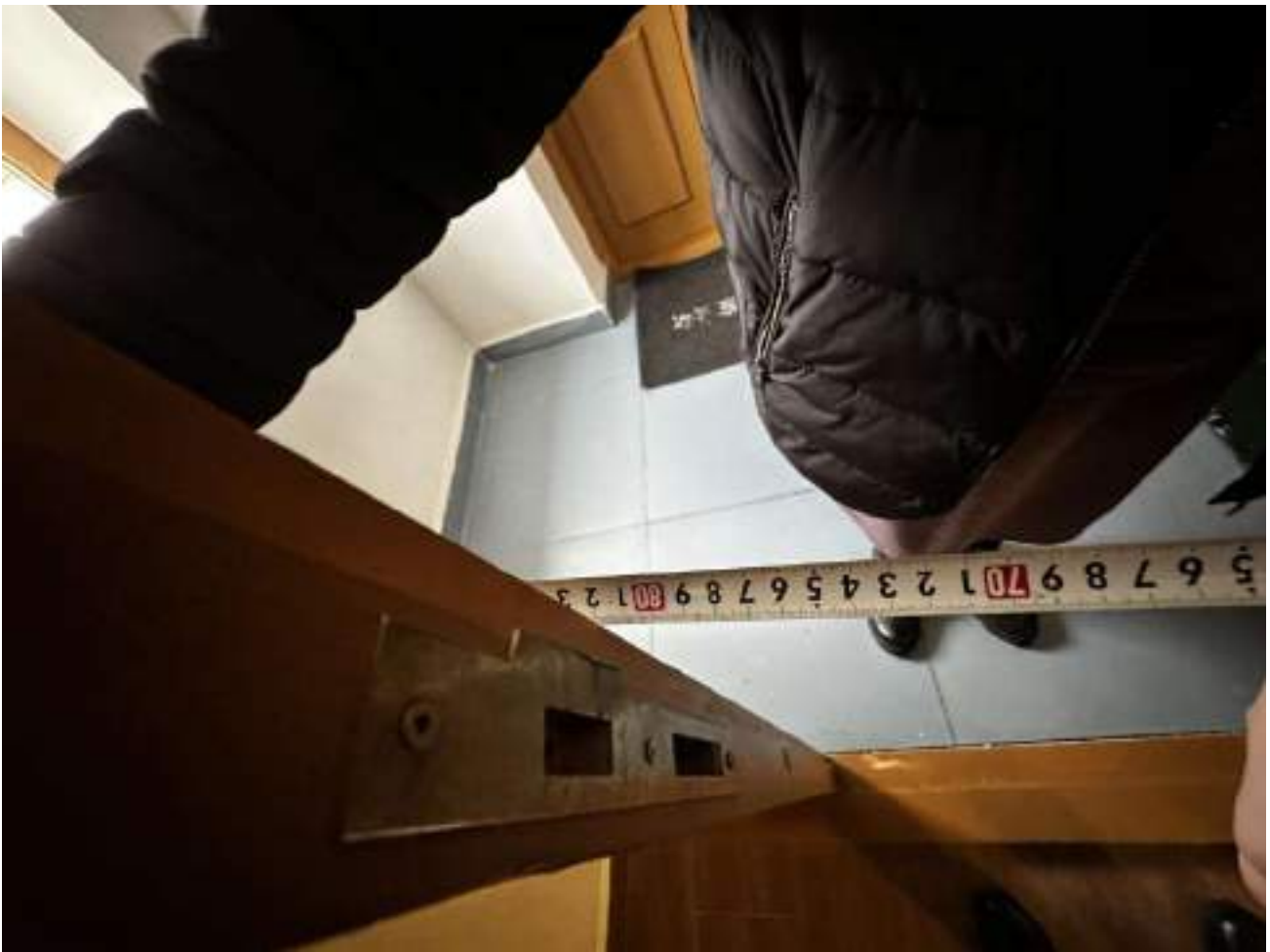
Рисунок 3.17 Ширина дверного проема при открытии одной створки 80 см
