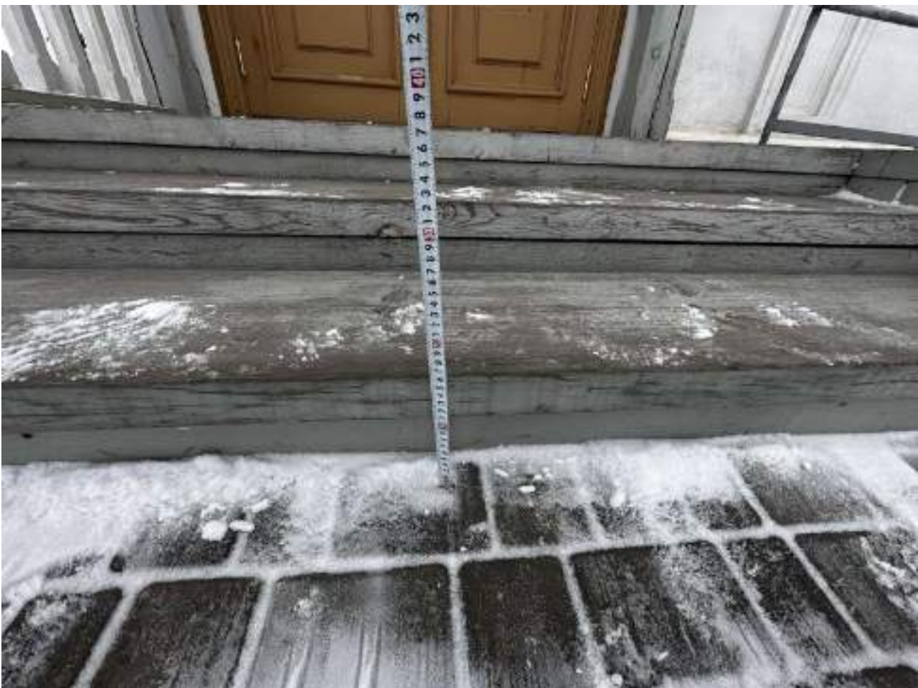
Рисунок 2.2.3 Высота ступени 17 см
