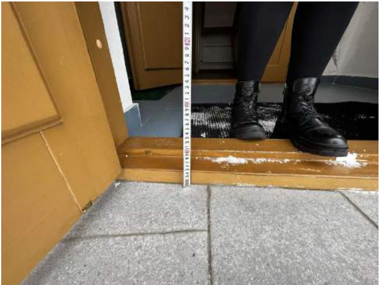
Рисунок 3.21 Высота порога 7 см
