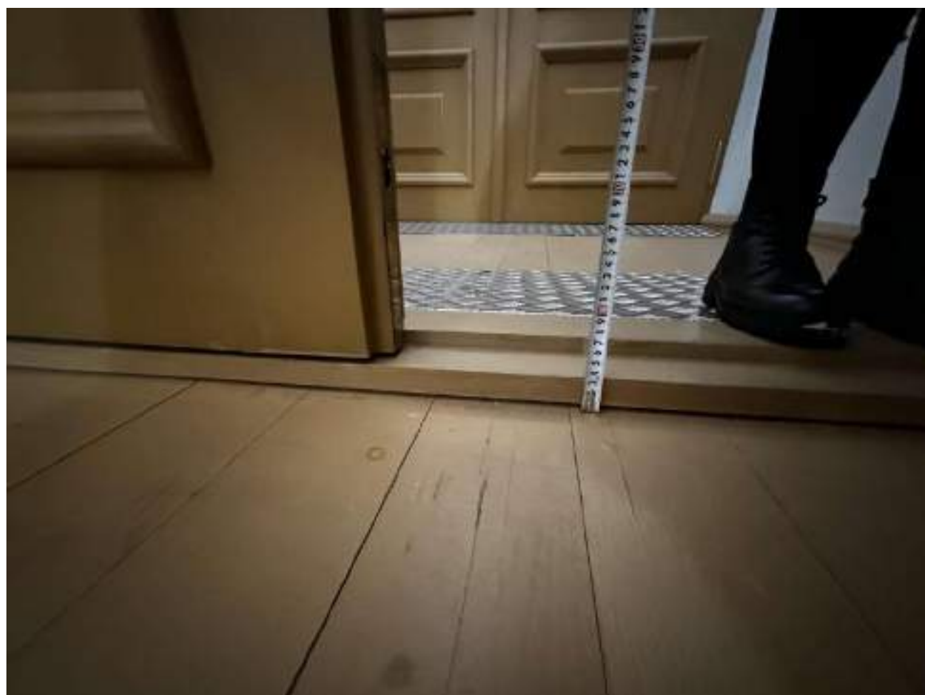
Рисунок 2.2.17 Высота порога 6 см
