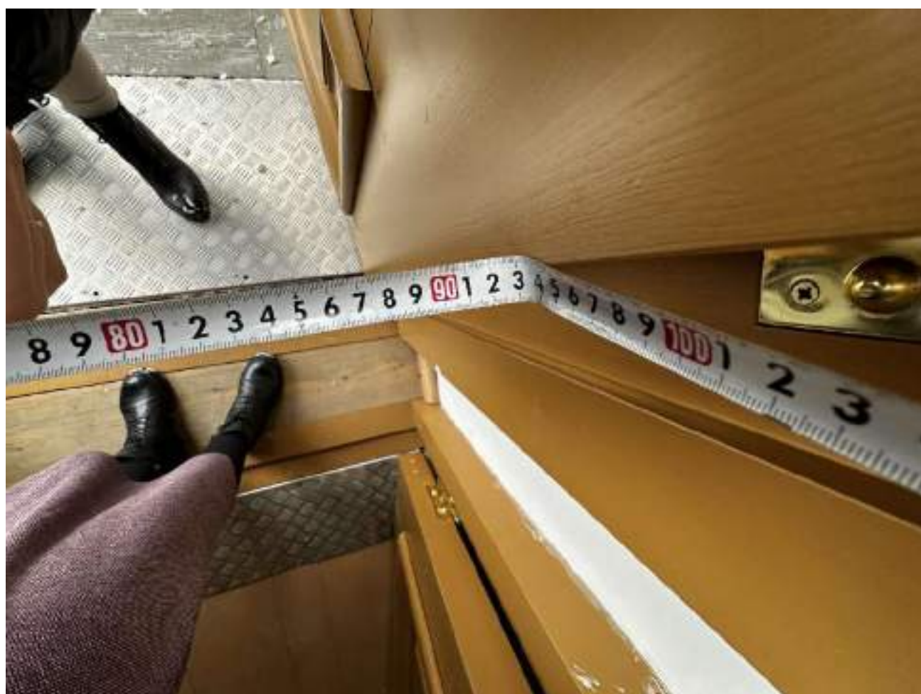
Рисунок 2.2.13 Ширина дверной створки 93 см
