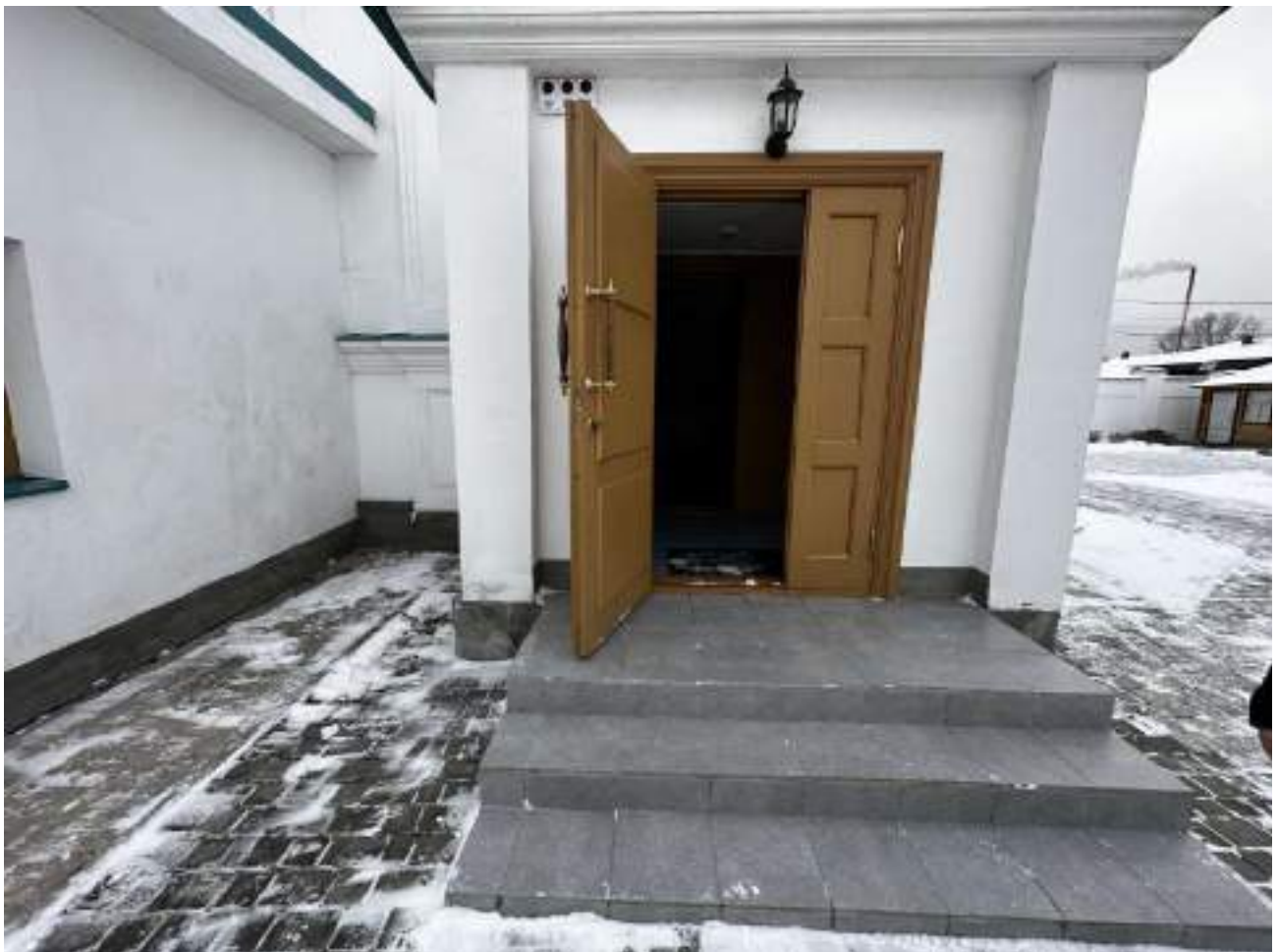
Рисунок 3.22 Эвакуационный выход. Вид с улицы
