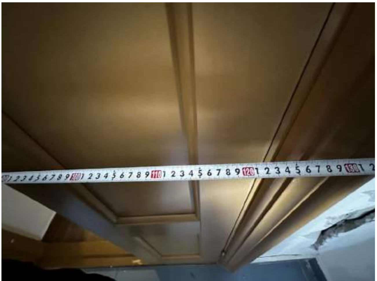
Рисунок 3.18 Ширина дверного проема при открытии двух створок 121 см
