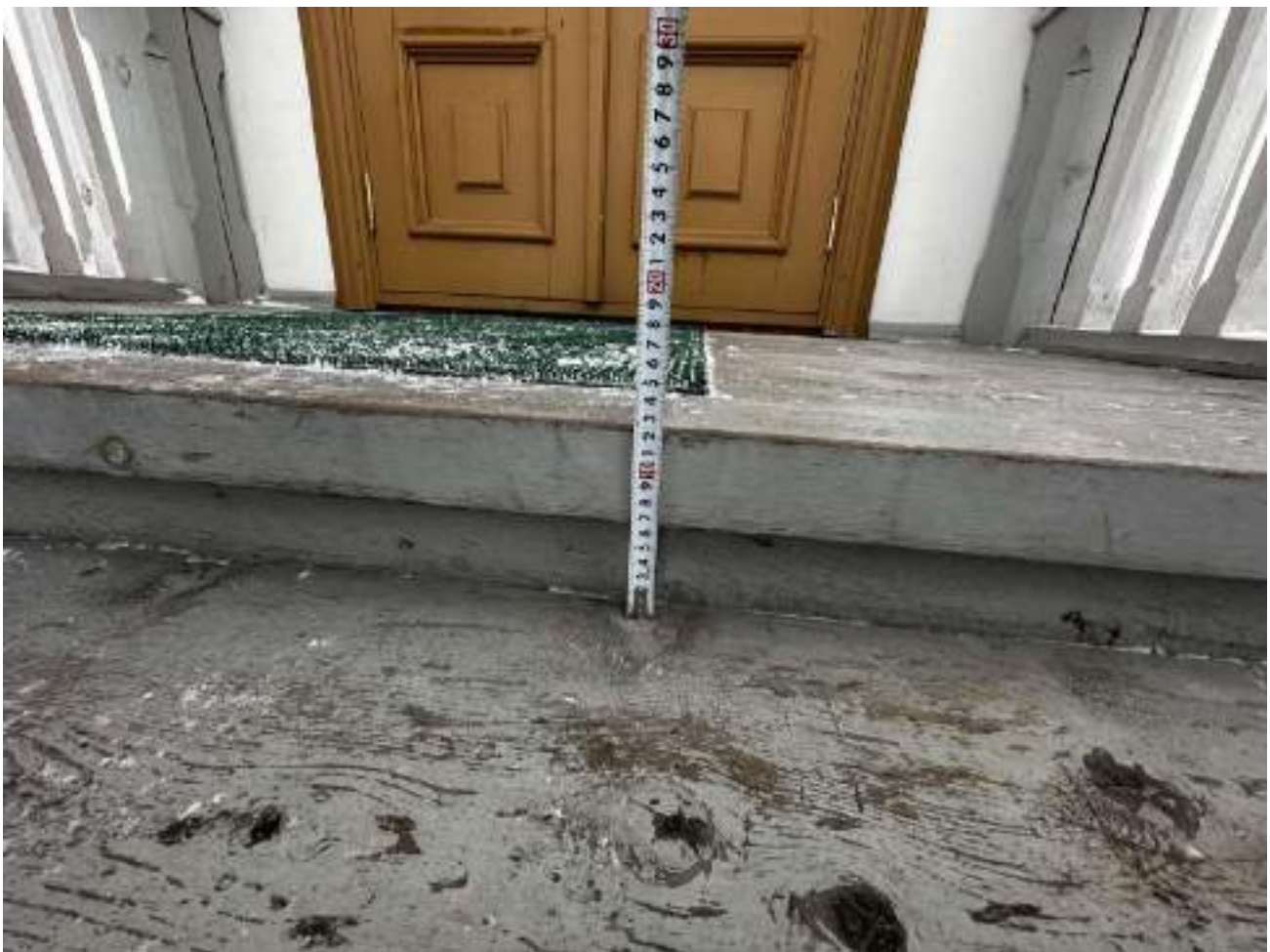
Рисунок 2.1.3 Высота ступени 13 см
