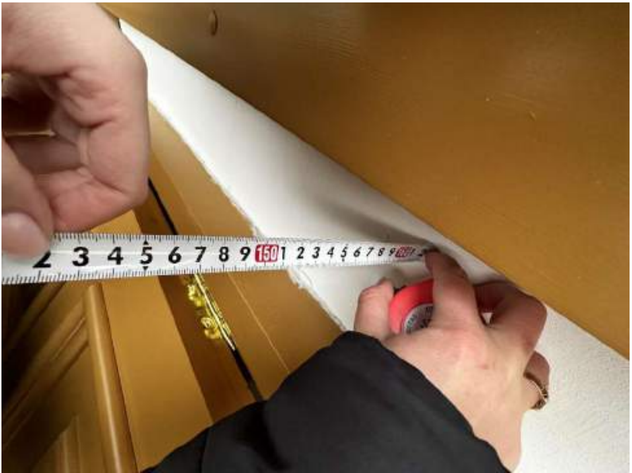
Рисунок 2.1.6 При открытии двух створок ширина дверного проема 150 см
