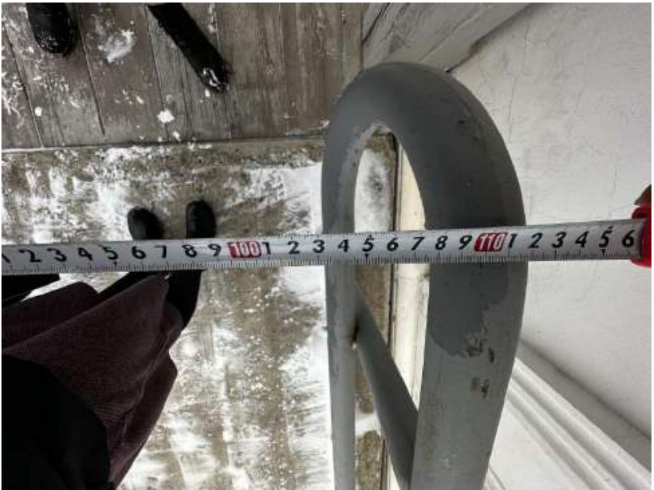
Рисунок 2.2.8 Расстояние между поручнями 108 см
