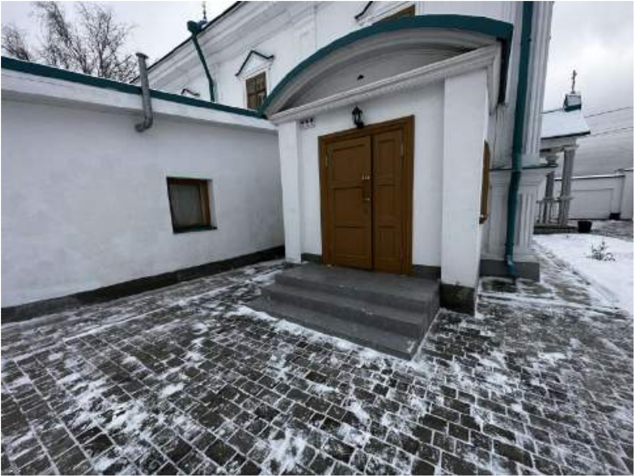
Рисунок 3.25 Эвакуационный выход. Вид с улицы
