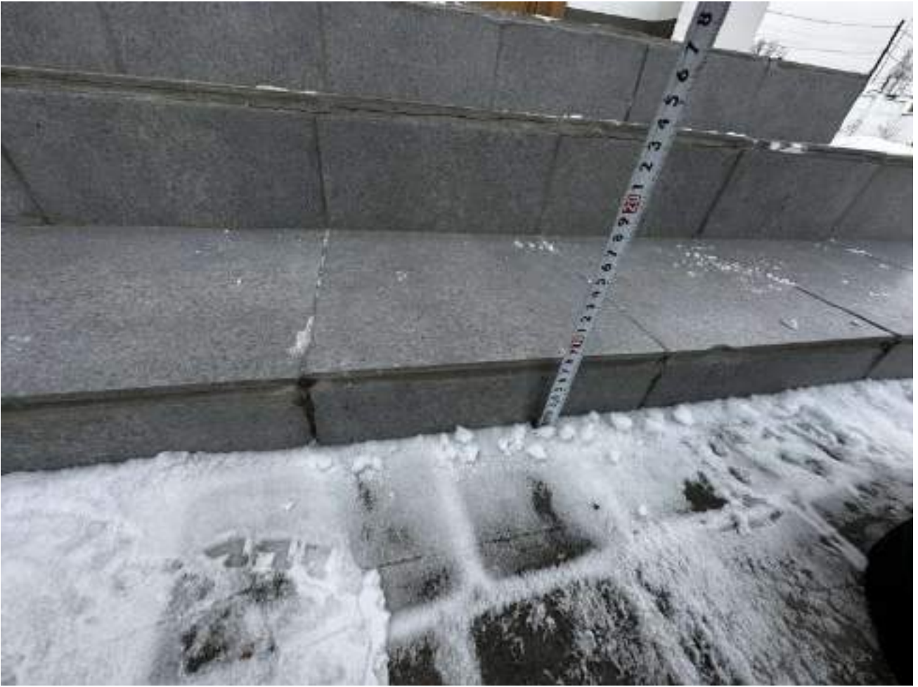
Рисунок 3.23 высота ступени 8 см
