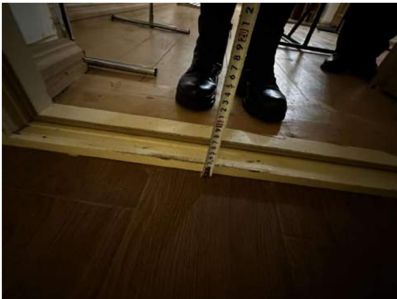
Рисунок 3.11 Высота порога 3 см
