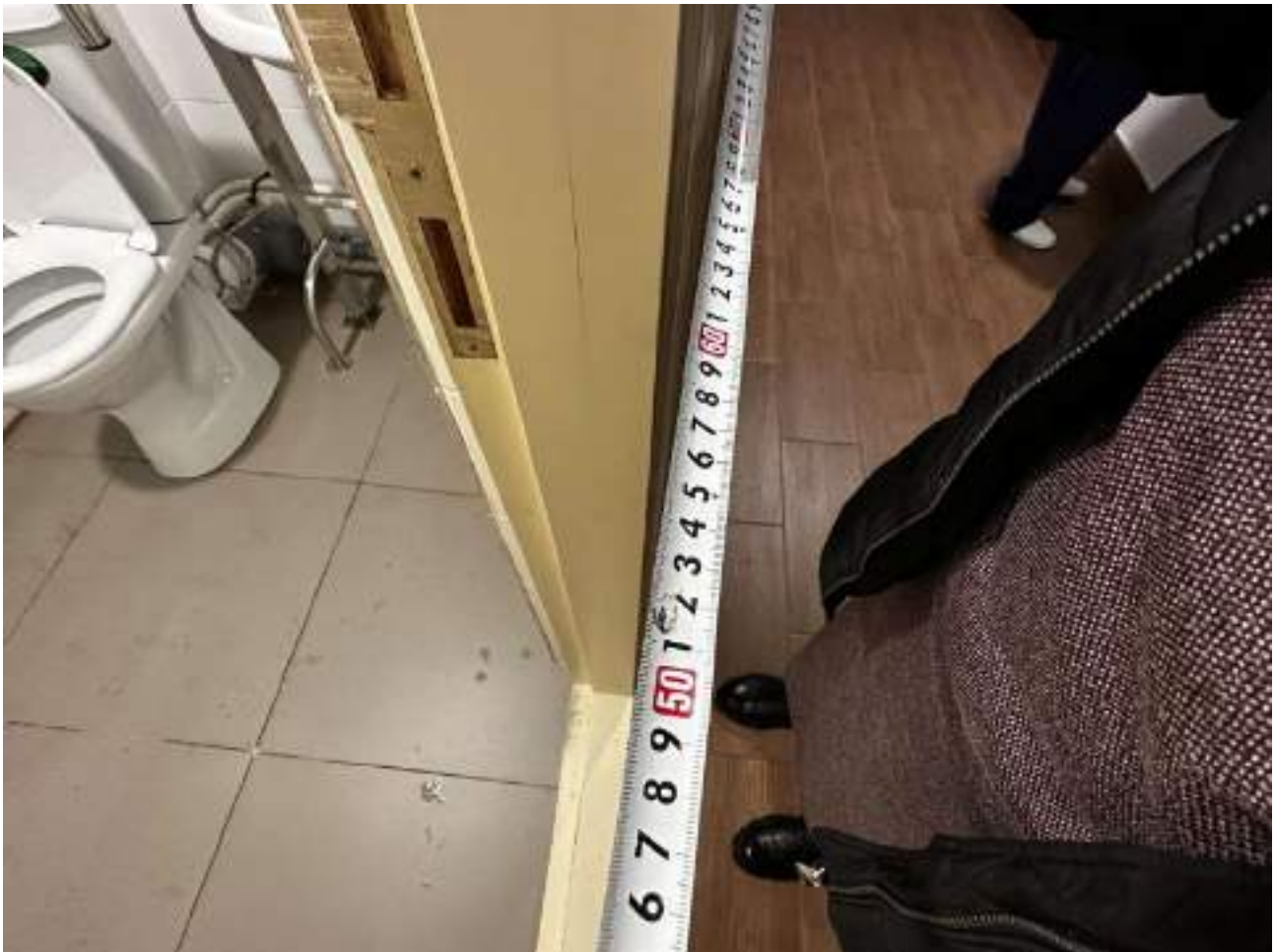
Рисунок 5.2 Ширина дверного проема 60 см
