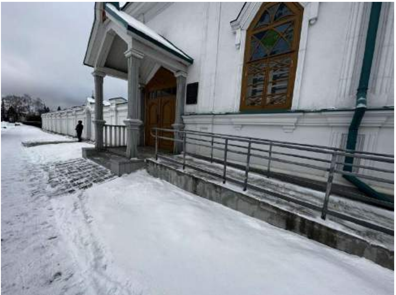
Рисунок 3.28 Эвакуационный выход №2. Вид с улицы
