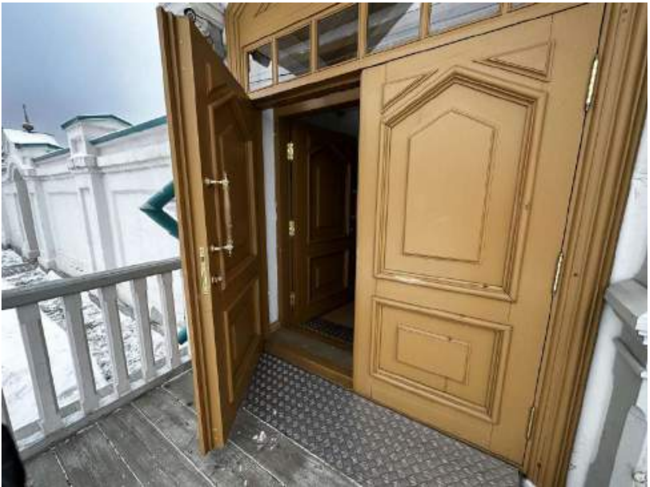
Рисунок 3.27 Эвакуационный выход № 2. Вид с улицы
