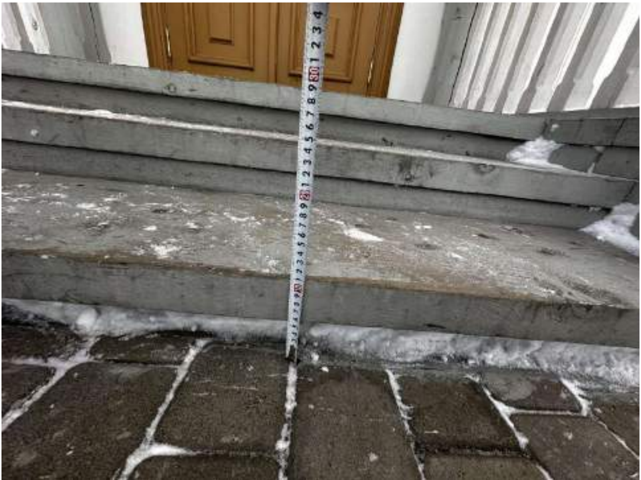
Рисунок 2.1.2 Высота ступени 11 см
