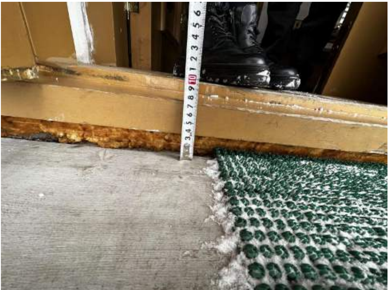
Рисунок 2.1.7 Высота порога 10 см
