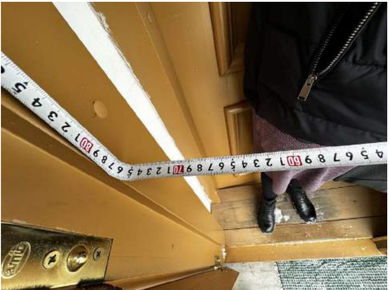
Рисунок 2.1.5 Ширина одной створки 75 см
