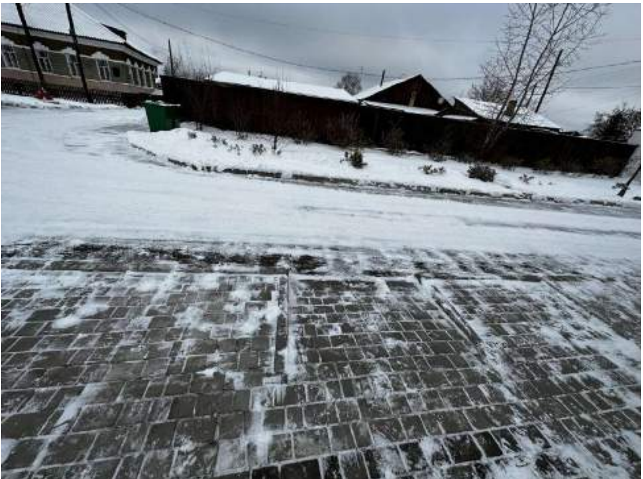
Рисунок 1.4 Пути движения на территории. Понижение бордюрного камня
