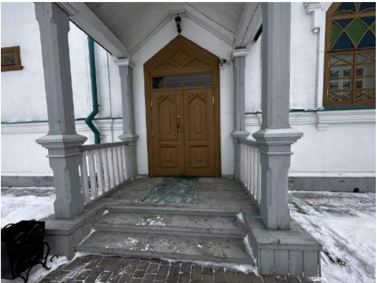
Рисунок 2.1.1 Вход в здание
