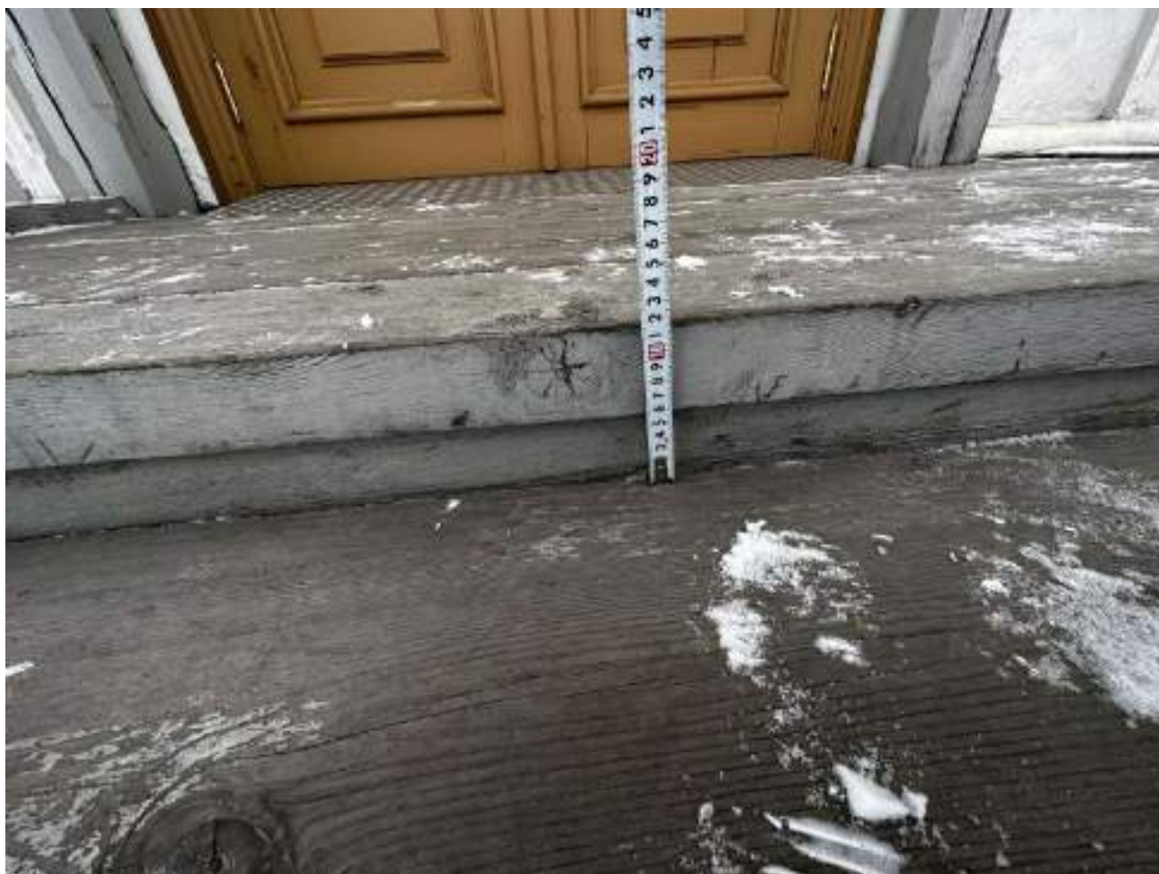
Рисунок 2.2.4 Высота ступени 12 см
