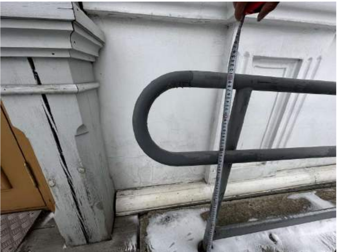
Рисунок 2.2.7 Высота поручней соответствует требованиям
