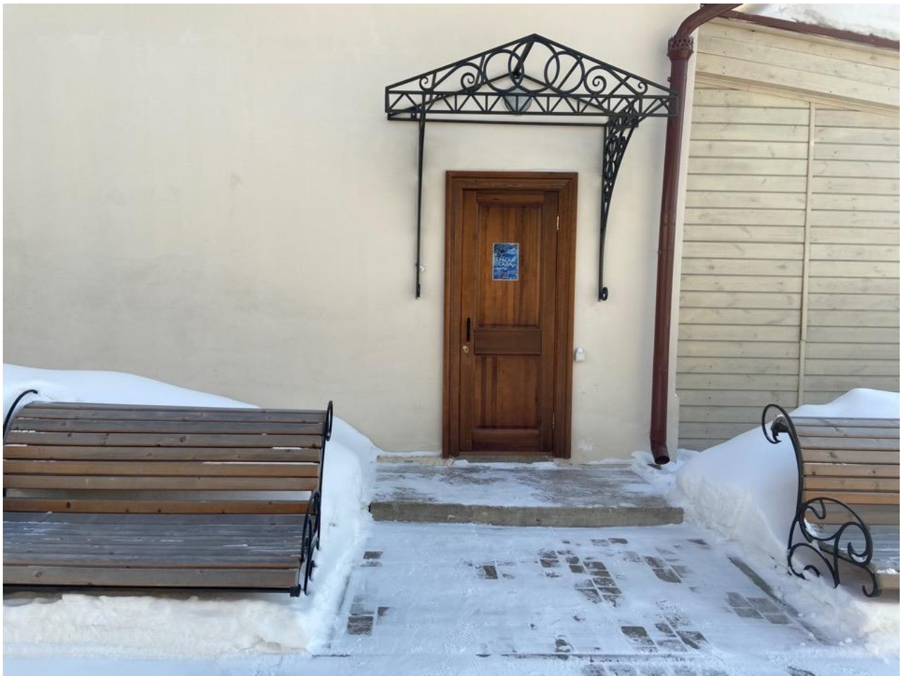
Рисунок 2.1 Центральный вход на объект
