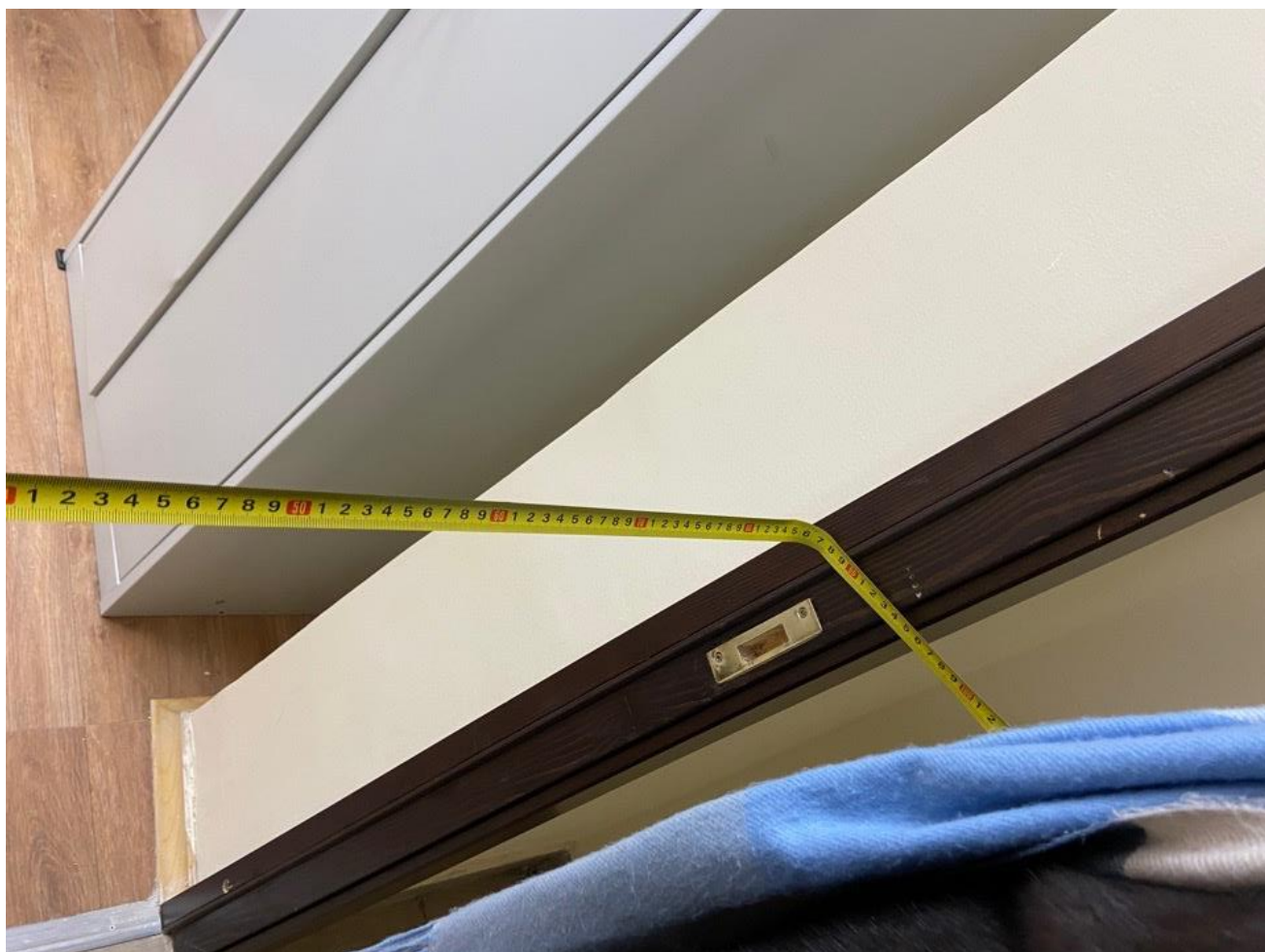
Рисунок 4.5 Ширина дверного проема в кабинете 85 см
