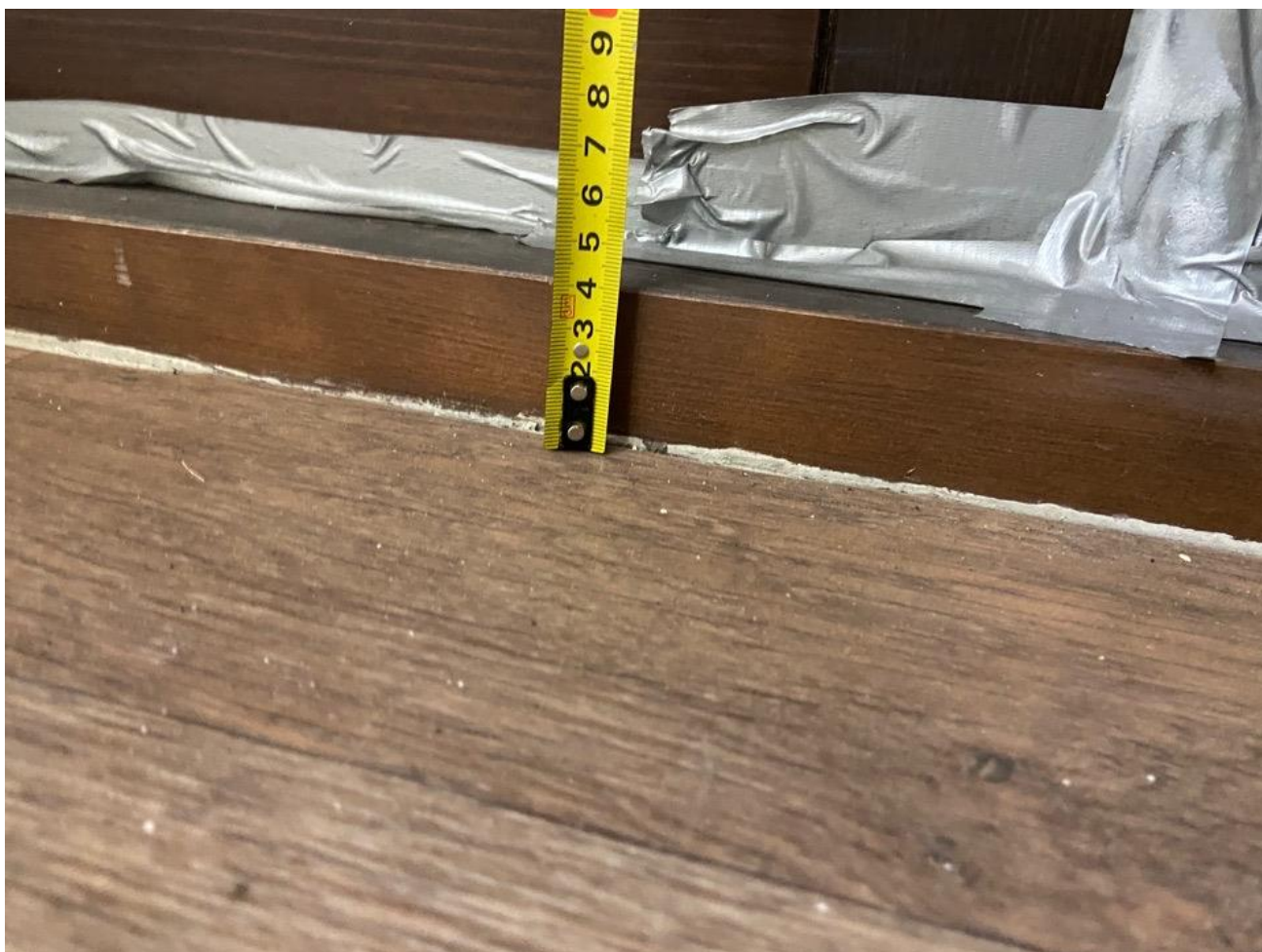
Рисунок 2.7 Высота дверного порога входа для инвалидов на креслах-колясках 4 см
