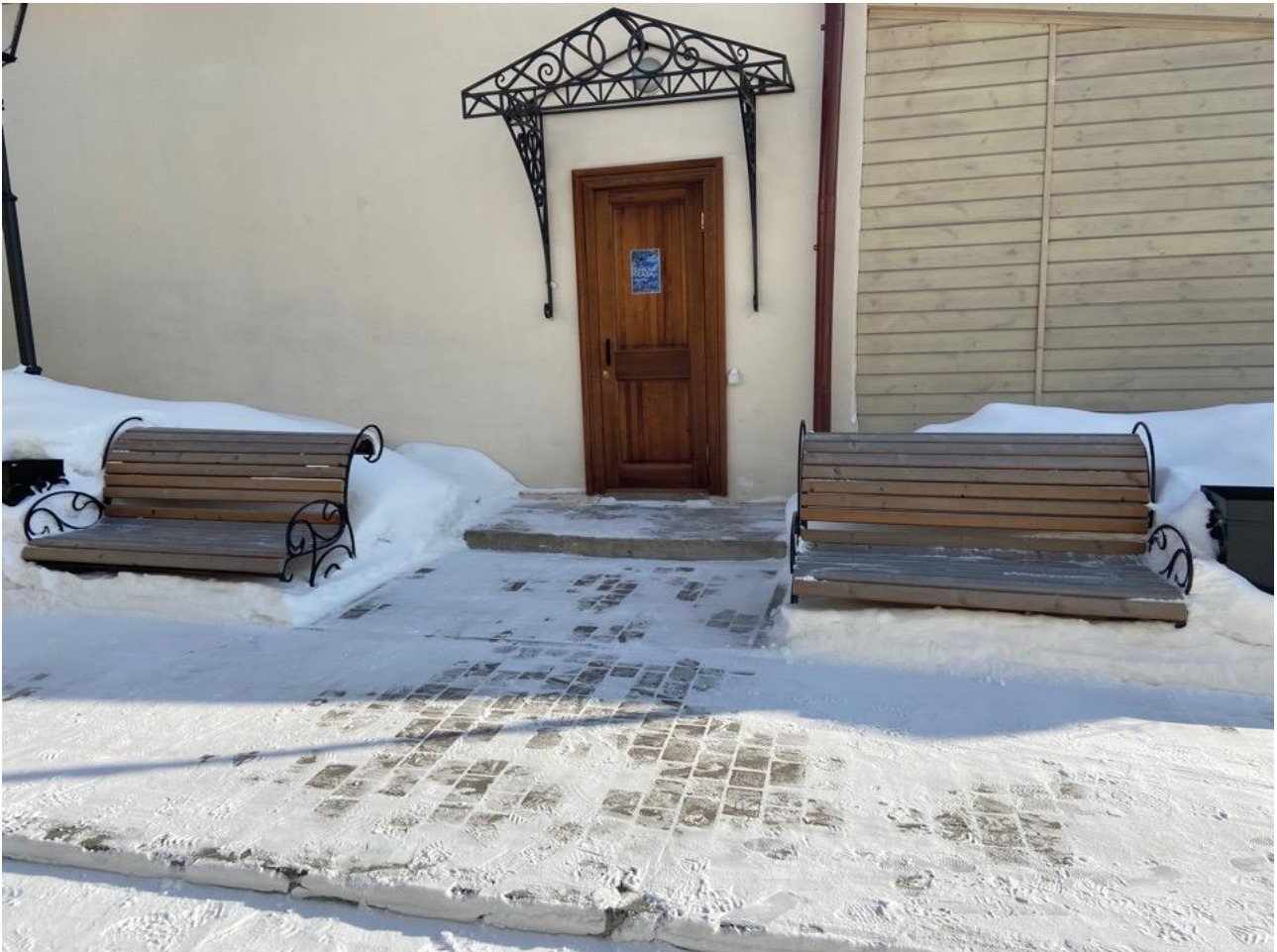
Рисунок 1.3 Отсутствует понижение бордюрного камня
