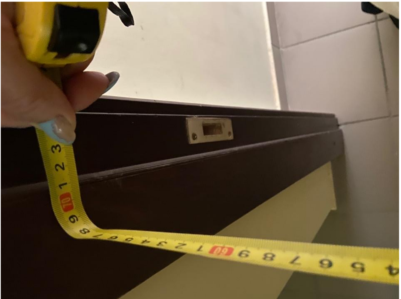
Рисунок 3.5 Ширина дверного проема на путях движения 68 см
