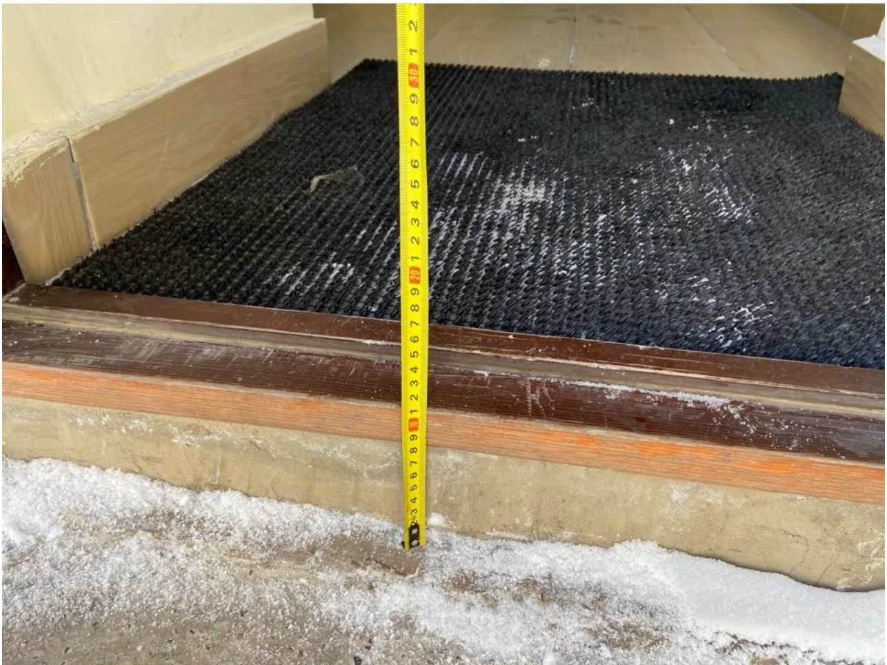
Рисунок 2.3 Высота дверного порога при входе 12 см
