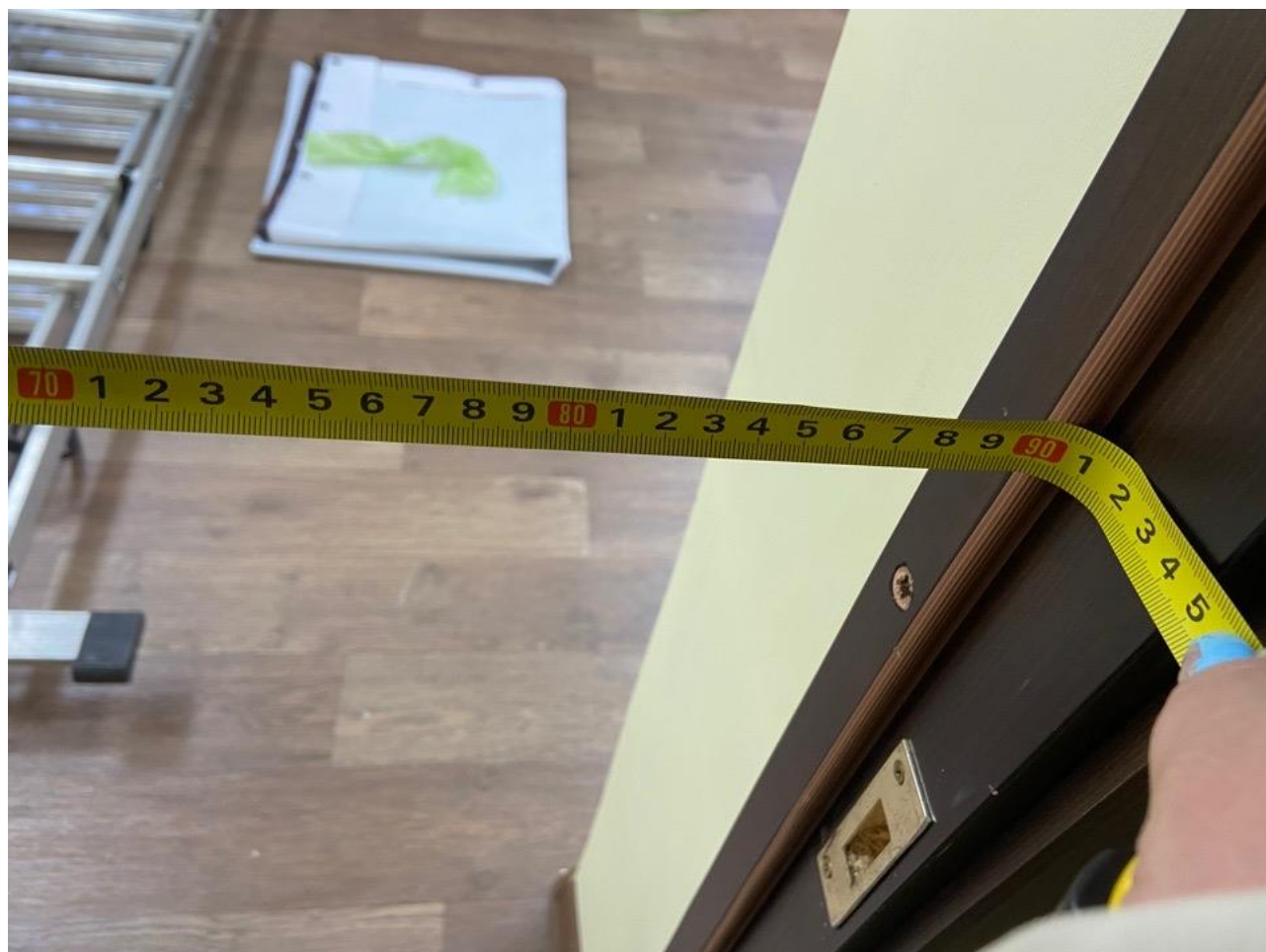
Рисунок 4.3. Ширина дверного проема в выставочном зале 90 см
