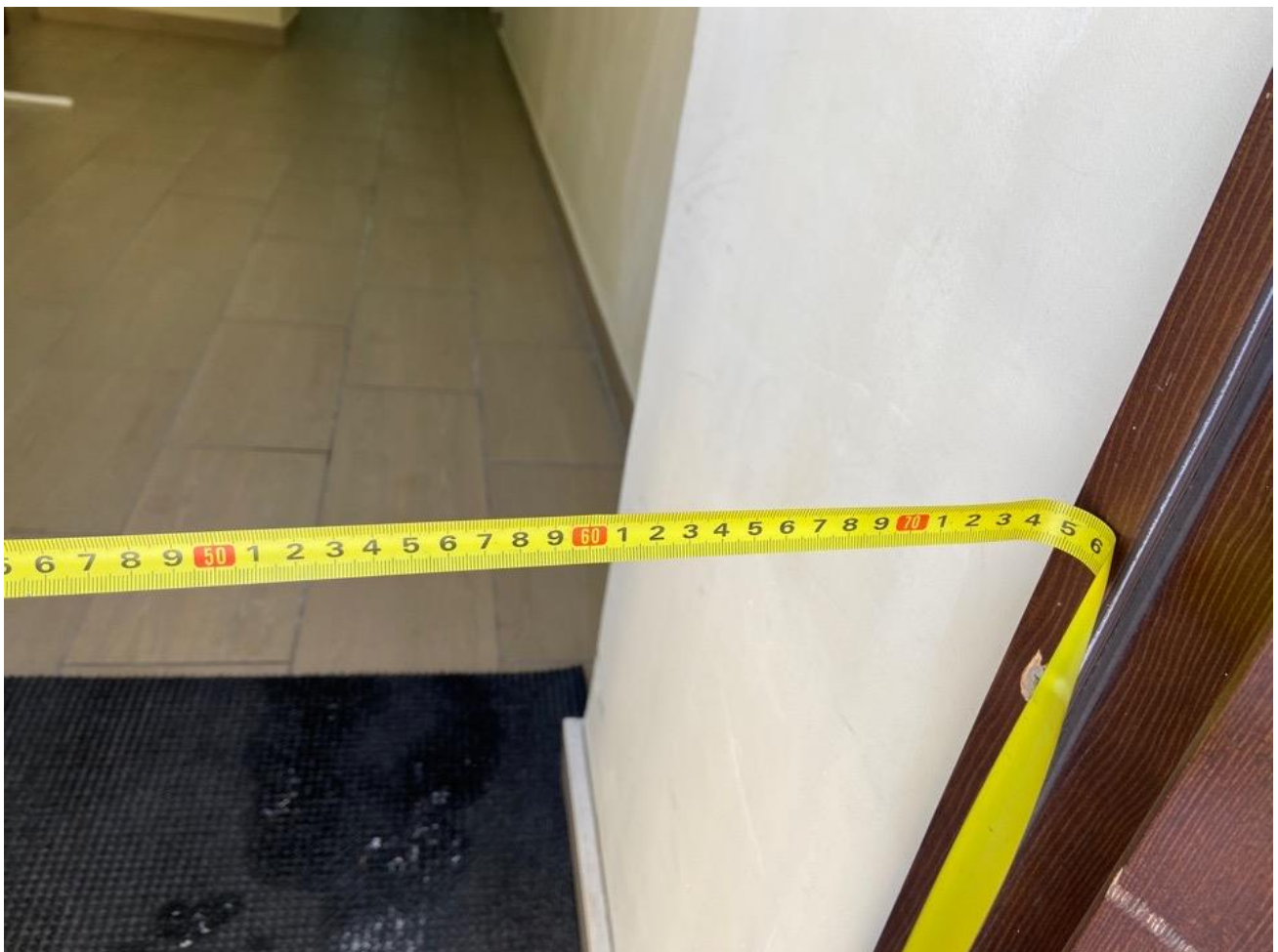
Рисунок 2.4 Ширина дверного проема 74 см
