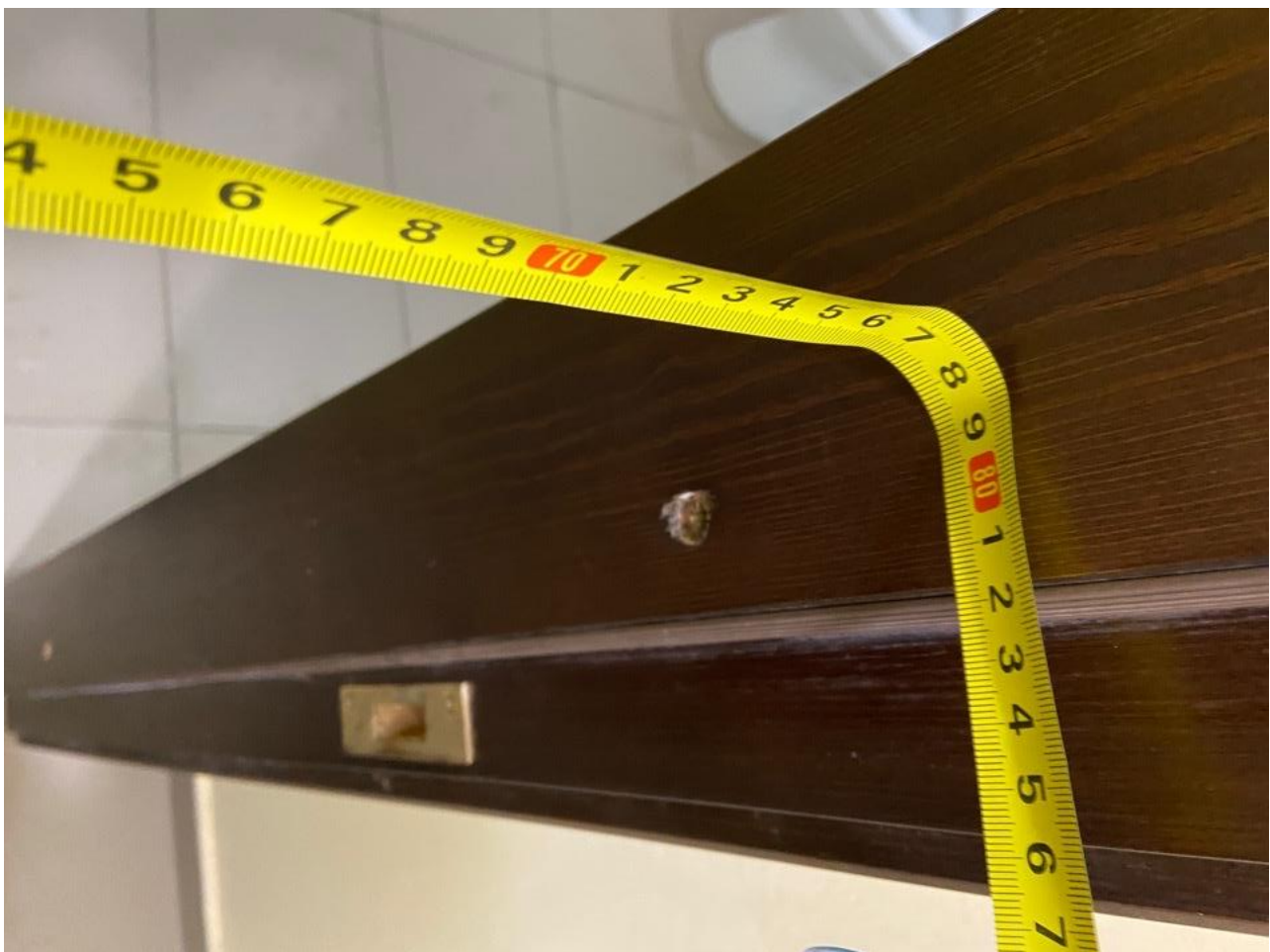
Рисунок 5.2. Ширина дверного проема 77 см
