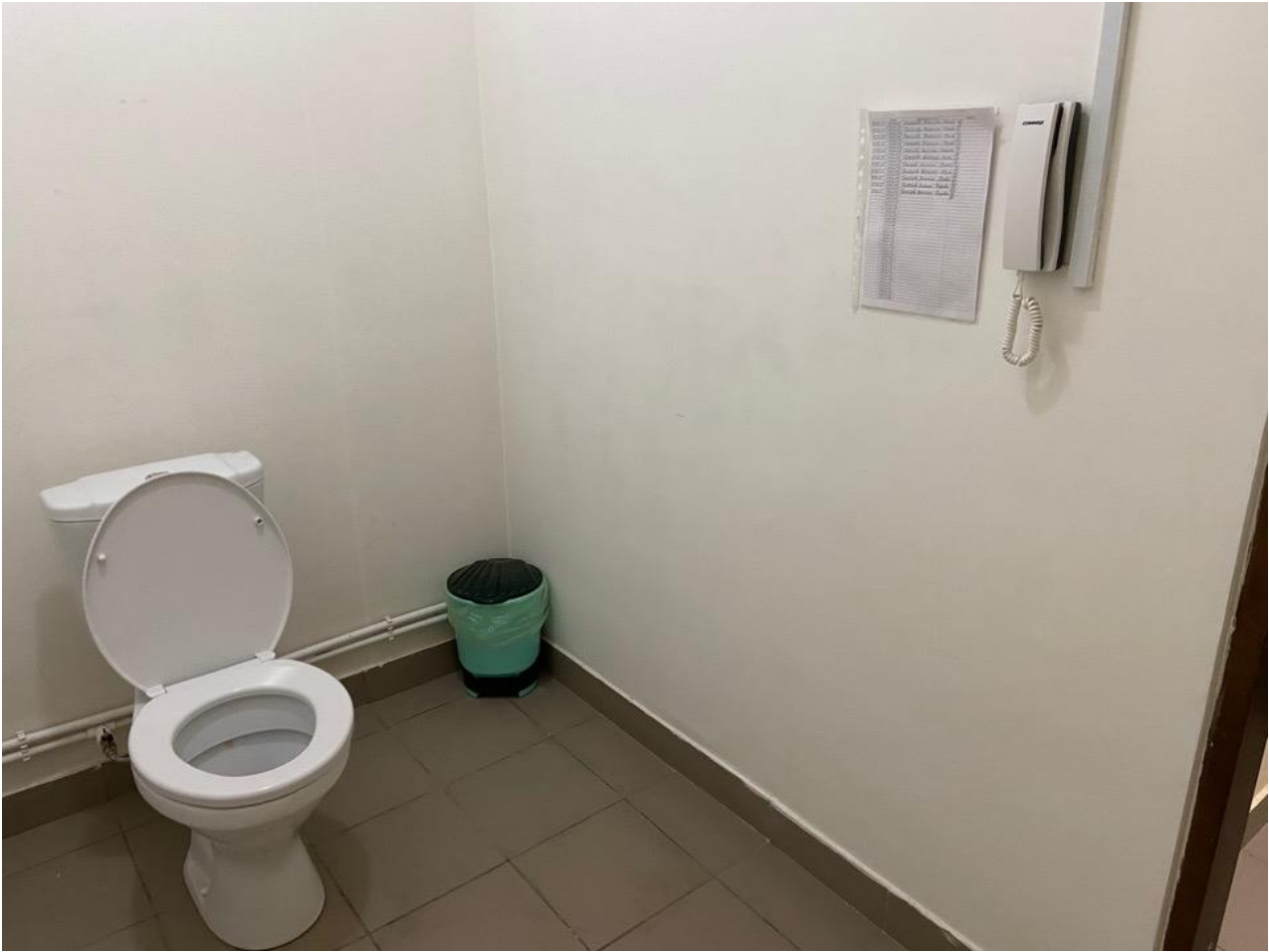
Рисунок 5.5. Устройство двусторонней связи с дежурным
