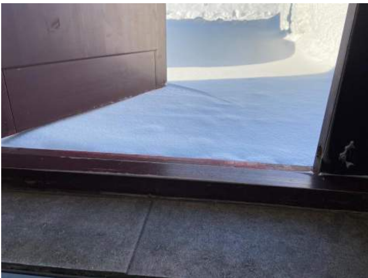
Рисунок 3.14 Дверной порог эвакуационного выхода
