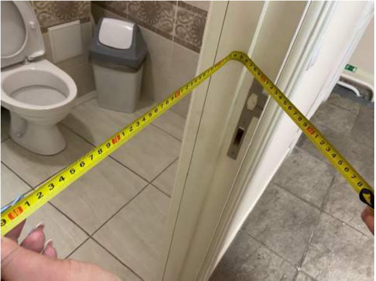
Рисунок 5.2. Ширина дверного проема соответствует норме (93 см)
