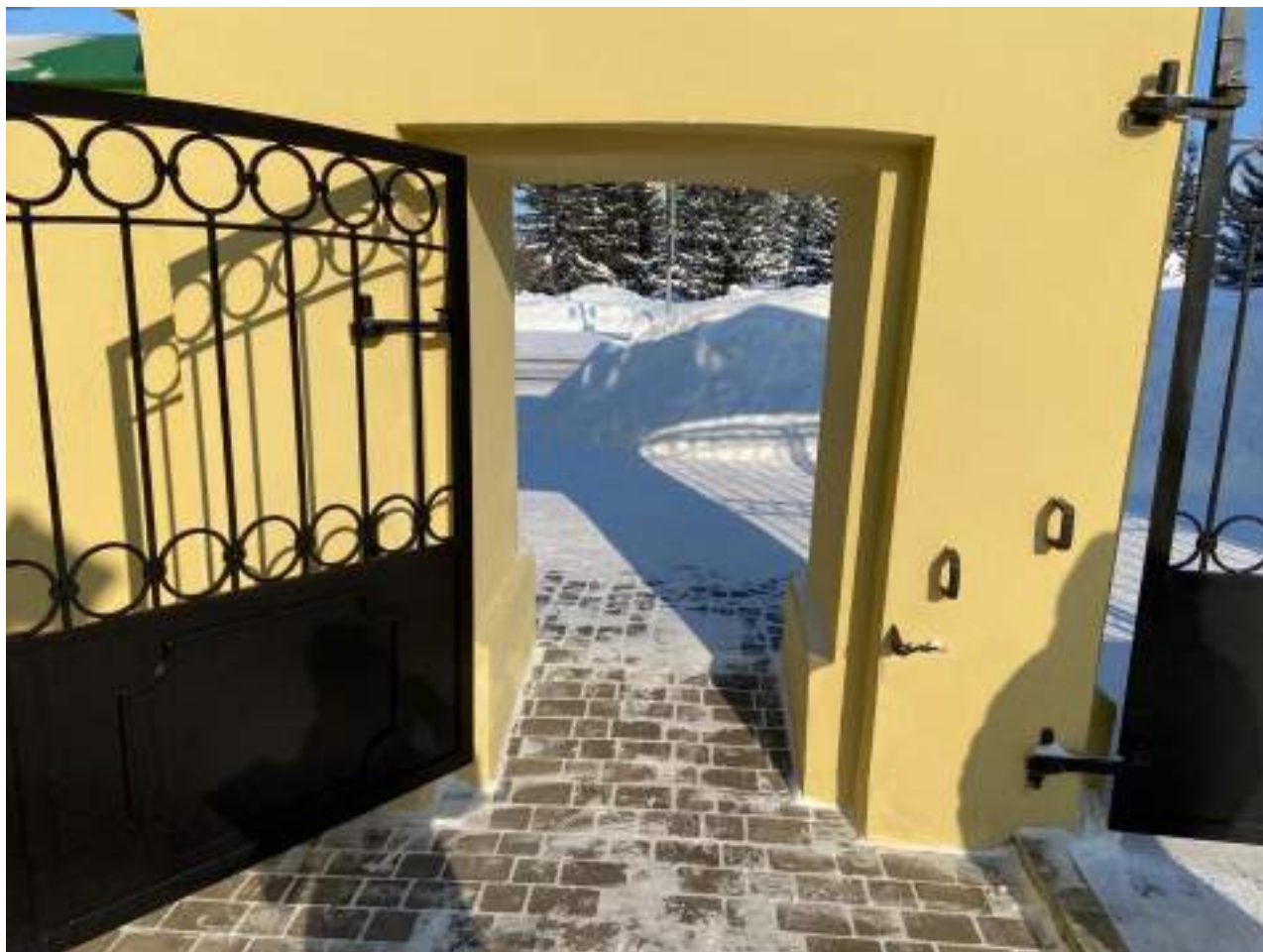
Рисунок 1.2 Вход на территорию. Вид со стороны объекта
