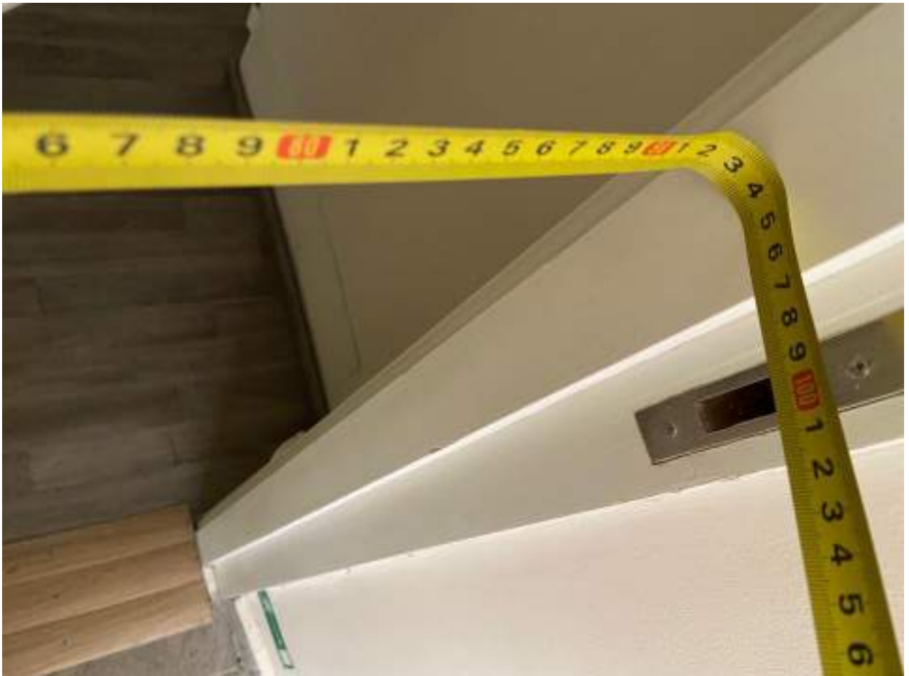
Рисунок 3.4 Ширина дверного проема на путях движения (1 этаж) соответствует норме (91 см)
