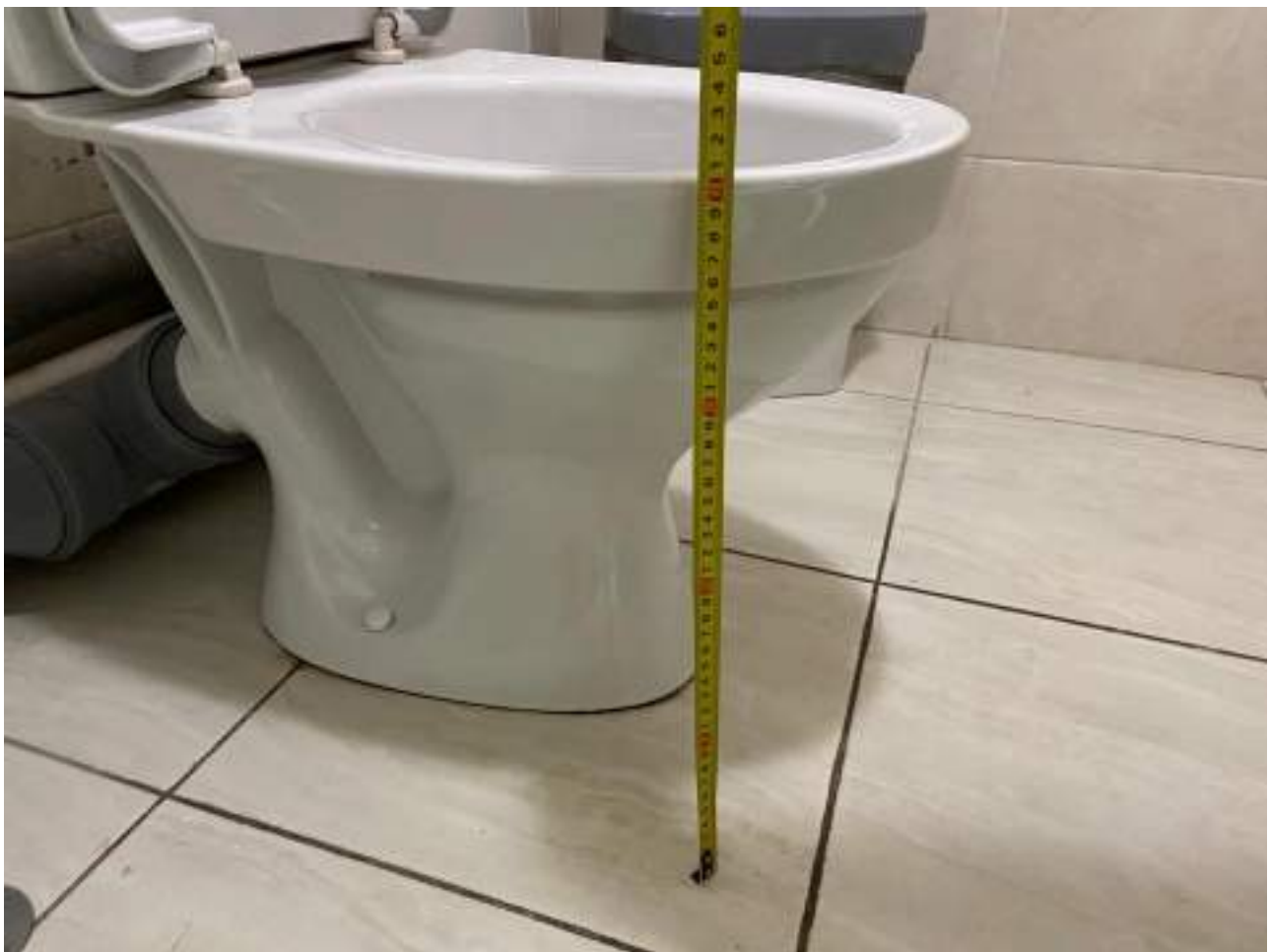
Рисунок 5.5. Высота унитаза не соответствует норме (40 см)
