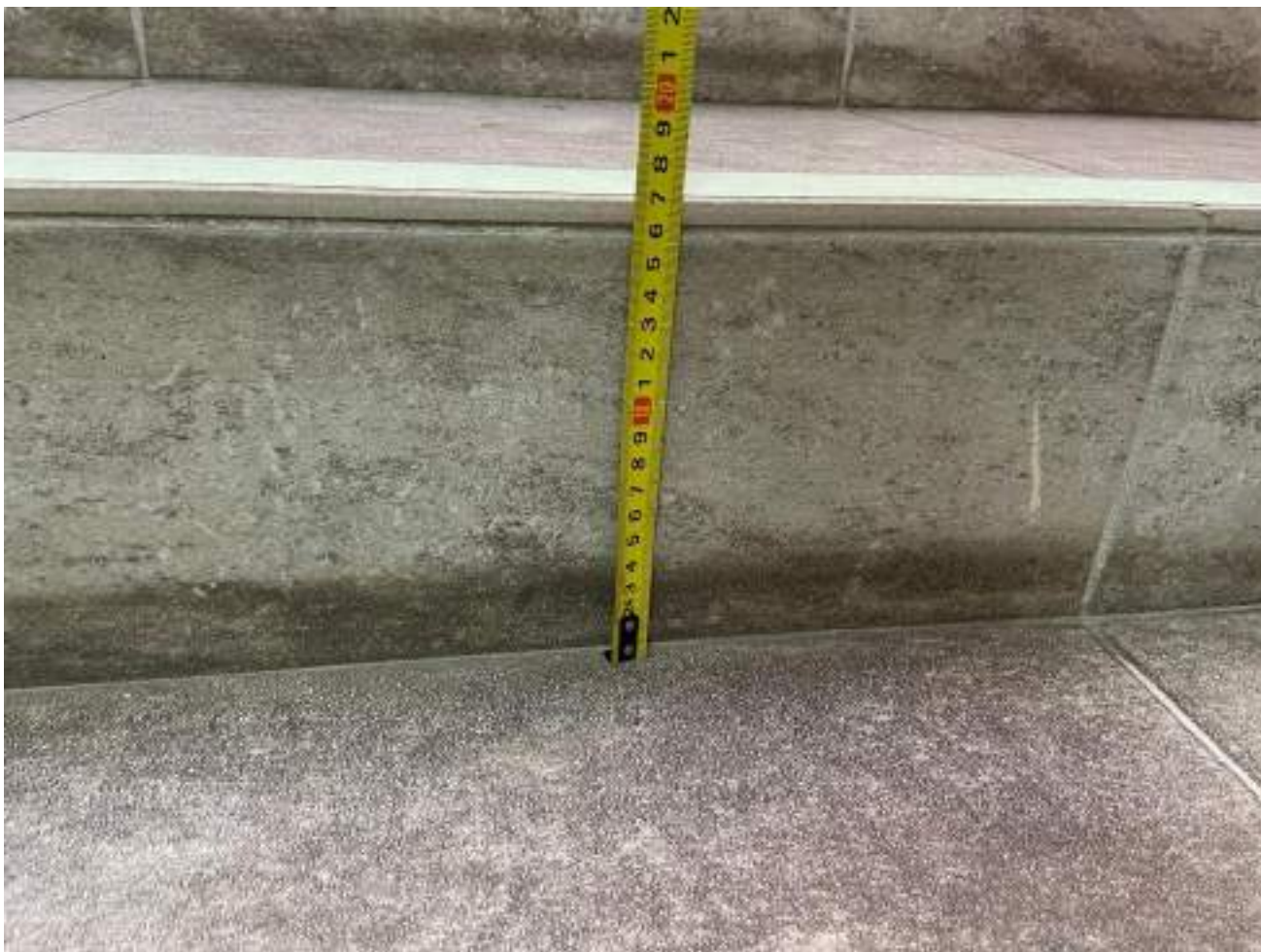
Рисунок 3.9 Высота подступенка в пределах нормы (17 см)
