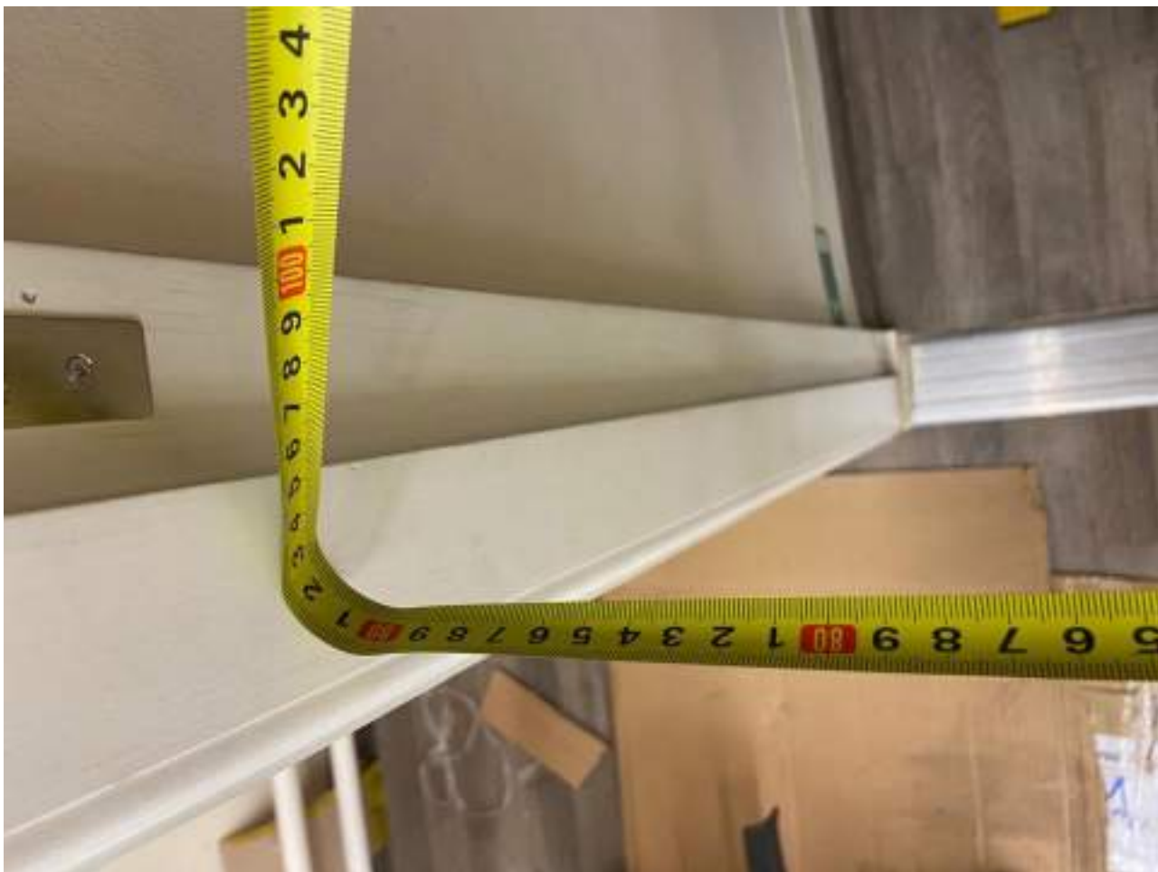
Рисунок 4.2. Ширина дверного проема в выставочном зале 90 см
