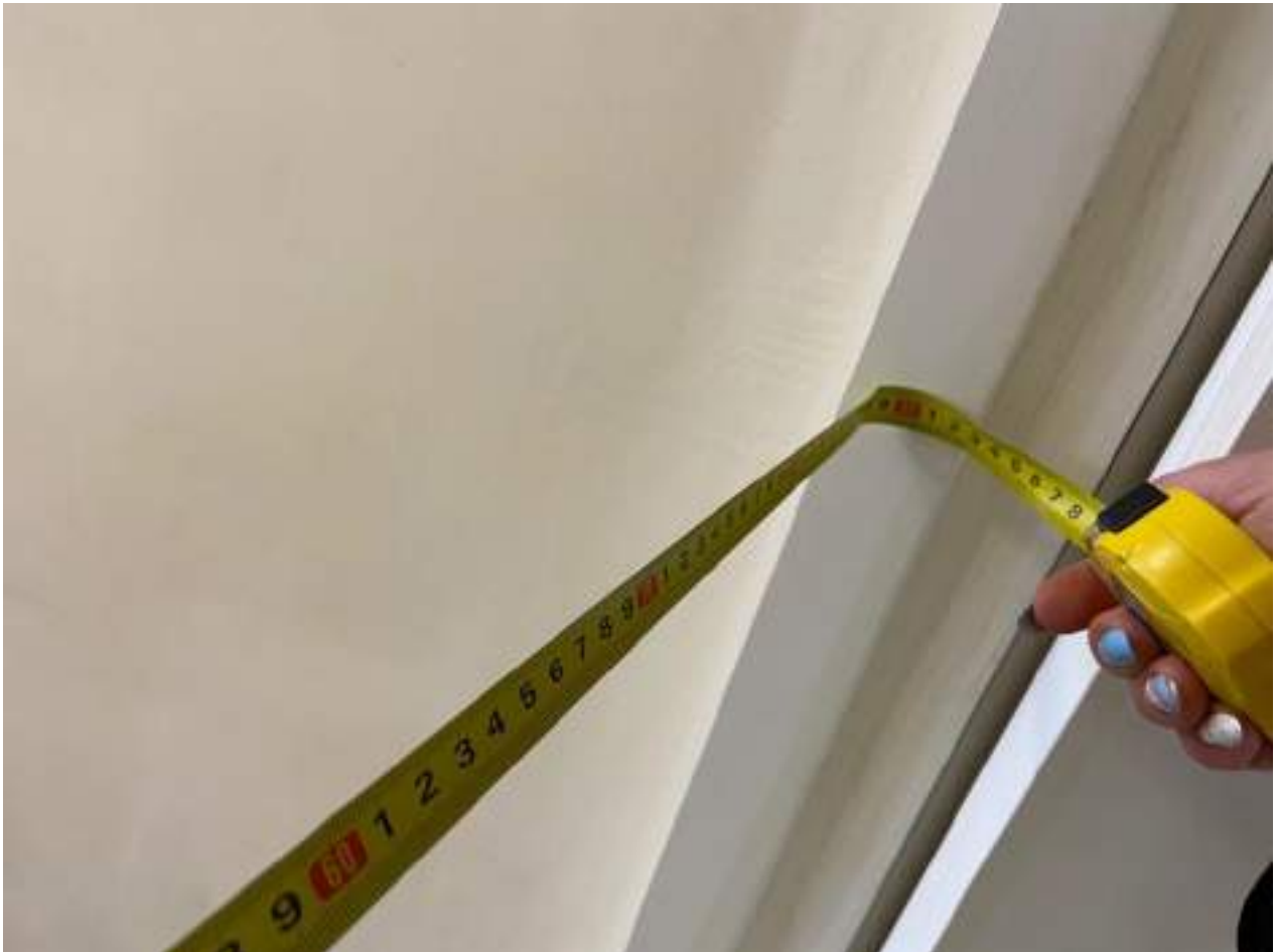
Рисунок 4.5 Дверной проем в библиотеке не соответствует норме (83 см)
