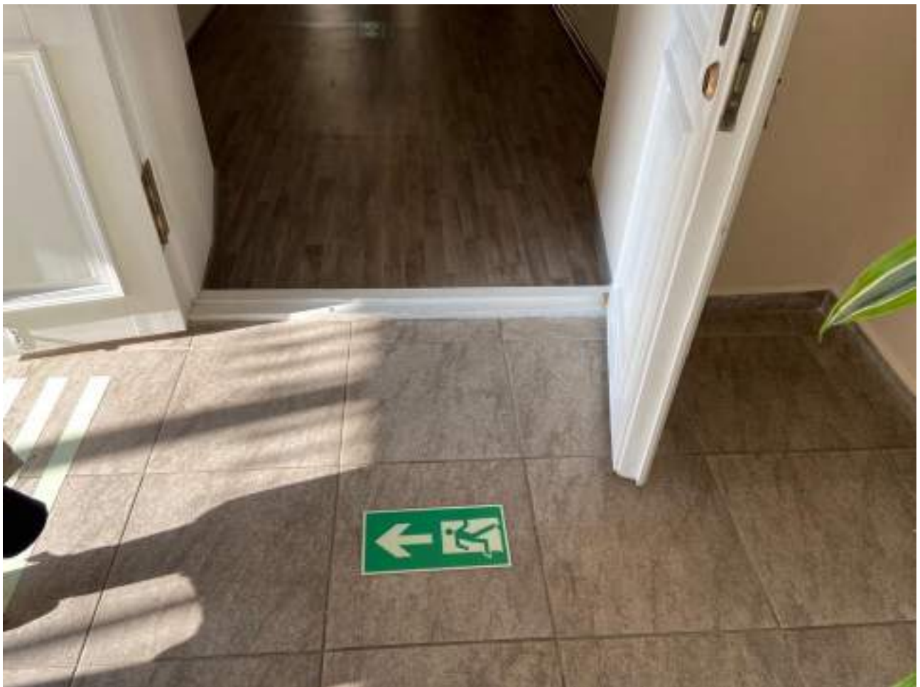
Рисунок 3.12 Дверной проем на втором этаже
