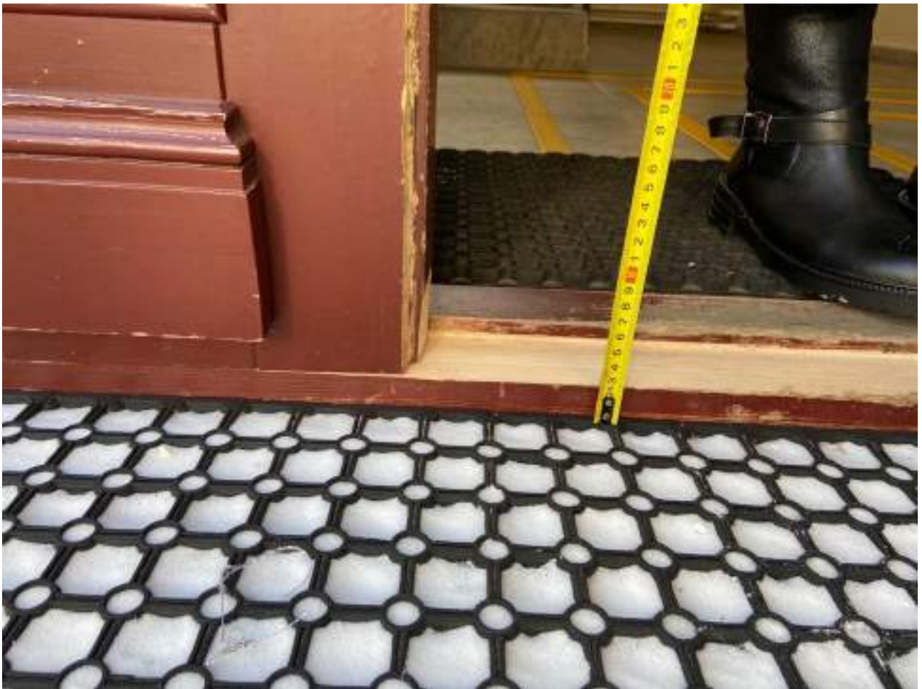
Рисунок 2.8 Высота дверного порога 6 см
