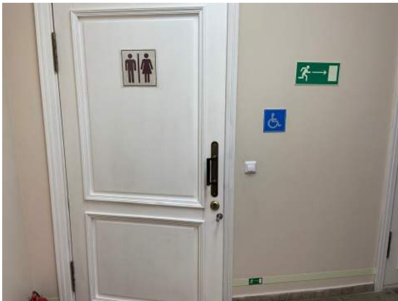
Рисунок 5.1. Вход в санузел
