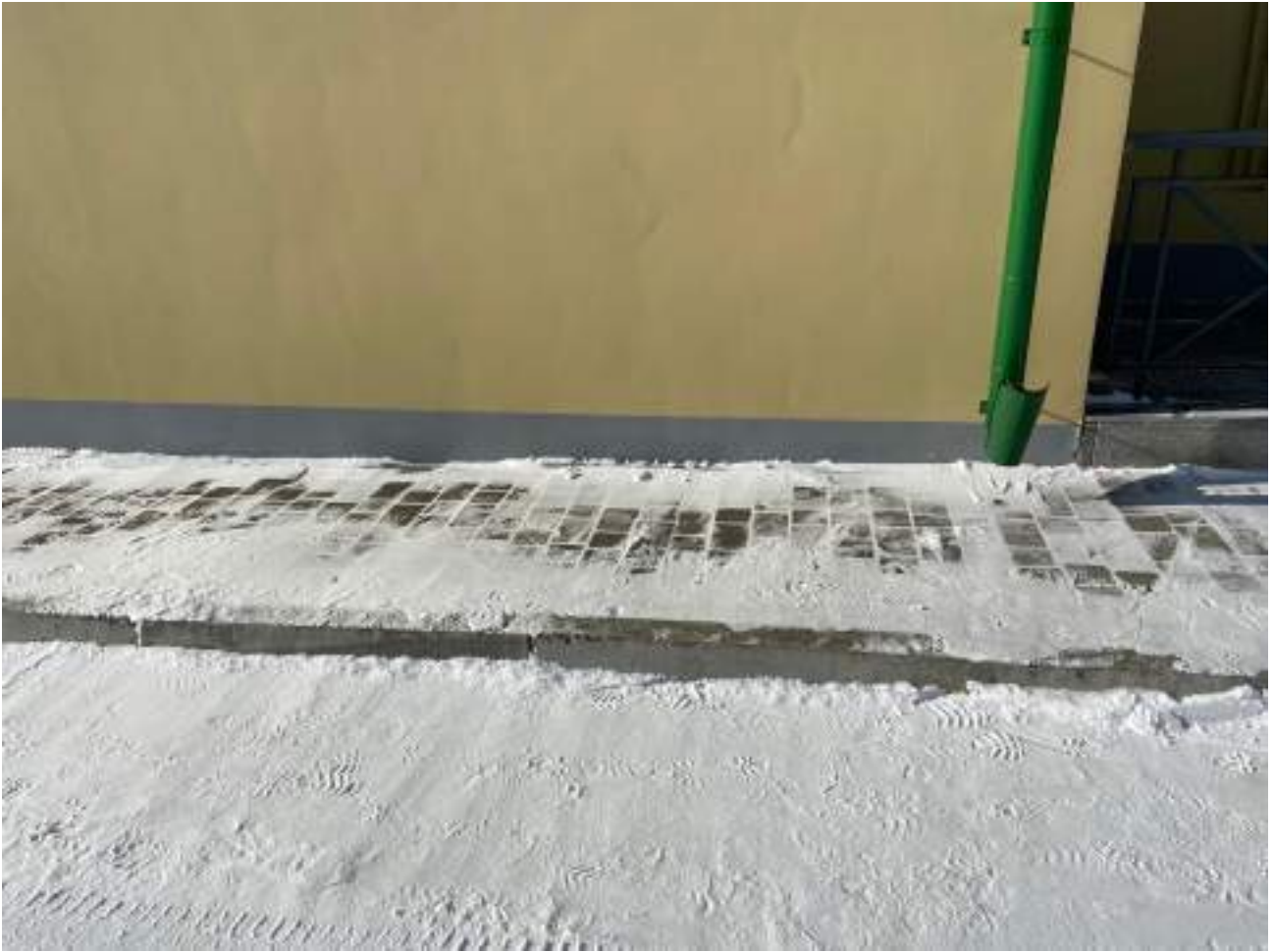
Рисунок 1.4 Отсутствует понижение бордюрного камня
