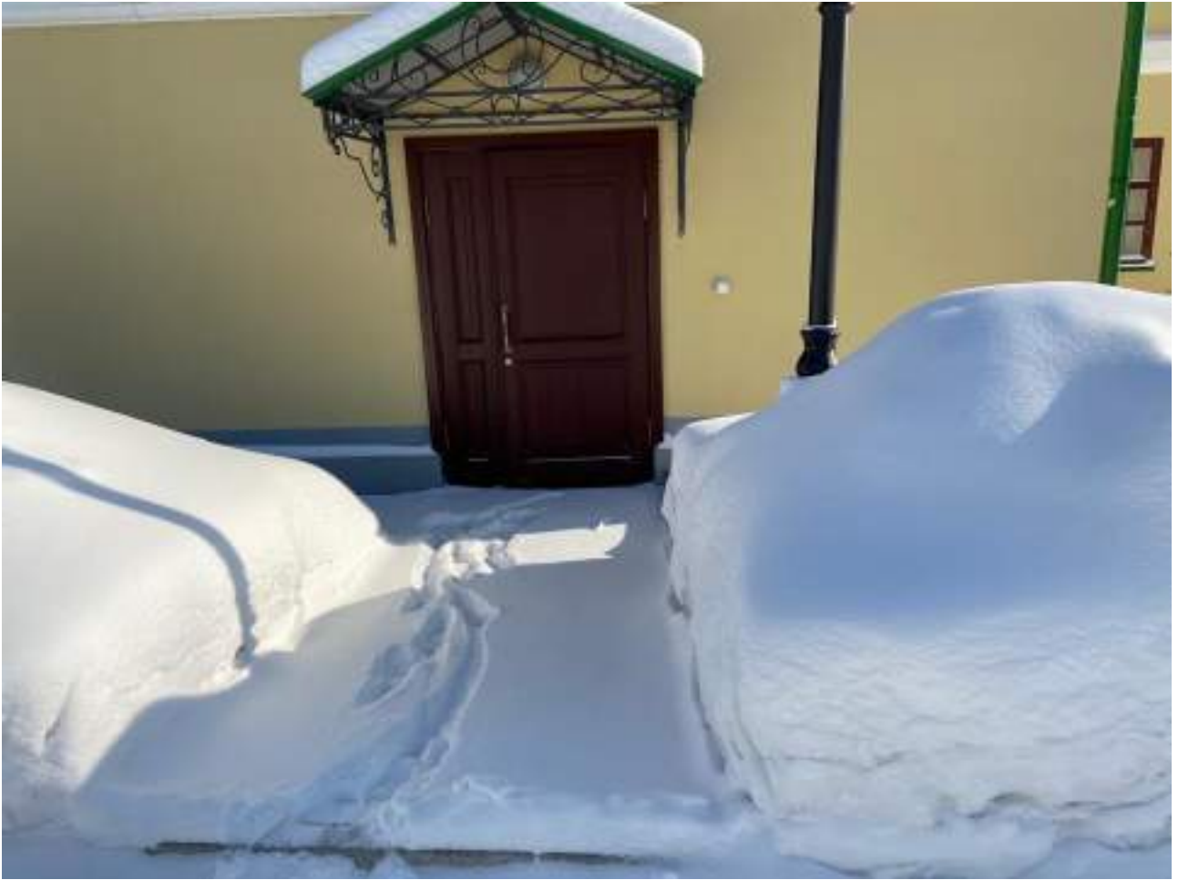
Рисунок 3.17 Эвакуационный выход. Вид с улицы
