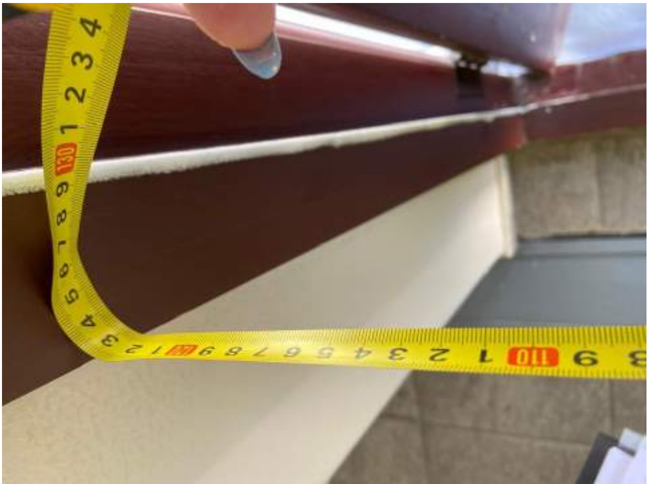
Рисунок 3.16 Ширина дверного проема эвакуационного выхода 122 см
