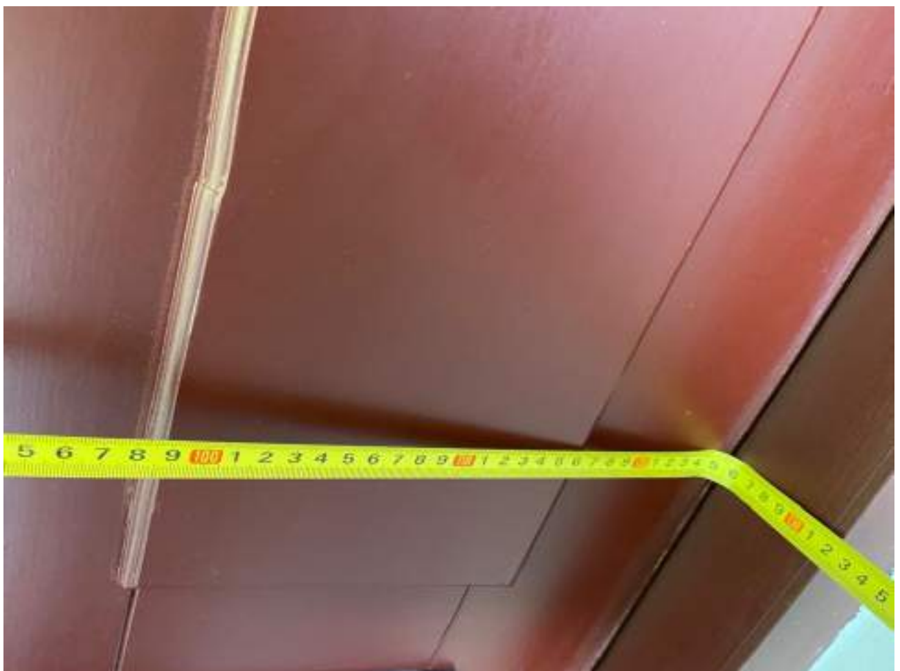
Рисунок 2.9 Ширина дверного проема соответствует норме (125 см)
