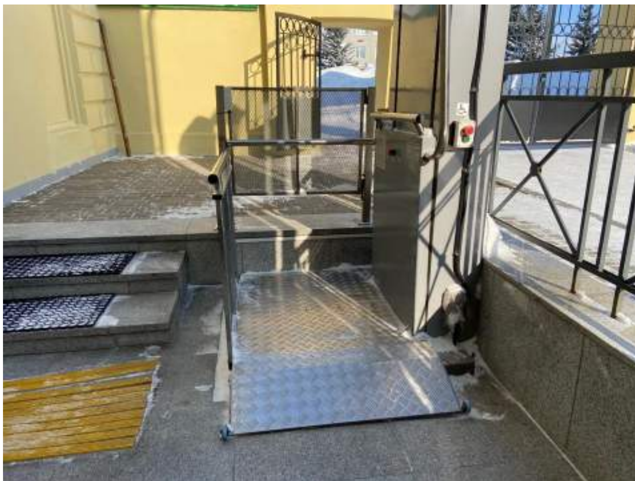
Рисунок 2.4 Подъемная платформа
