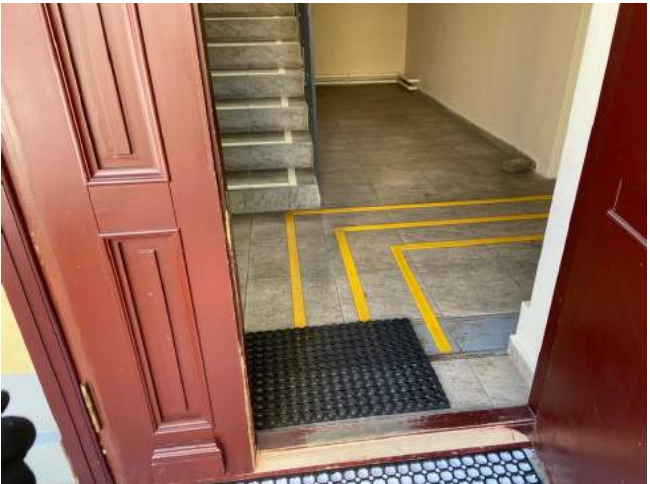
Рисунок 2.7 Дверной порог при входе в здание
