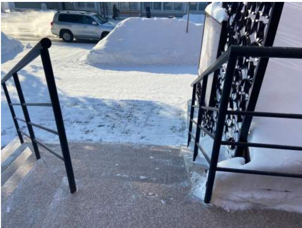
Рисунок 2.2 Лестничный марш, вид сверху
