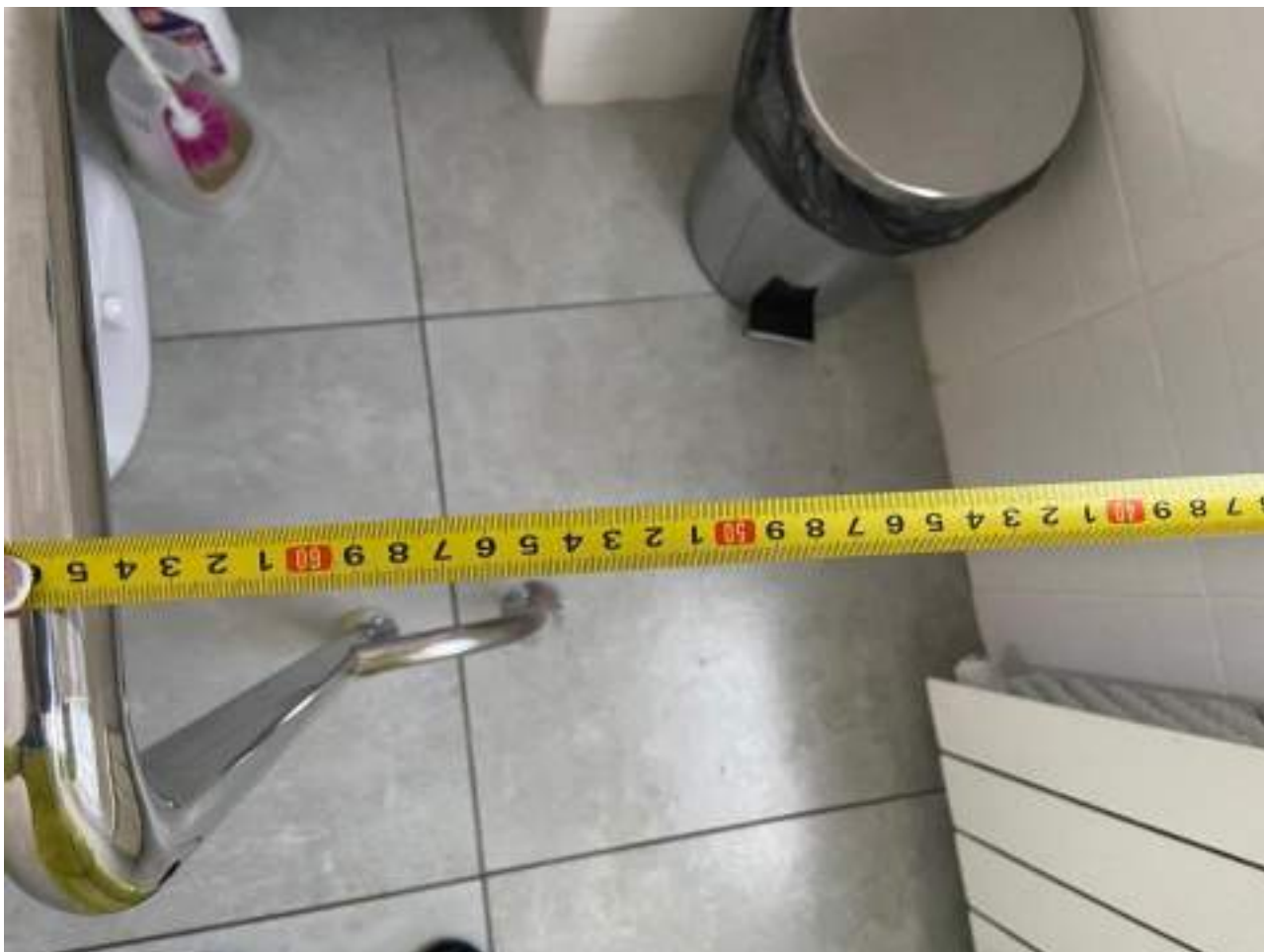
Рисунок 5.2. Сбоку от унитаза отсутствует место для размещения кресло-коляски
