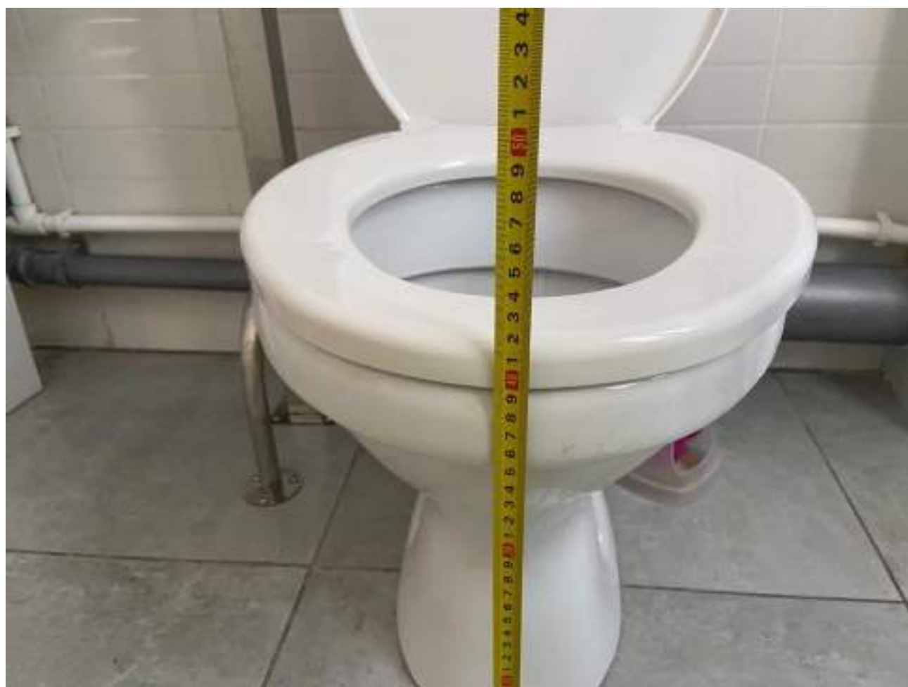
Рисунок 5.5. Высота унитаза не соответствует норме (41 см)
