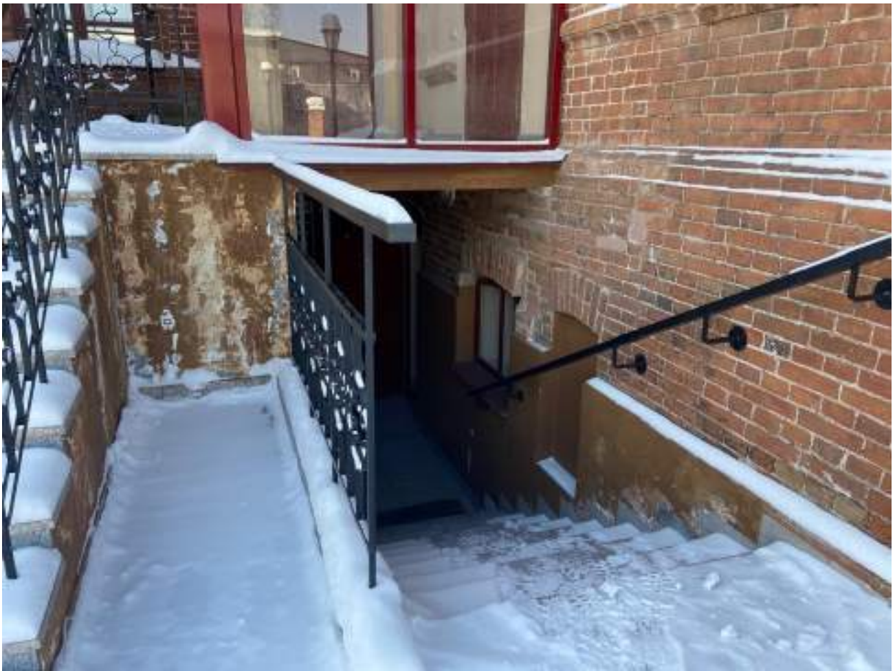
Рисунок 3.17 Эвакуационный выход. Вид с улицы
