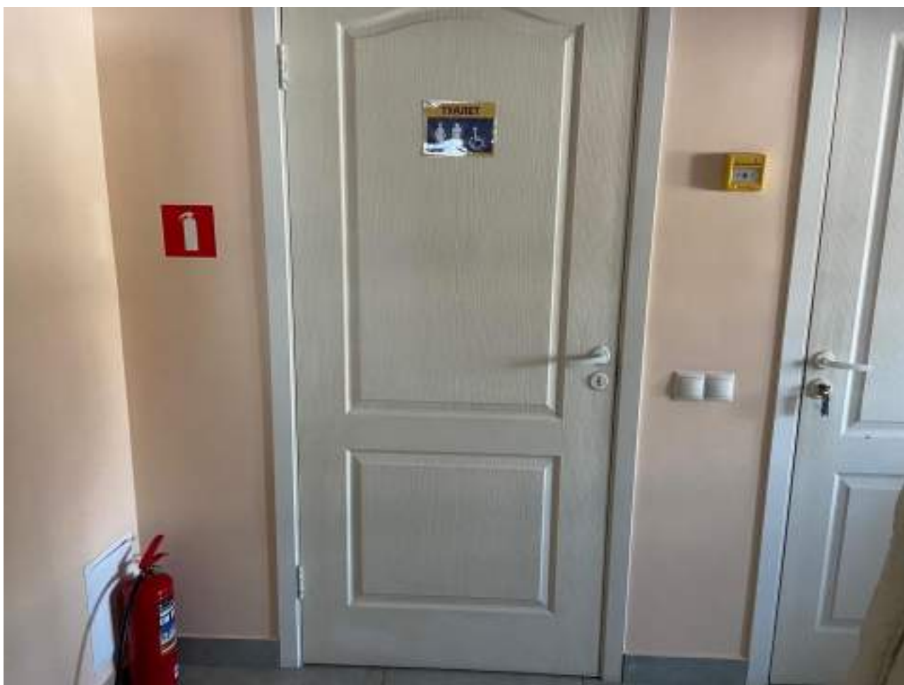
Рисунок 5.1. Вход в санузел
