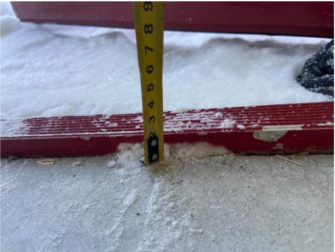
Рисунок 2.2.6 Дверной порог входной двери 2 см
