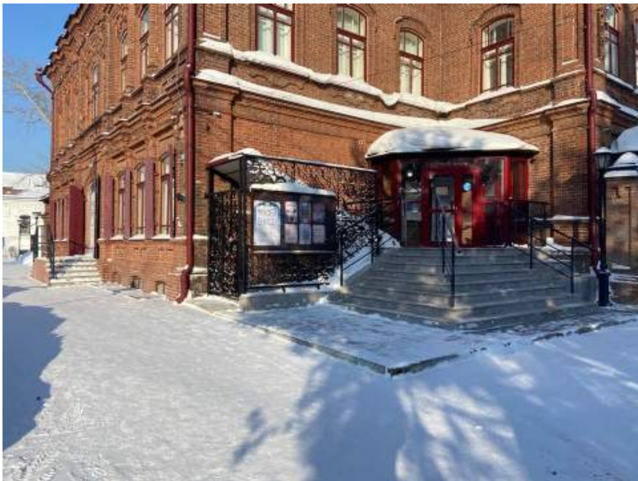
Рисунок 2.1 Лестничный марш при входе в здание
