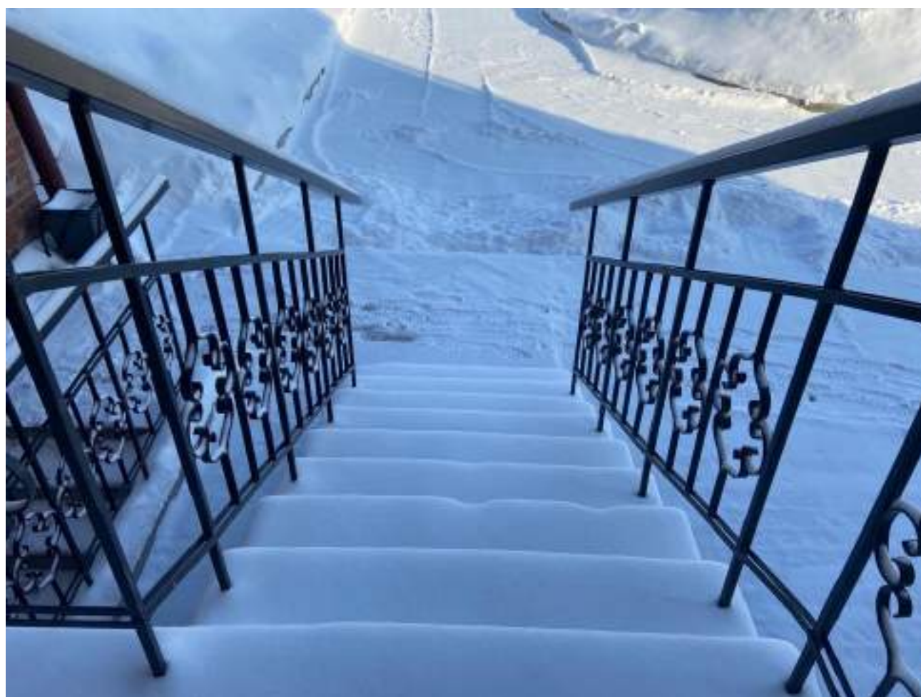
Рисунок 2.2.3 Лестничный марш. Вид сверху
