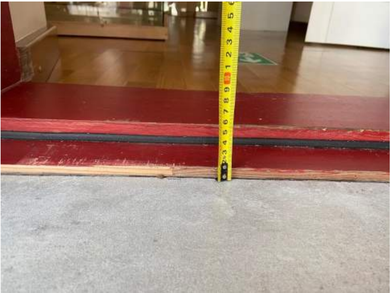
Рисунок 2.2.8 Дверной порог в тамбуре 6 см
