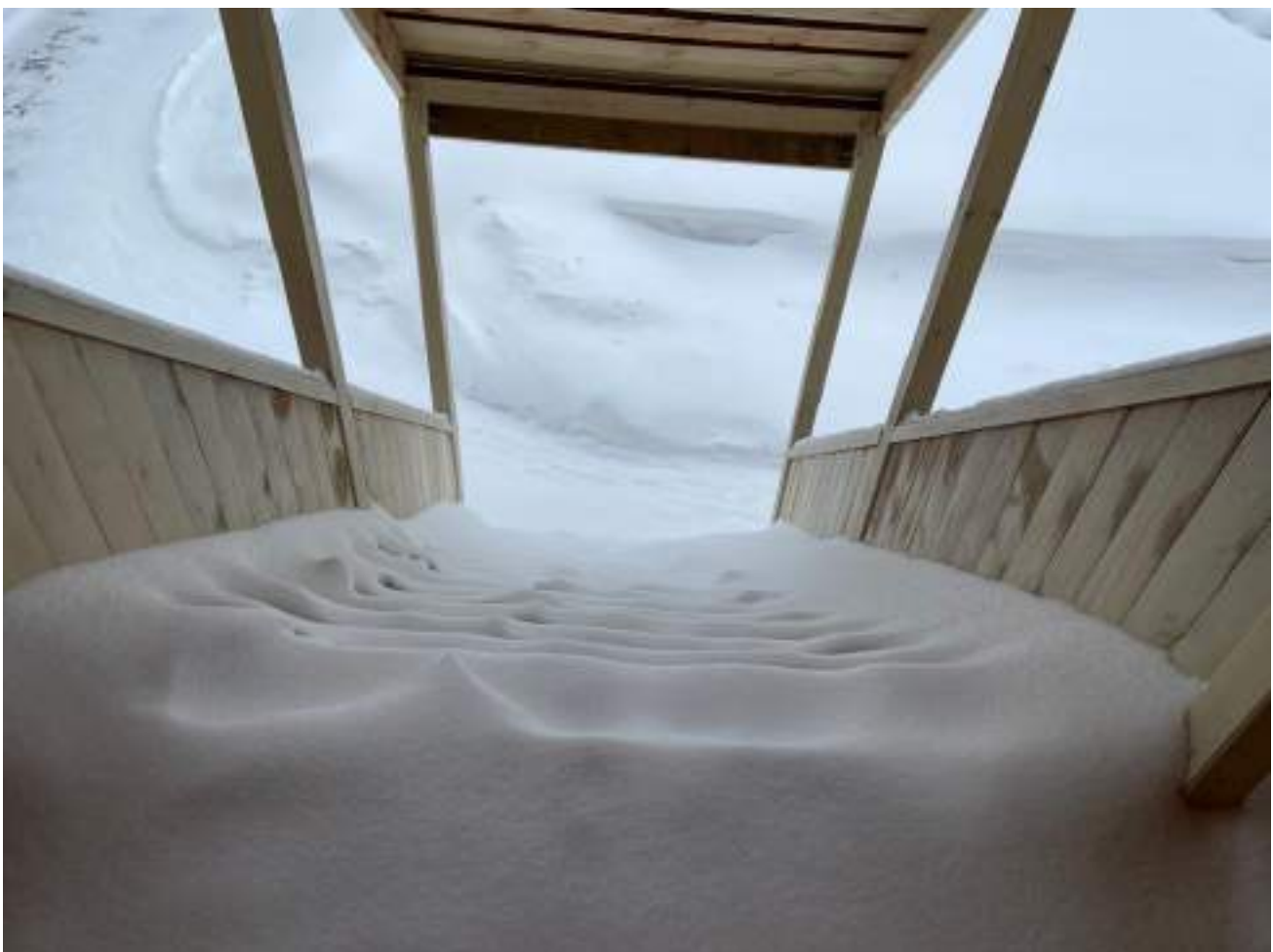
Рисунок 3.16 Лестничный марш эвакуационного выхода
