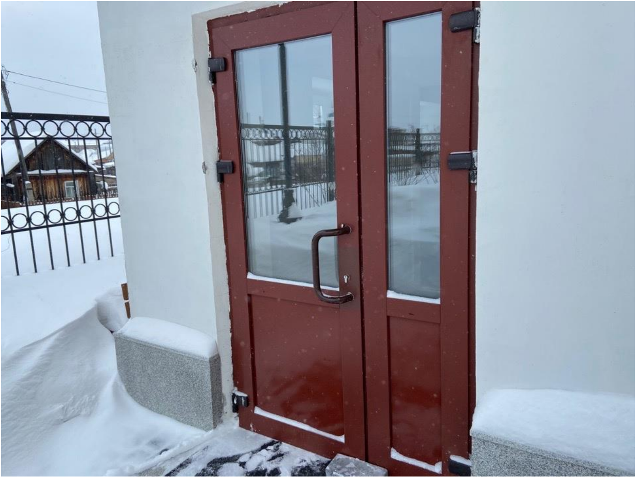
Рисунок 5.1. Вход в санузел
