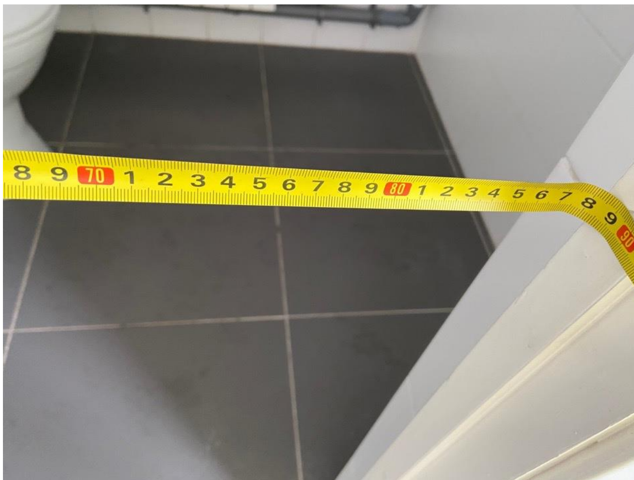
Рисунок 5.3. Ширина дверного проема в санузле 88 см
