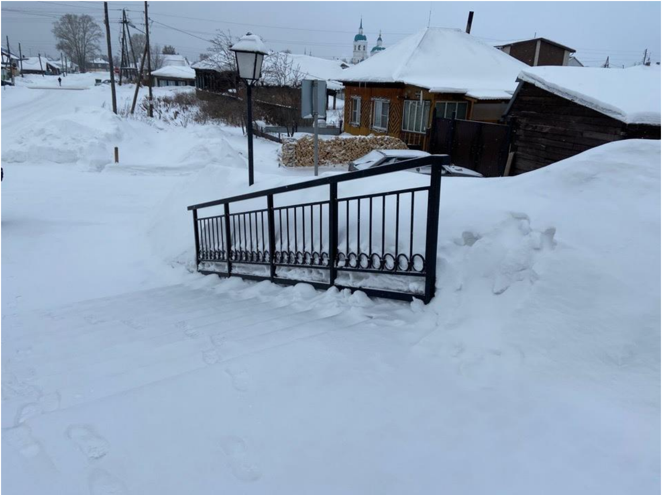
Рисунок 1.13 Лестничный марш при входе на территорию
