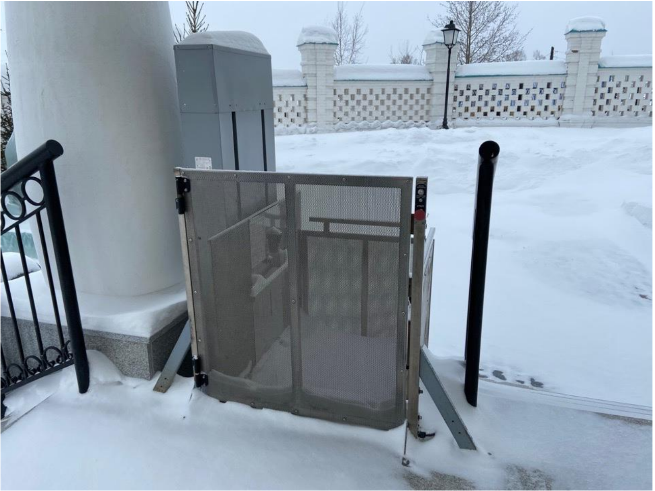
Рисунок 2.5 Подъемная платформа
