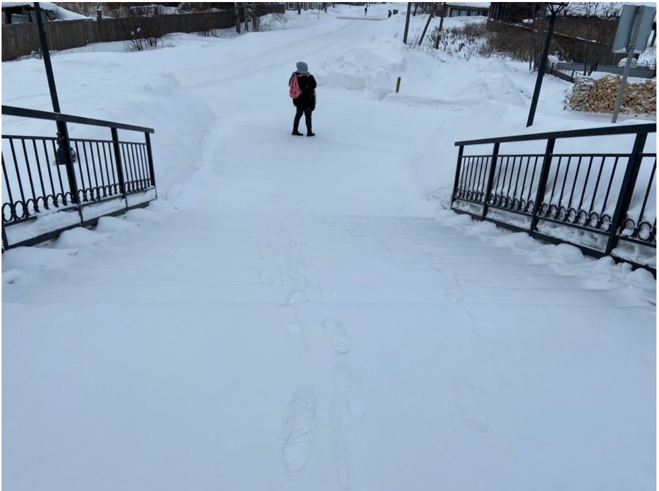
Рисунок 1.12 Лестничный марш при входе на территорию
