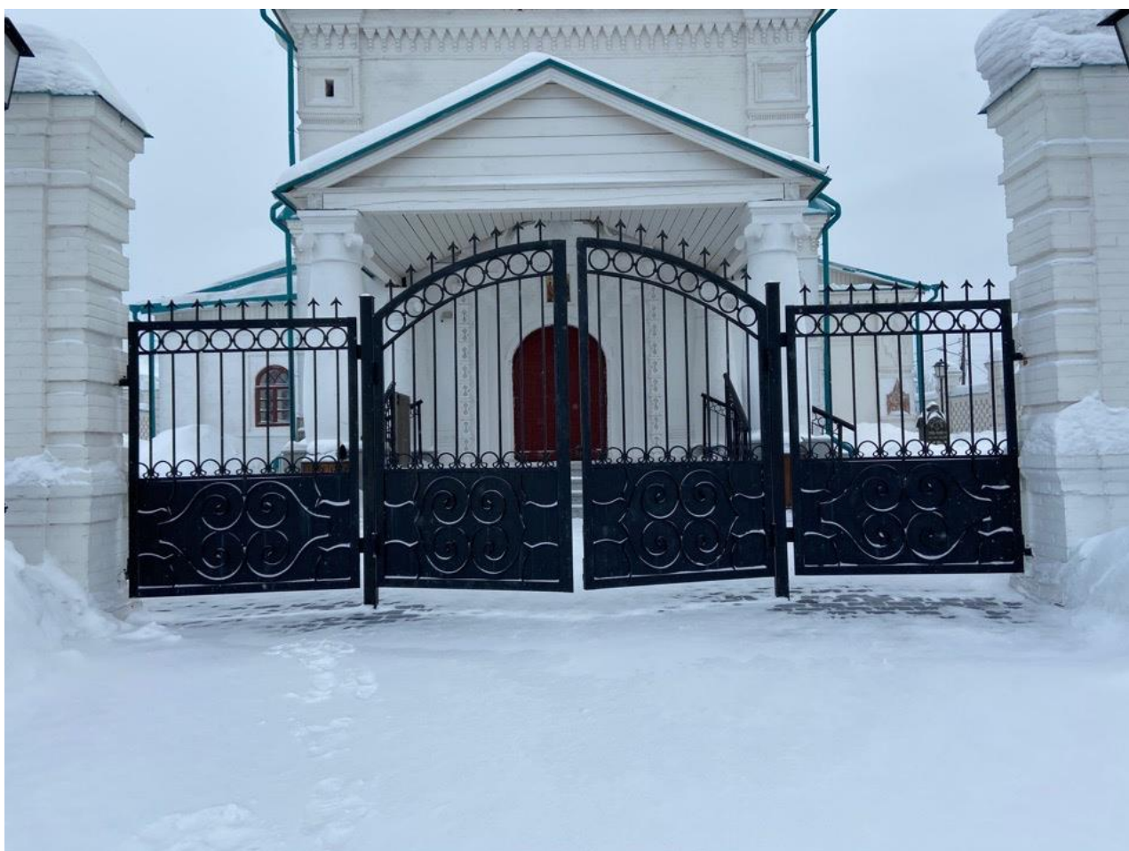
Рисунок 1.2 Центральный вход на территорию объекта
