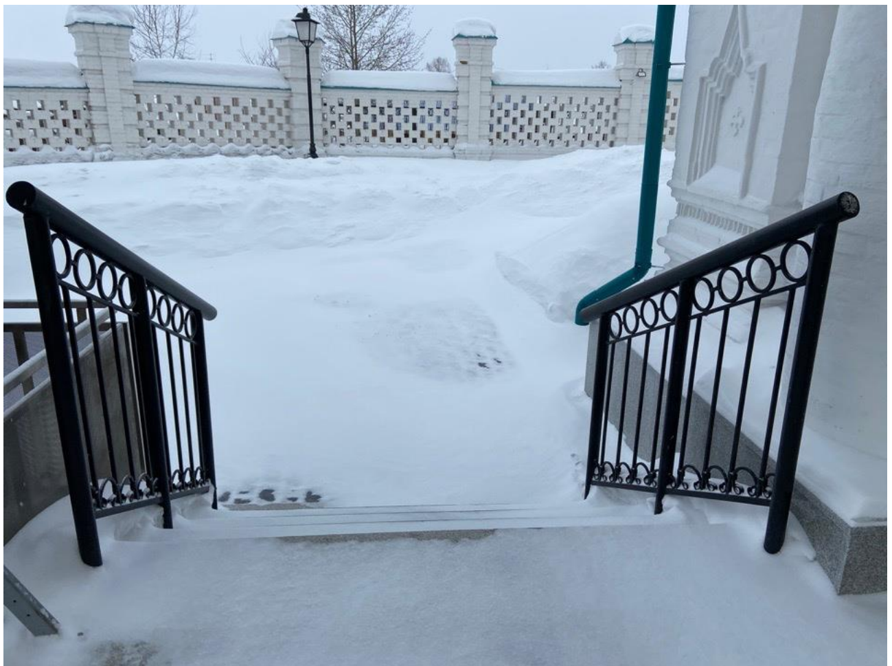
Рисунок 2.2 Лестничный марш, вид сверху
