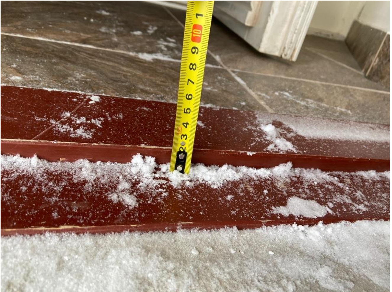
Рисунок 2.9 Дверной порог при входе 2,5 см
