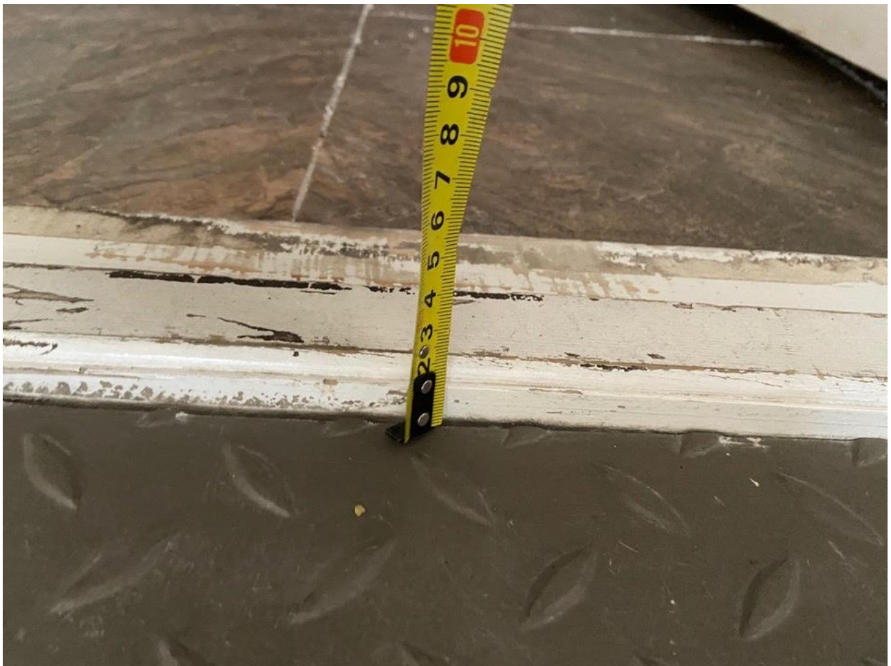
Рисунок 3.13 Высота порога эвакуационного выхода 3 см
