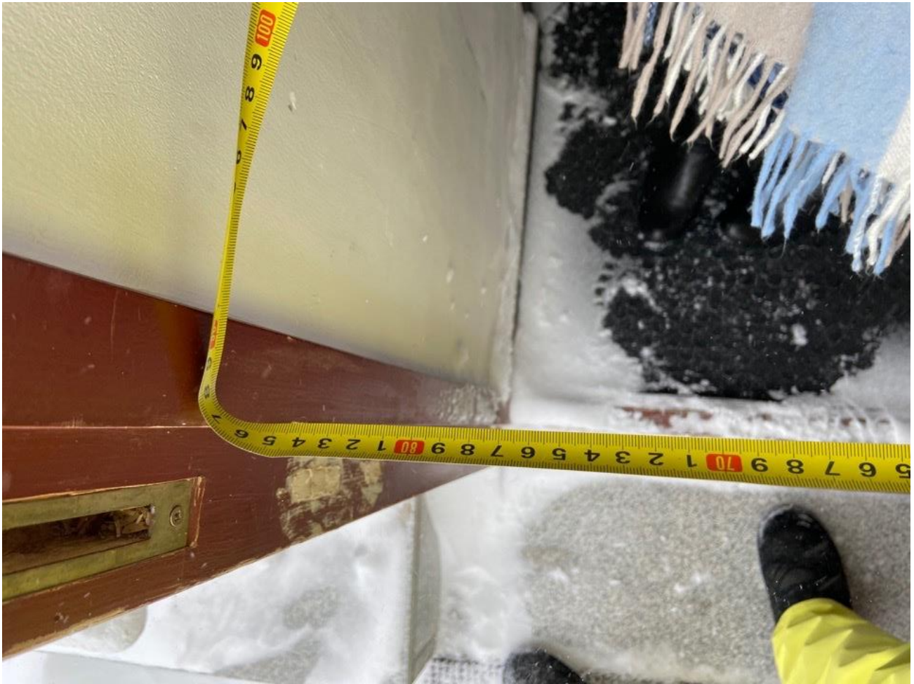
Рисунок 3.12 Ширина эвакуационного выхода 86 см
