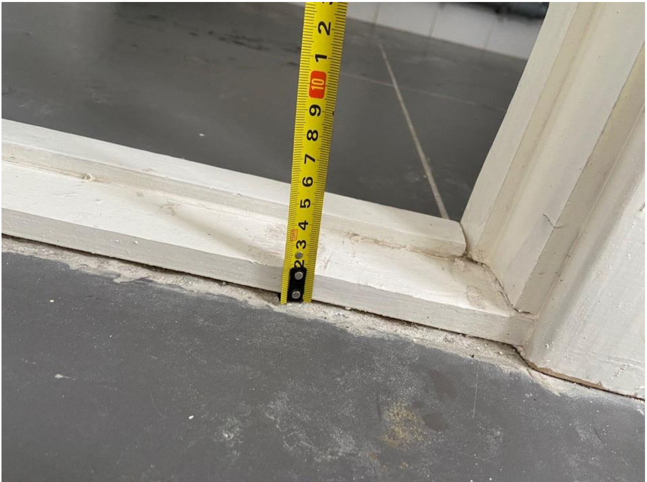
Рисунок 5.2. Высота дверного порога в санузле 3 см
