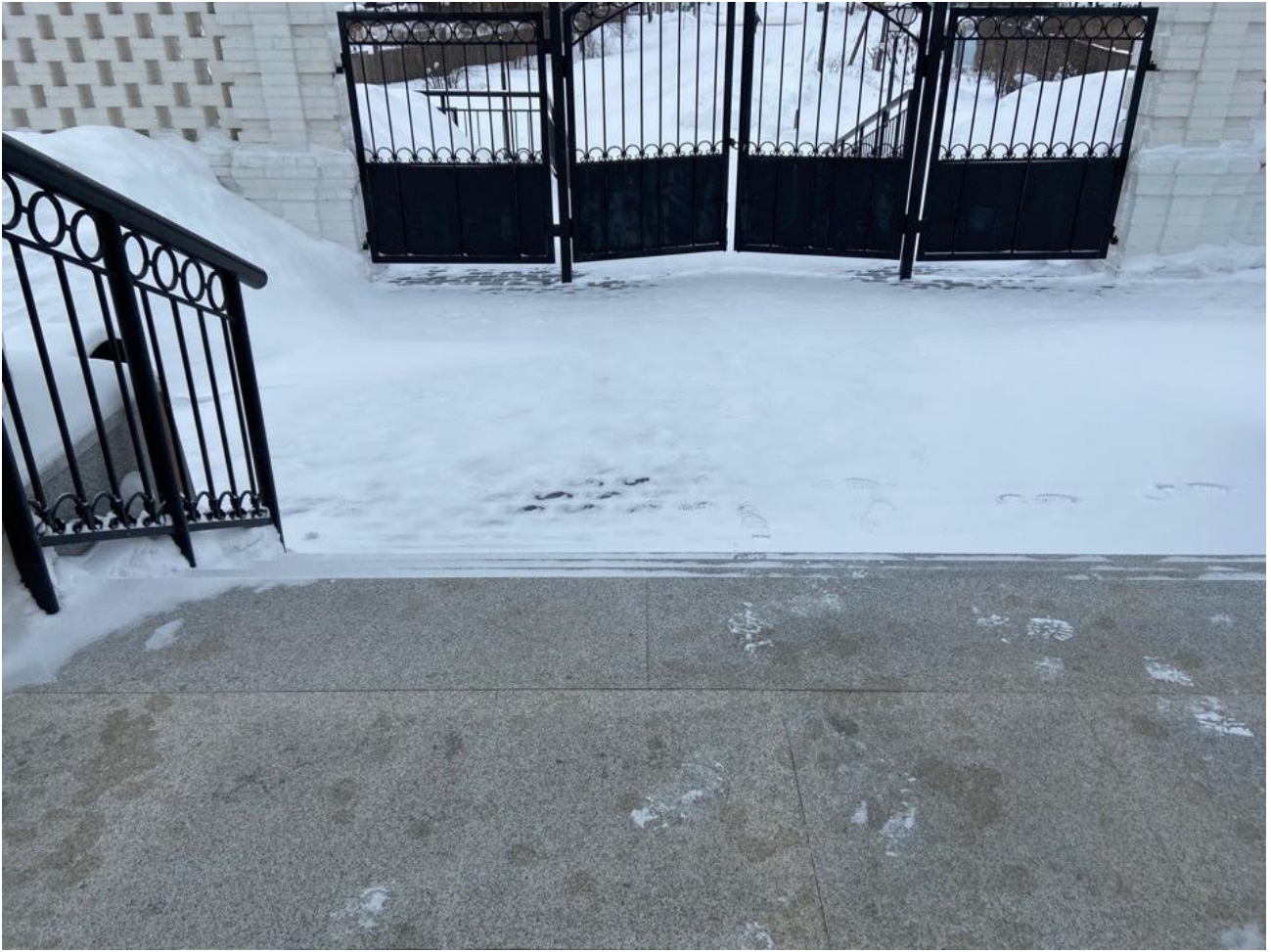
Рисунок 2.3 Лестничный марш, вид сверху
