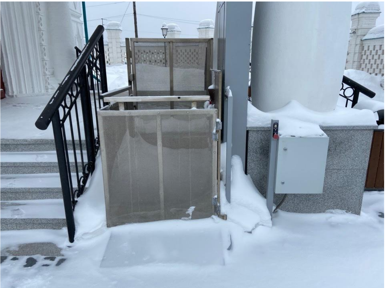
Рисунок 2.6 Подъемная платформа
