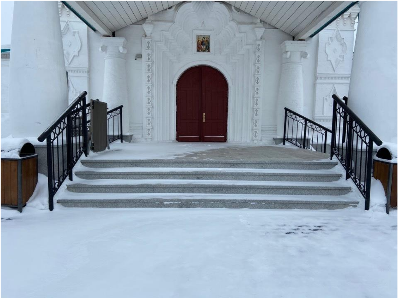
Рисунок 2.1 Лестничный марш при входе в здание
