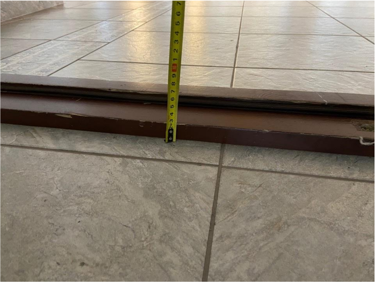
Рисунок 3.5 Дверной порог на путях движения 5 см
