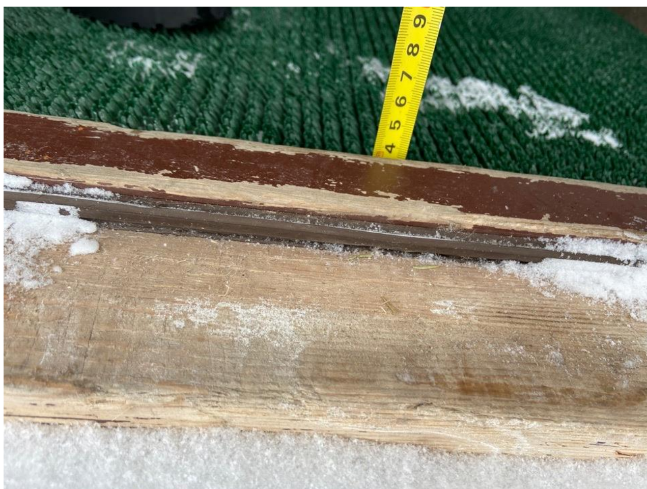
Рисунок 2.7 Дверной порог 3,5 см
