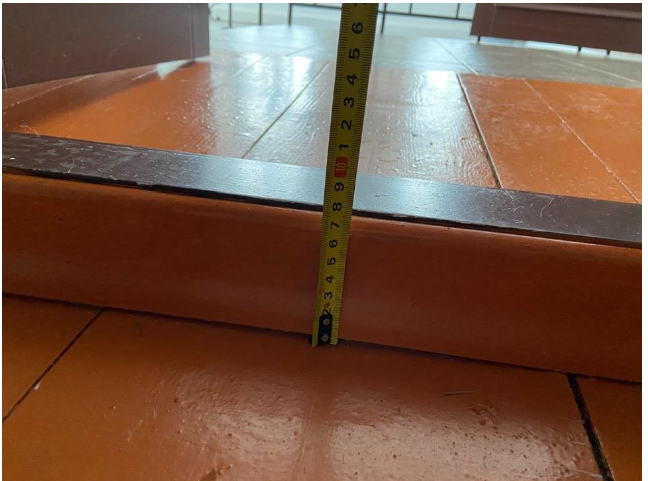
Рисунок 4.3. Дверной порог в выставочном зале на втором этаже 8 см
