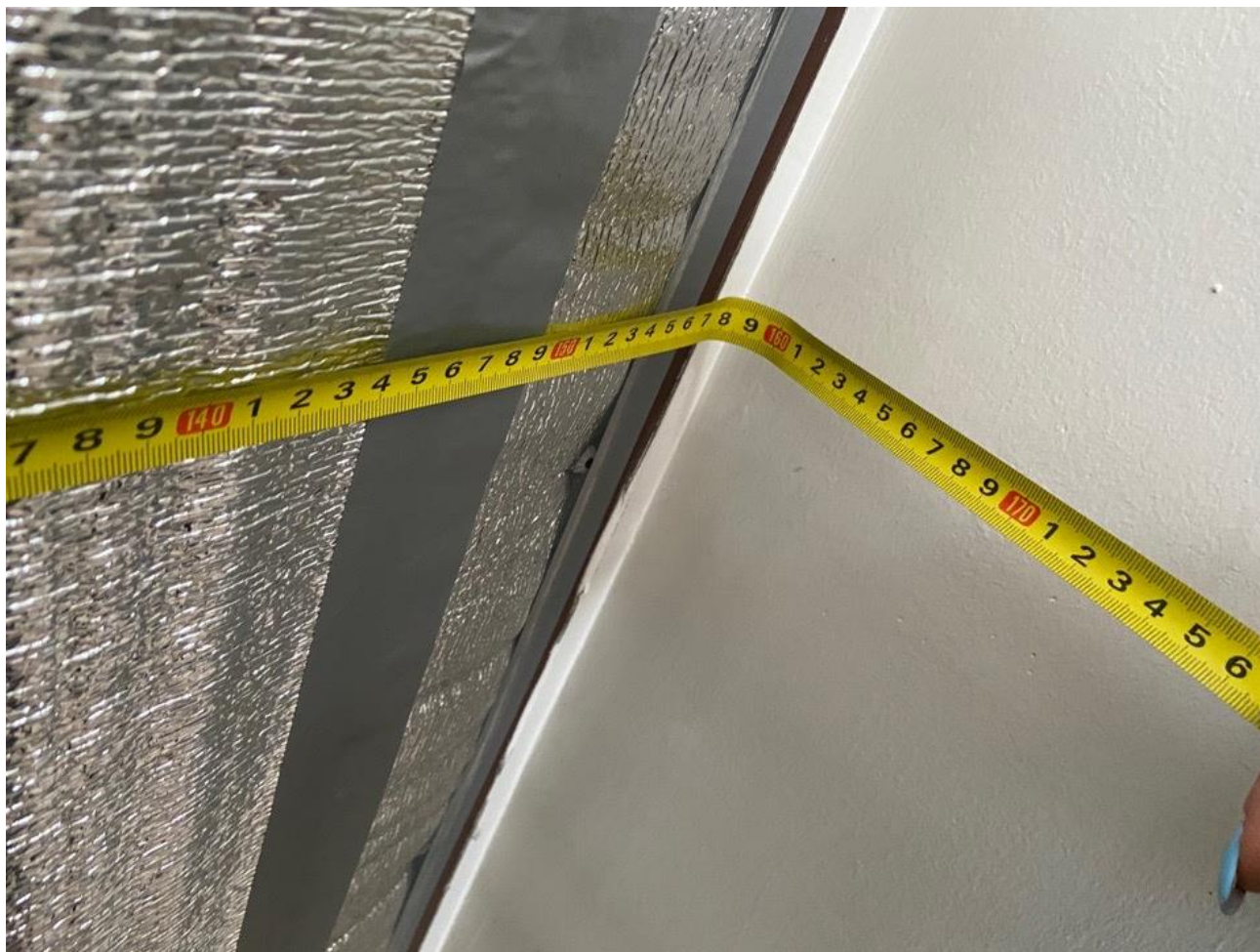
Рисунок 3.17 Ширина дверного проема эвакуационного выхода 155 см
