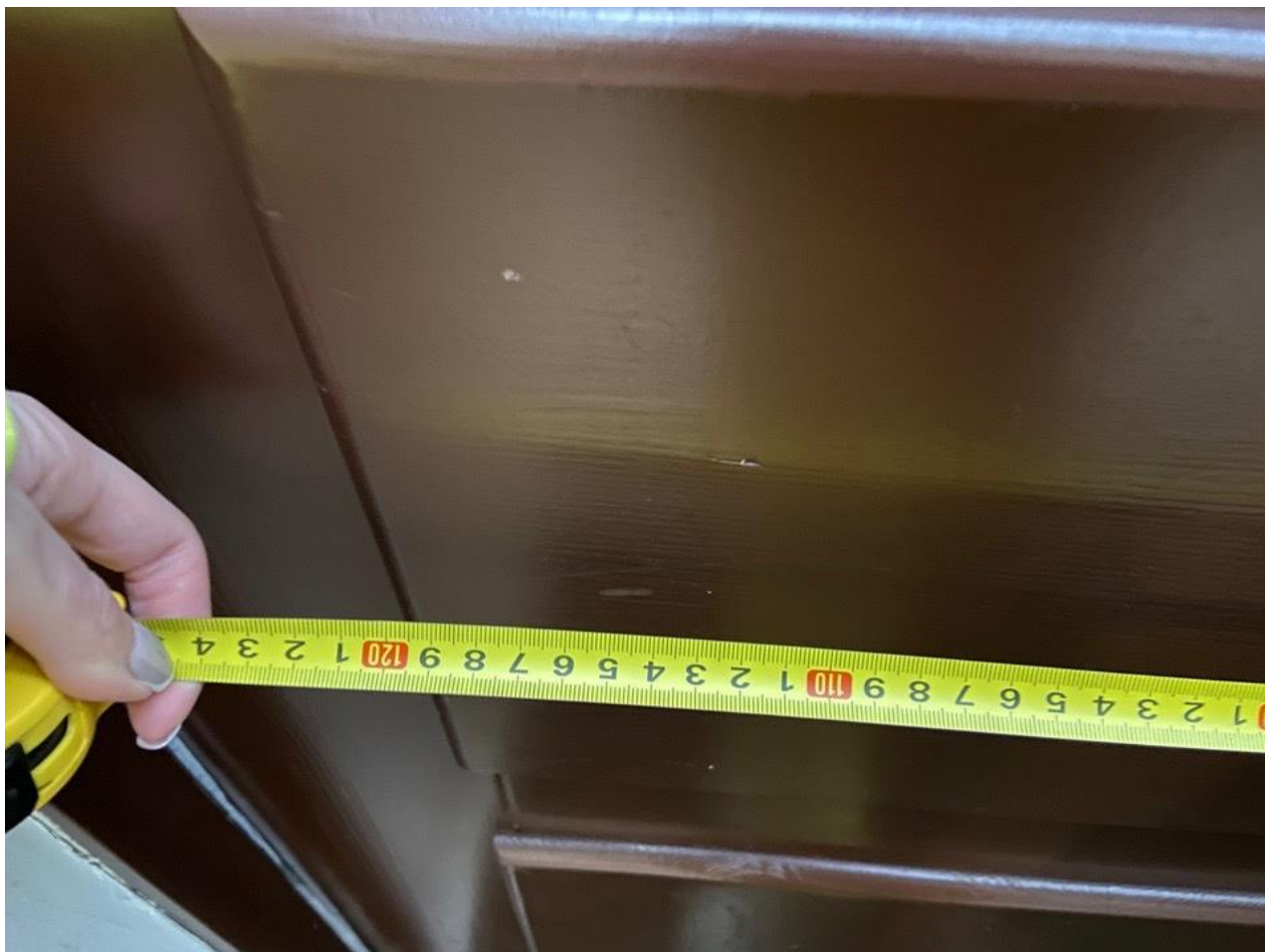
Рисунок 2.6 Ширина дверного проема 124 см
