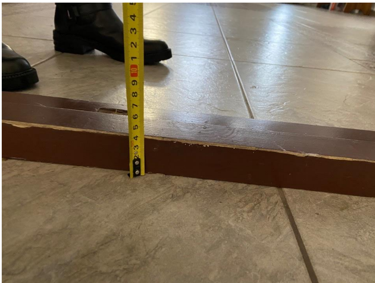
Рисунок 3.15 Дверной порог при выходе на лестничную площадку 4 см
