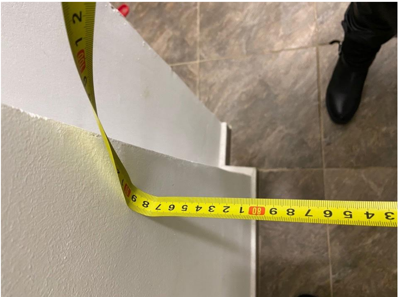
Рисунок 5.2. Ширина дверного проема в санузле 87 см
