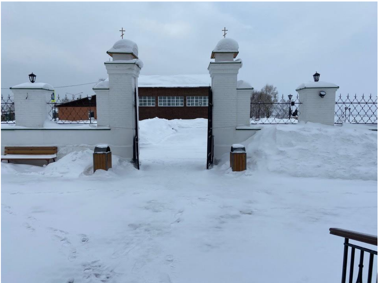
Рисунок 1.3 Вход на территорию. Вид со стороны объекта
