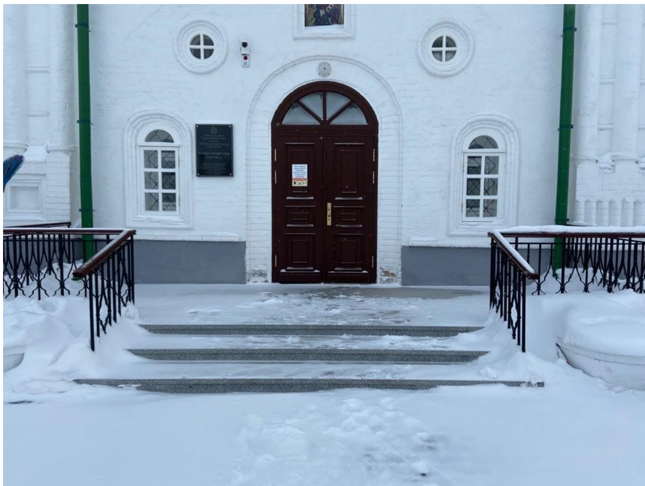
Рисунок 2.1 Лестничный марш при входе в здание
