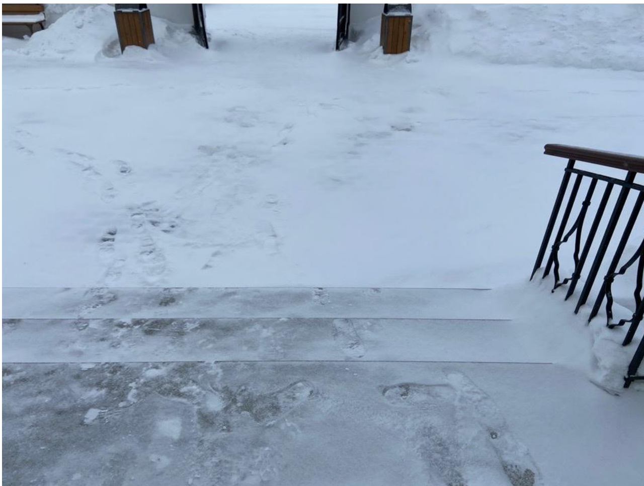
Рисунок 2.2 Лестничный марш, вид сверху
