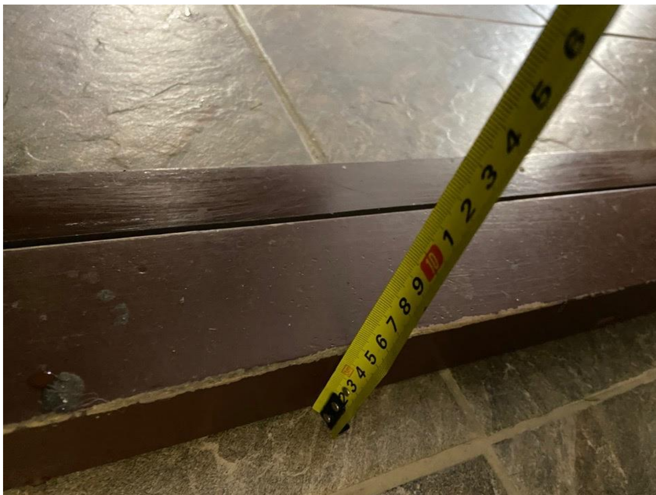
Рисунок 5.3. Высота дверного порога 4,5 см
