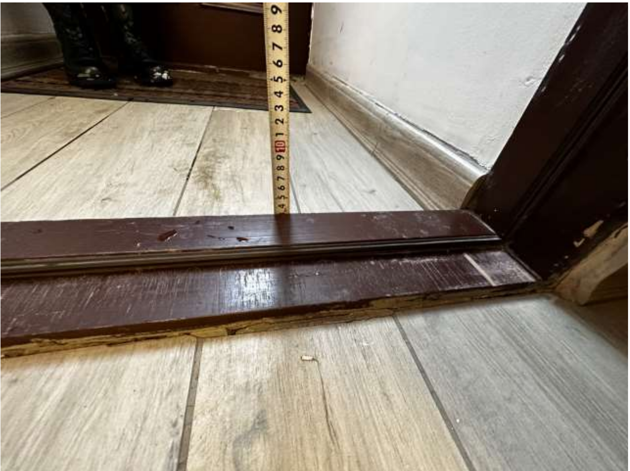
Рисунок 2.1.5 Высота порога 3 см
