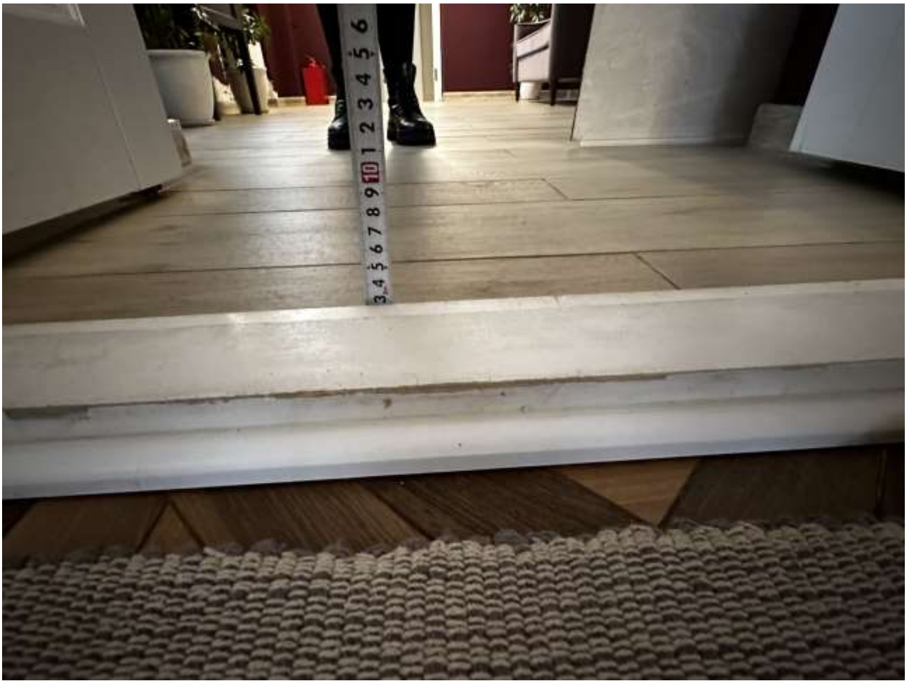
Рисунок 4.2.3 Высота порога 3 см
