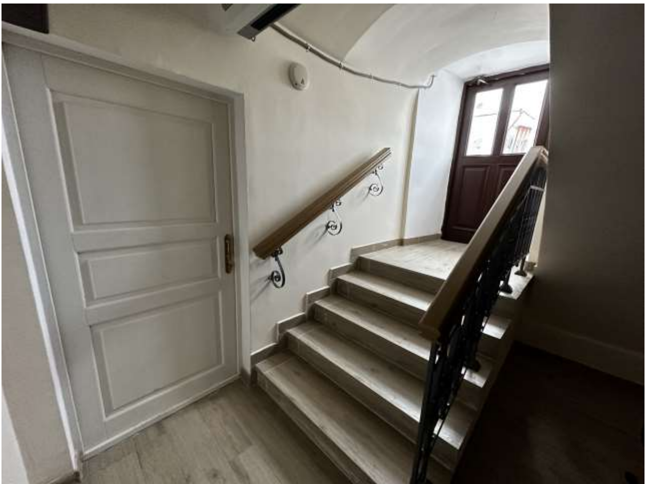
Рисунок 3.34 Лестничный марш на путях эвакуации
