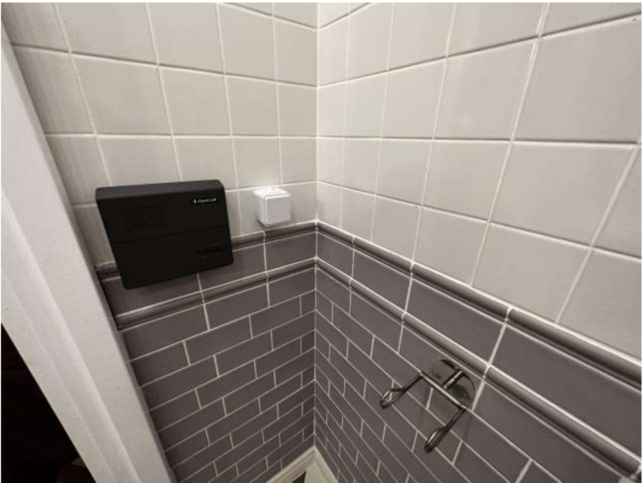
Рисунок 4.2.13 Система вызова персонала в санузле
