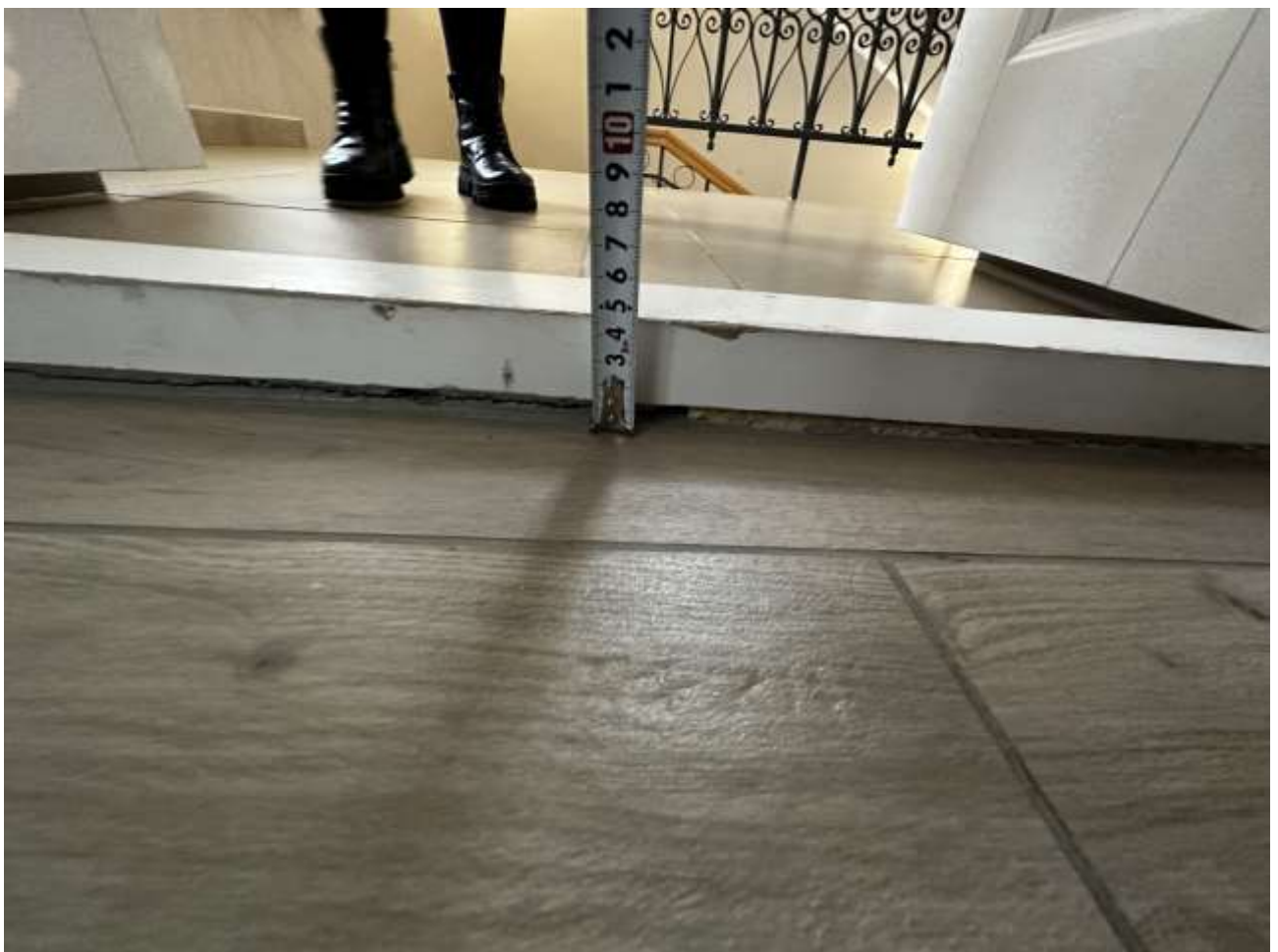
Рисунок 3.24 Высота порога 5 см
