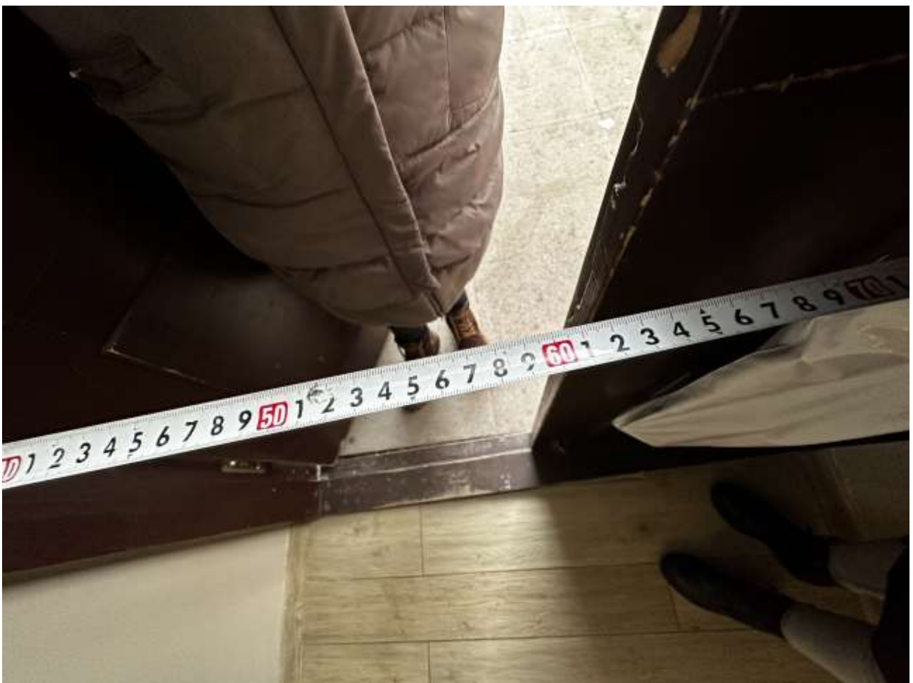
Рисунок 2.2.6 Ширина одной створки 61 см
