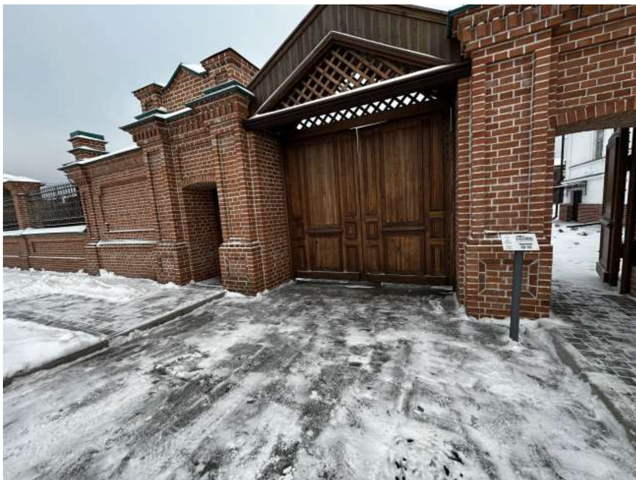
Рисунок 1.1 Вид на территорию объекта
