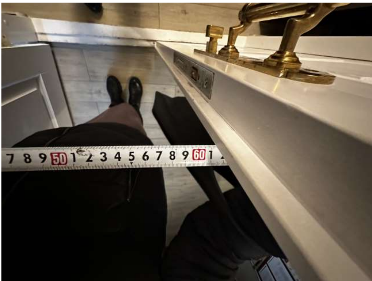
Рисунок 2.2.9 Ширина одной створки 61 см
