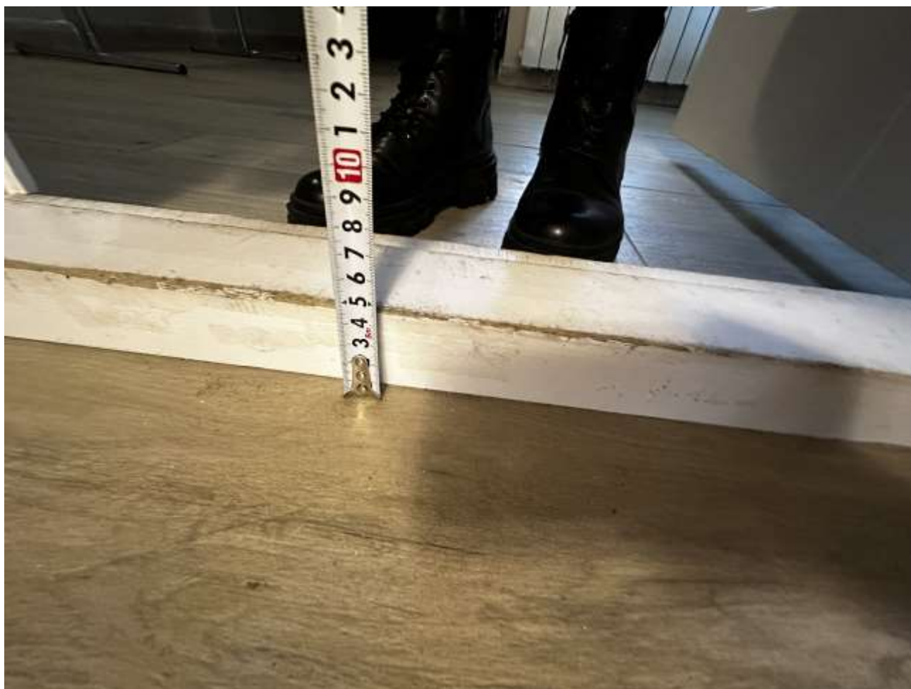
Рисунок 2.2.11 Высота порога 5 см
