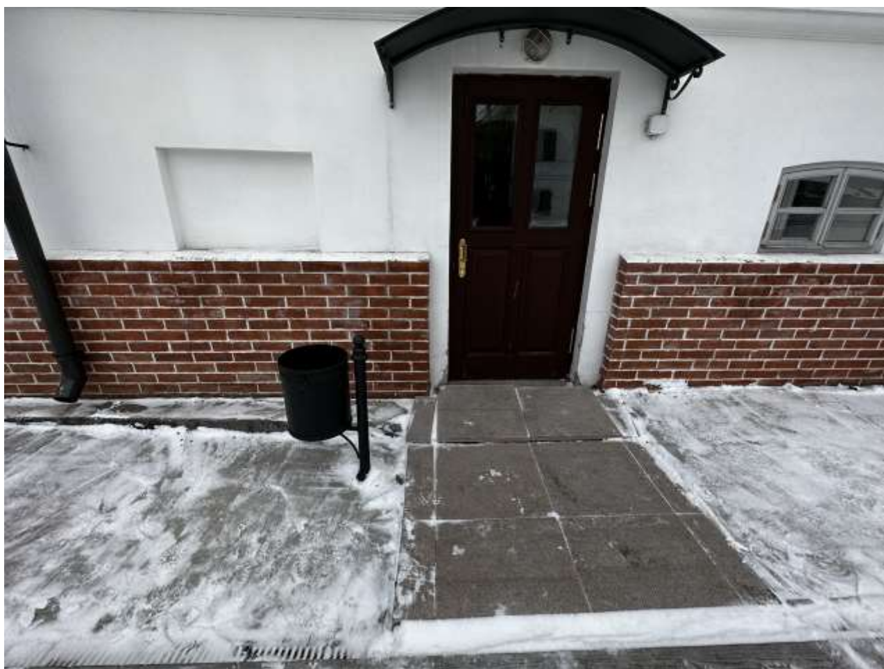
Рисунок 3.30 Эвакуационный выход №2. Вид с улицы
