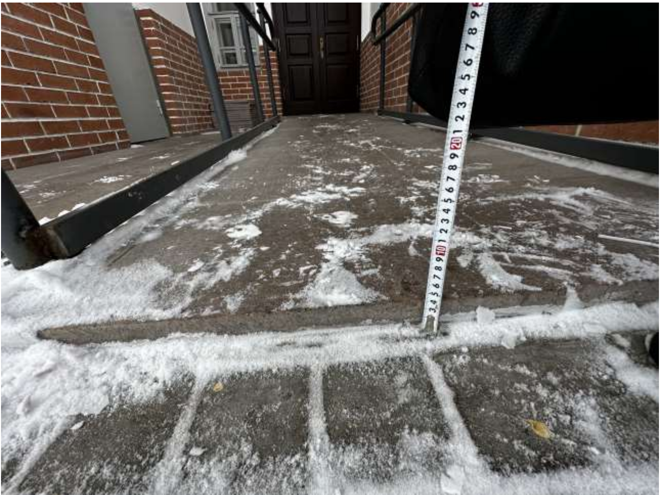
Рисунок 2.2.3 Высота препятствия 4 см
