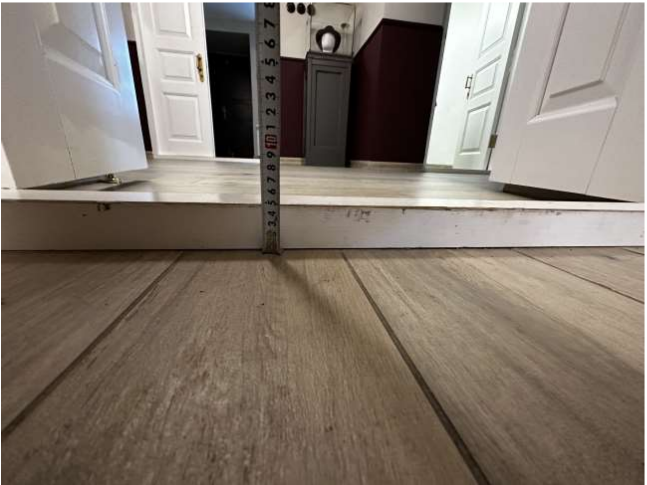
Рисунок 3.21 Высота порога 5 см
