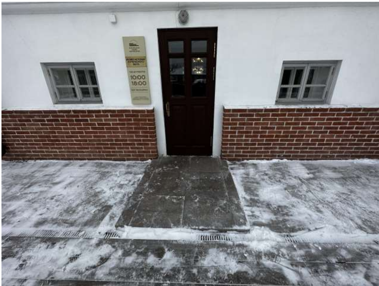
Рисунок 2.1.1 Вход в здание
