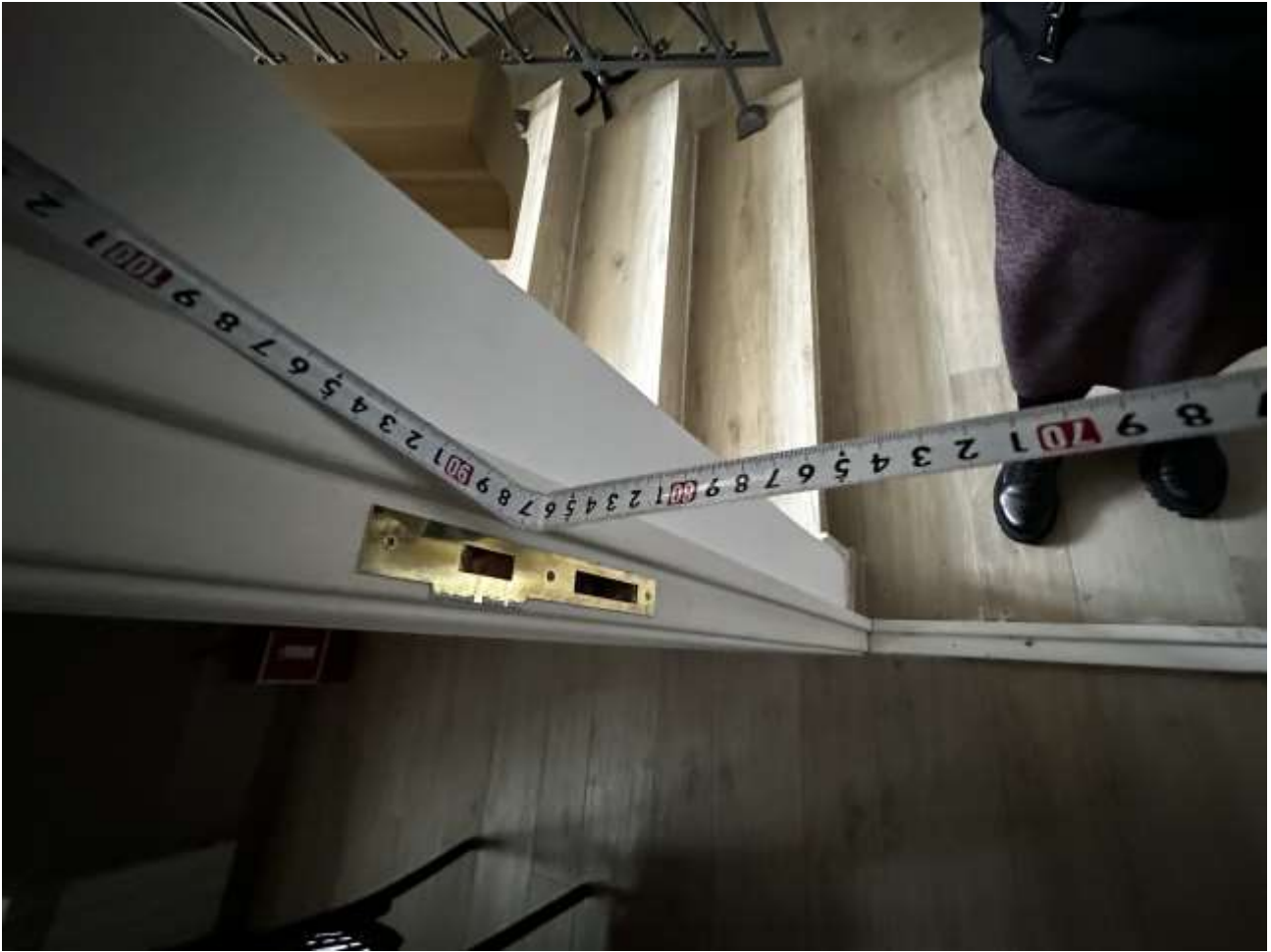
Рисунок 3.33 Эвакуационный выход №2. Ширина дверного проема 86 см
