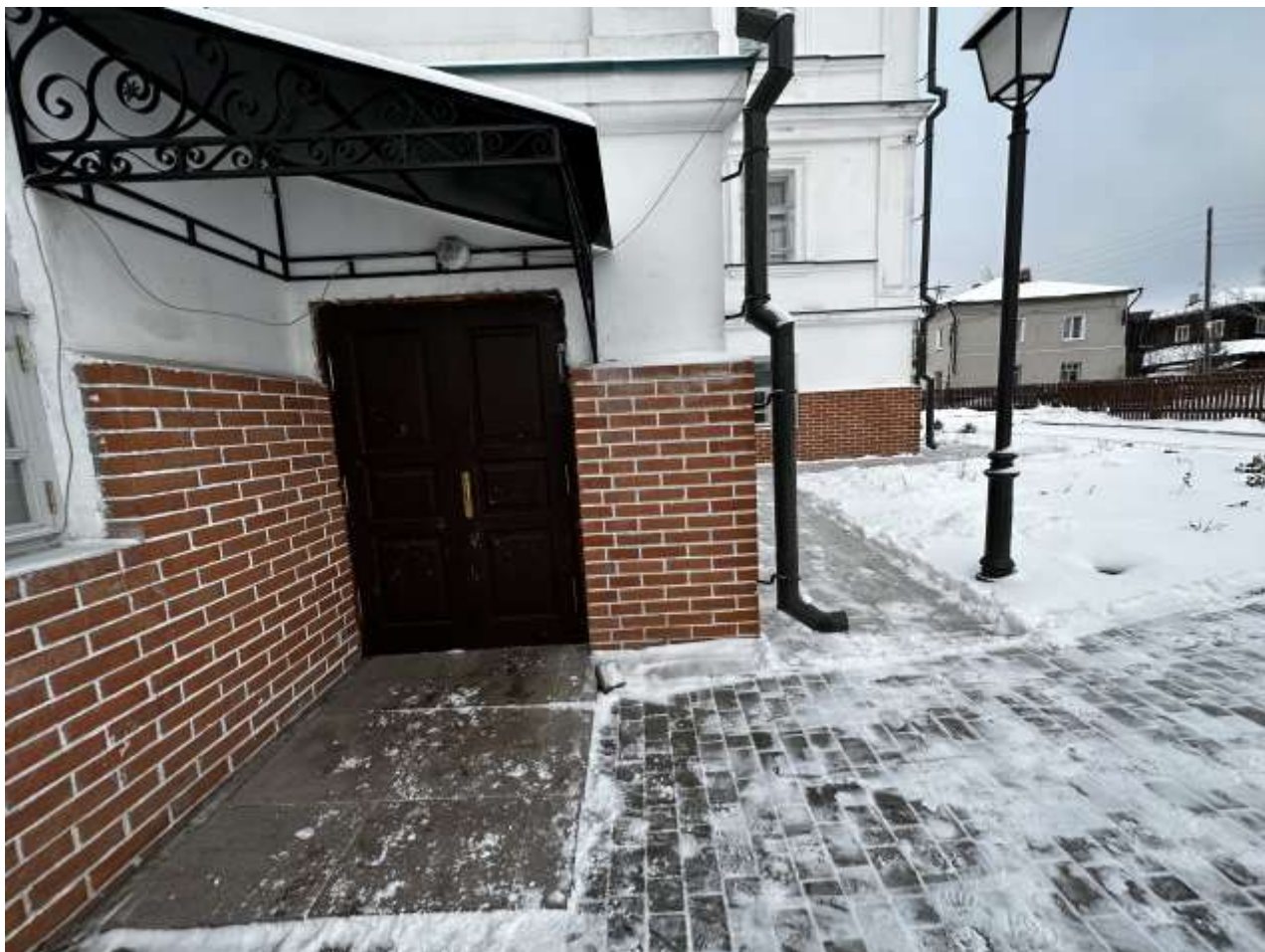
Рисунок 3.29 Эвакуационный выход. Вид с улицы
