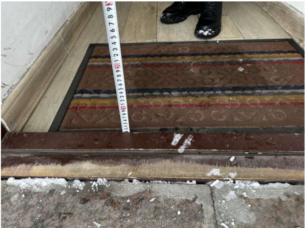
Рисунок 2.1.3 Высота порога 2 см
