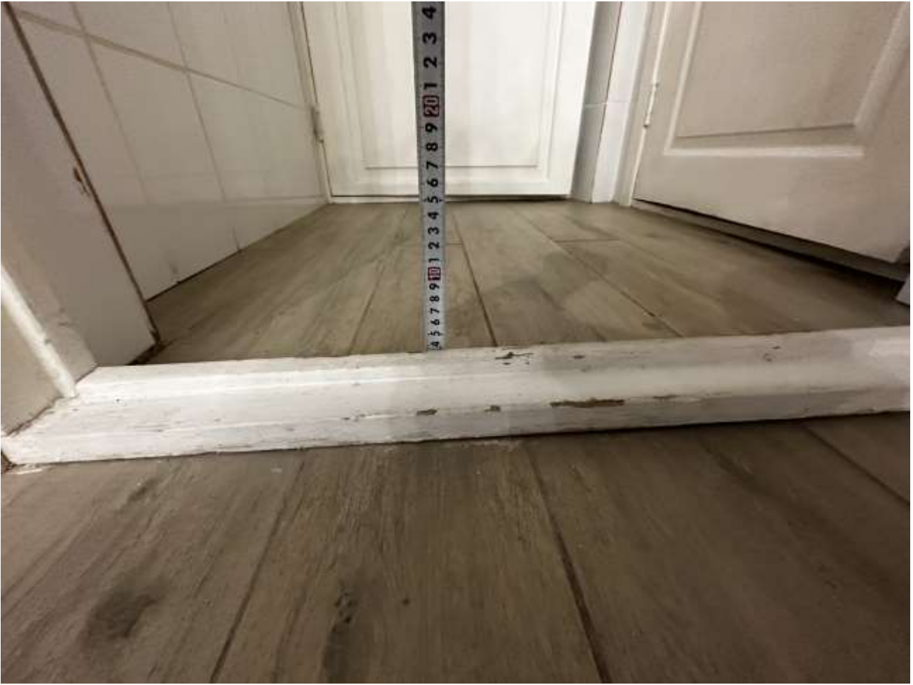
Рисунок 5.3. Высота порога 3,5 см
