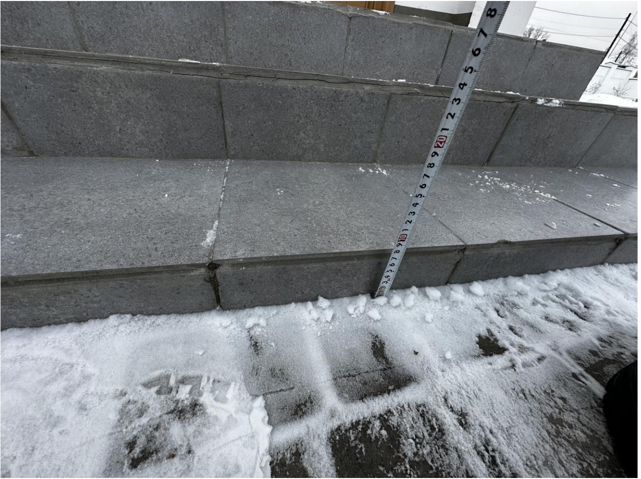
Рисунок 3.23 высота ступени 8 см
