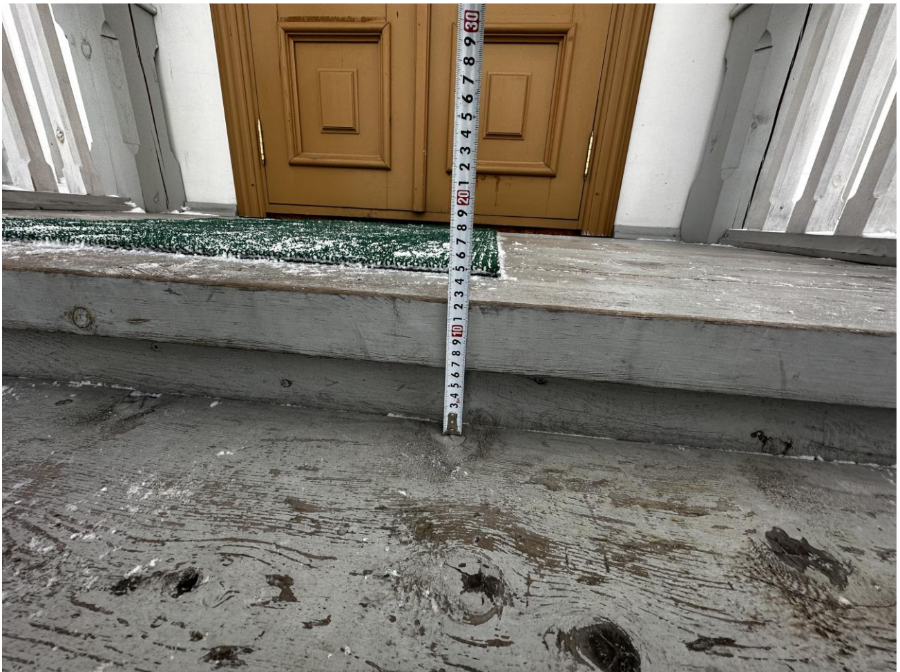
Рисунок 2.1.3 Высота ступени 13 см
