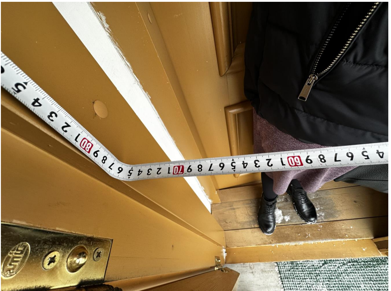
Рисунок 2.1.5 Ширина одной створки 75 см
