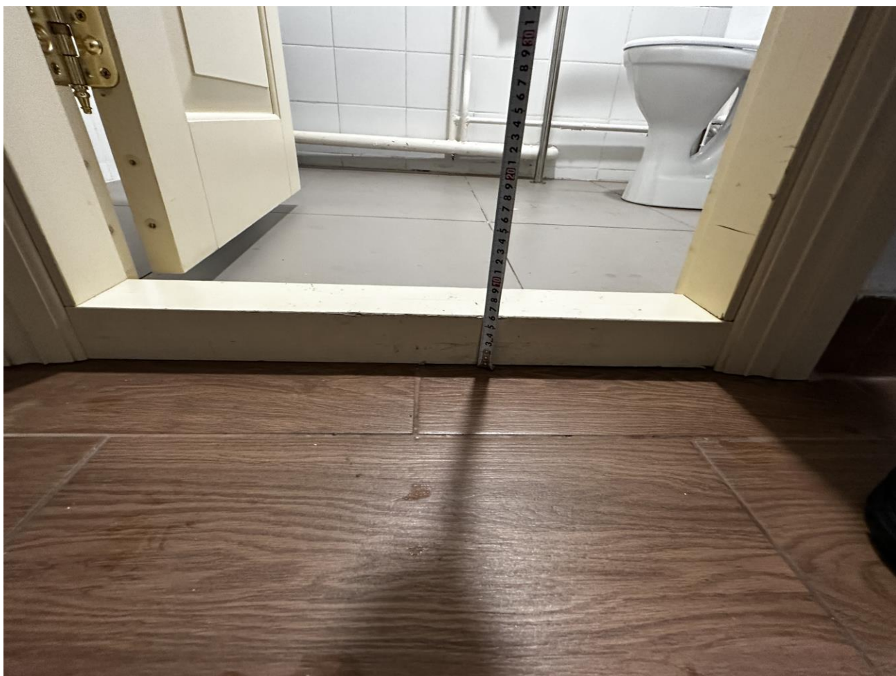
Рисунок 5.3 Высота порога 6 см
