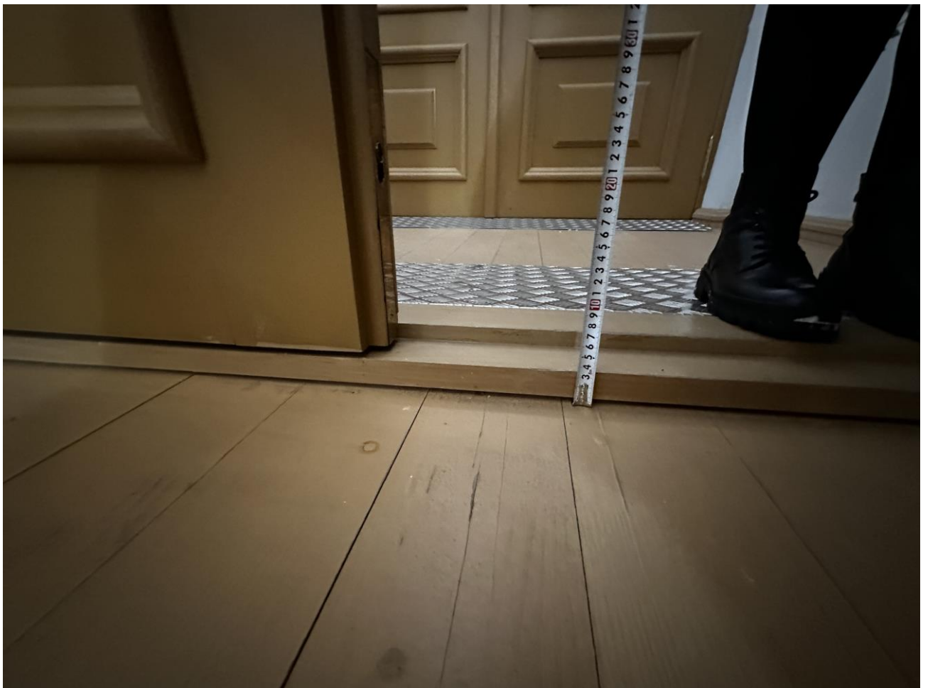
Рисунок 2.2.17 Высота порога 6 см
