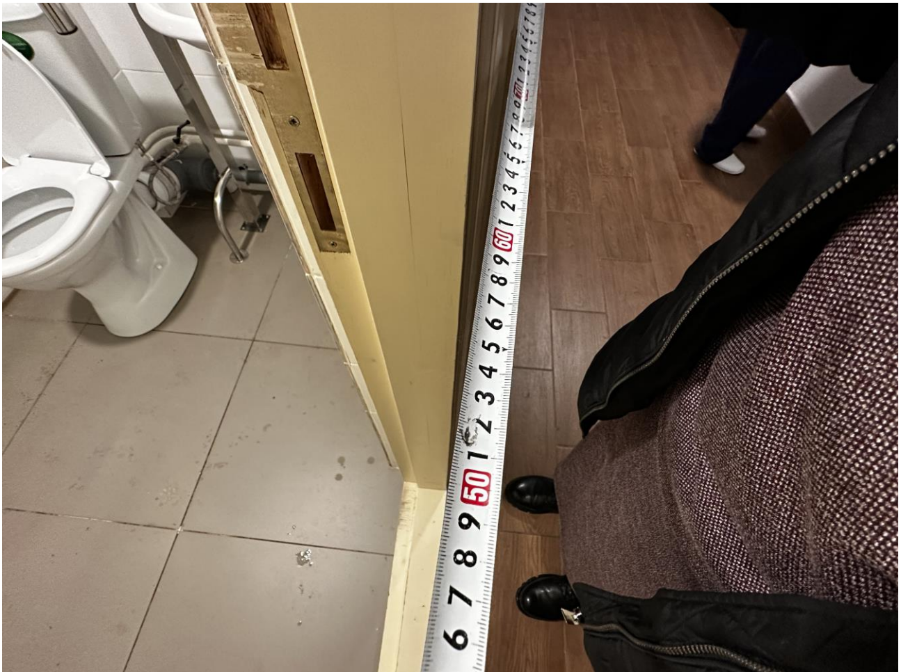
Рисунок 5.2 Ширина дверного проема 60 см
