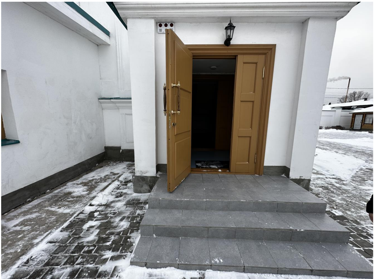
Рисунок 3.22 Эвакуационный выход. Вид с улицы
