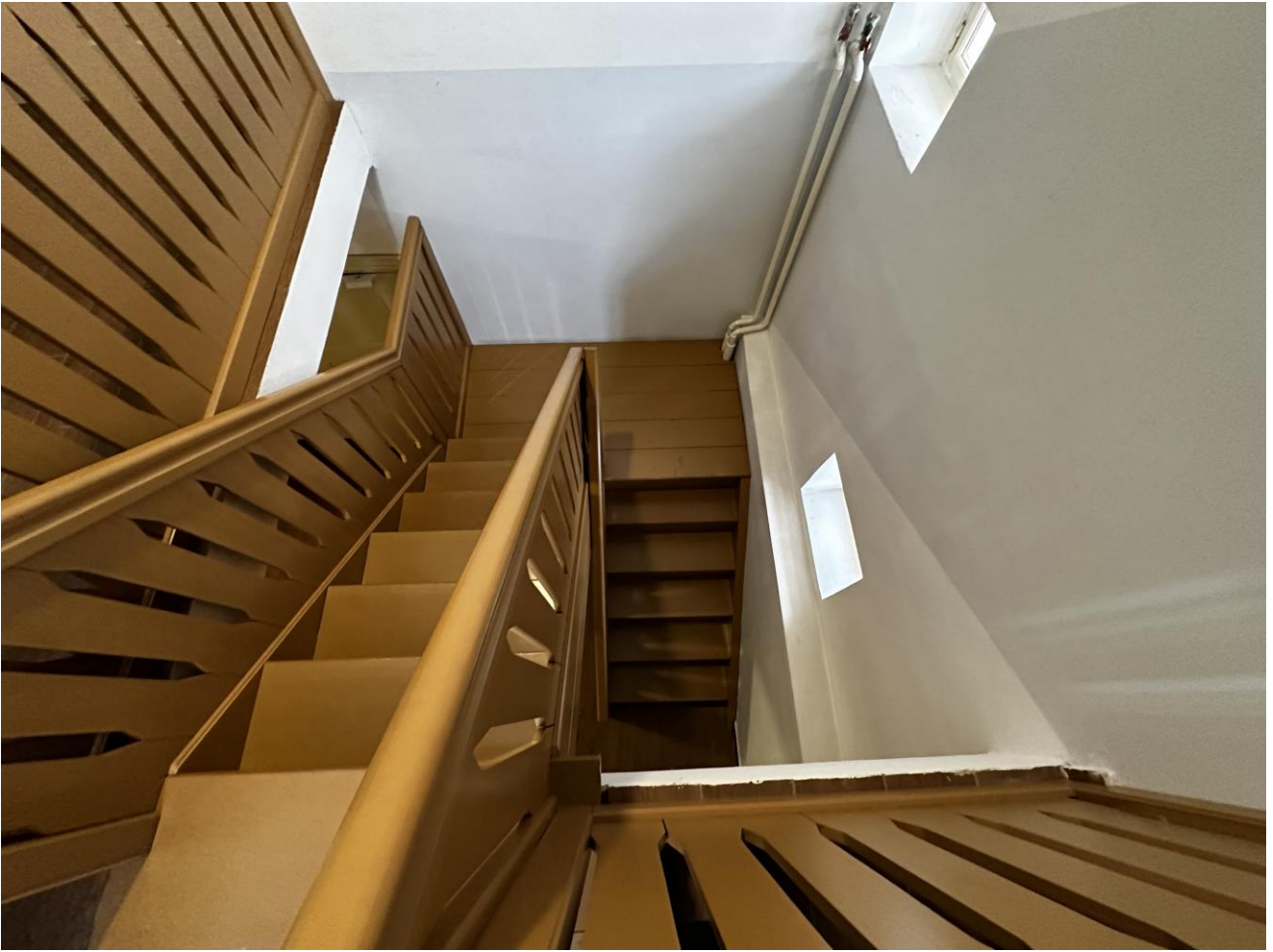
Рисунок 3.5 Лестничный марш. Вид со второго этажа
