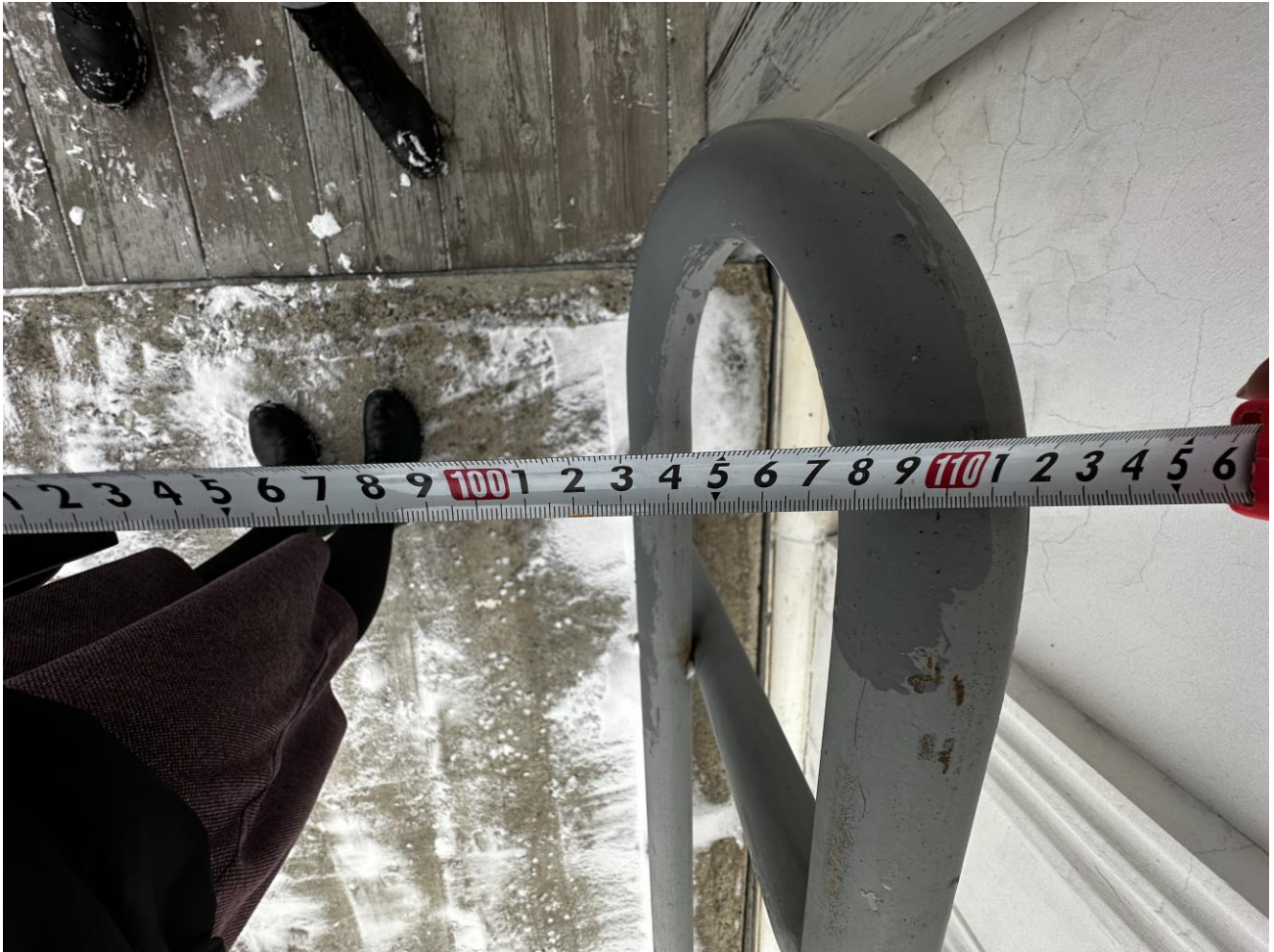
Рисунок 2.2.8 Расстояние между поручнями 108 см
