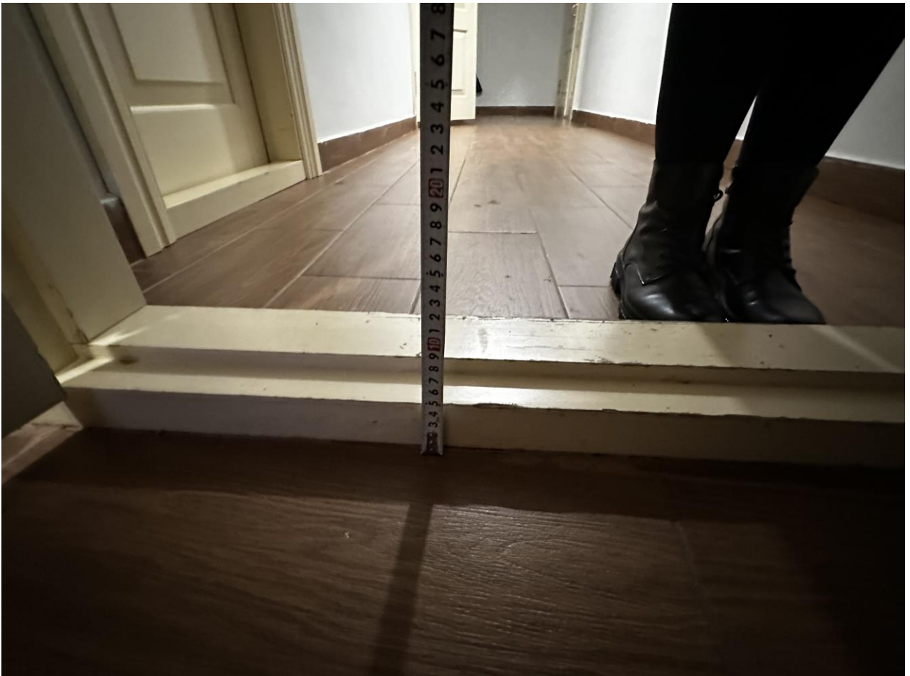
Рисунок 3.12 Высота порога 6 см
