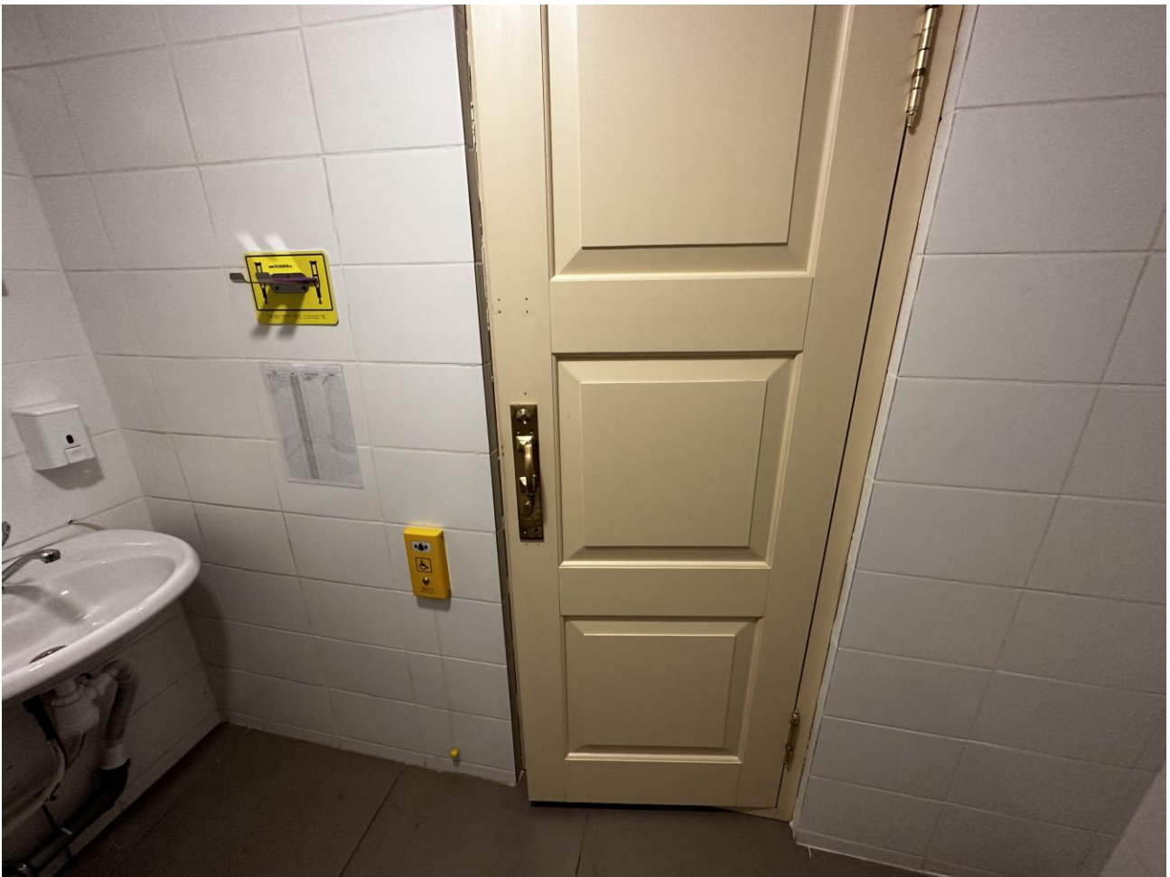
Рисунок 6.4 Кнопка вызова помощи в санузле
