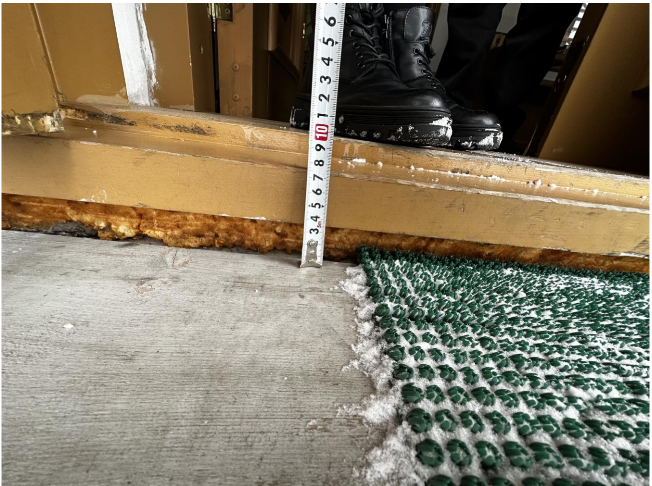
Рисунок 2.1.7 Высота порога 10 см
