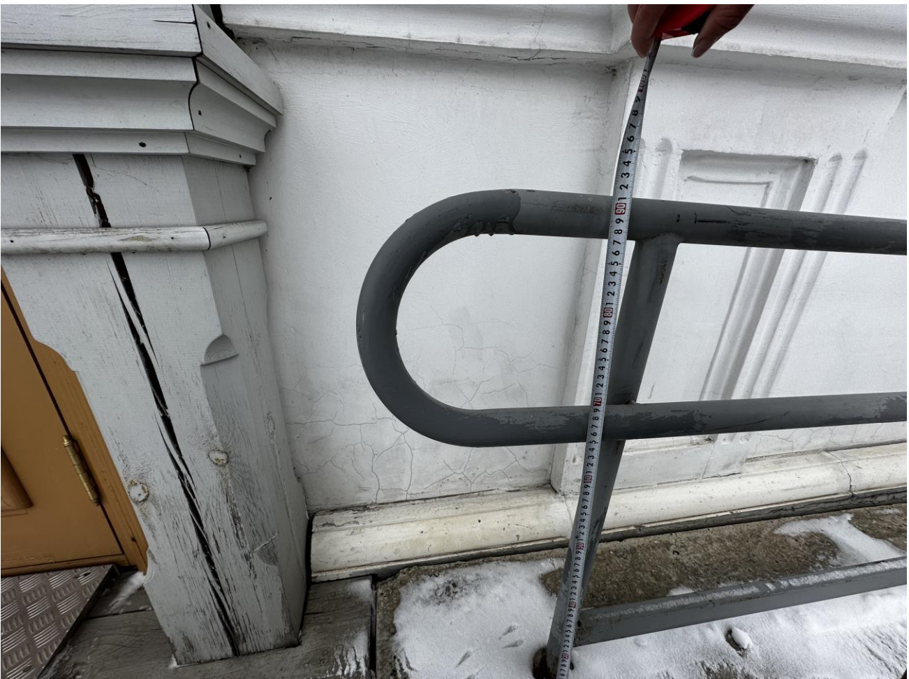
Рисунок 2.2.7 Высота поручней соответствует требованиям
