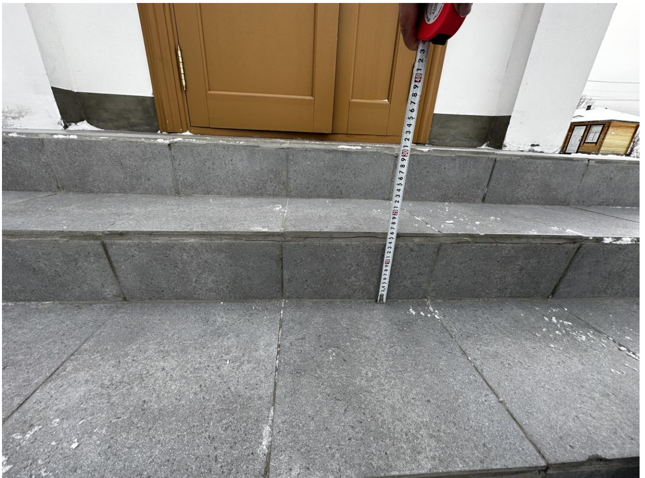
Рисунок 3.24 Высота ступени 16 см
