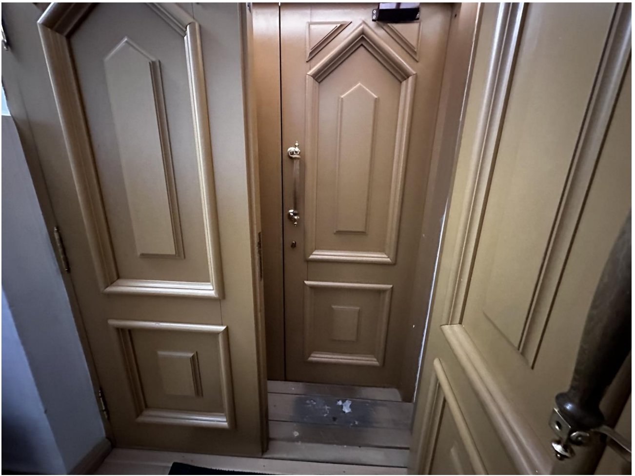
Рисунок 2.1.8 Входная дверь. Вид со стороны притвора
