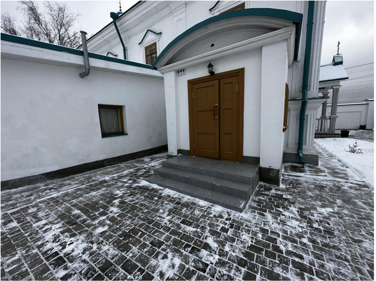
Рисунок 3.25 Эвакуационный выход. Вид с улицы
