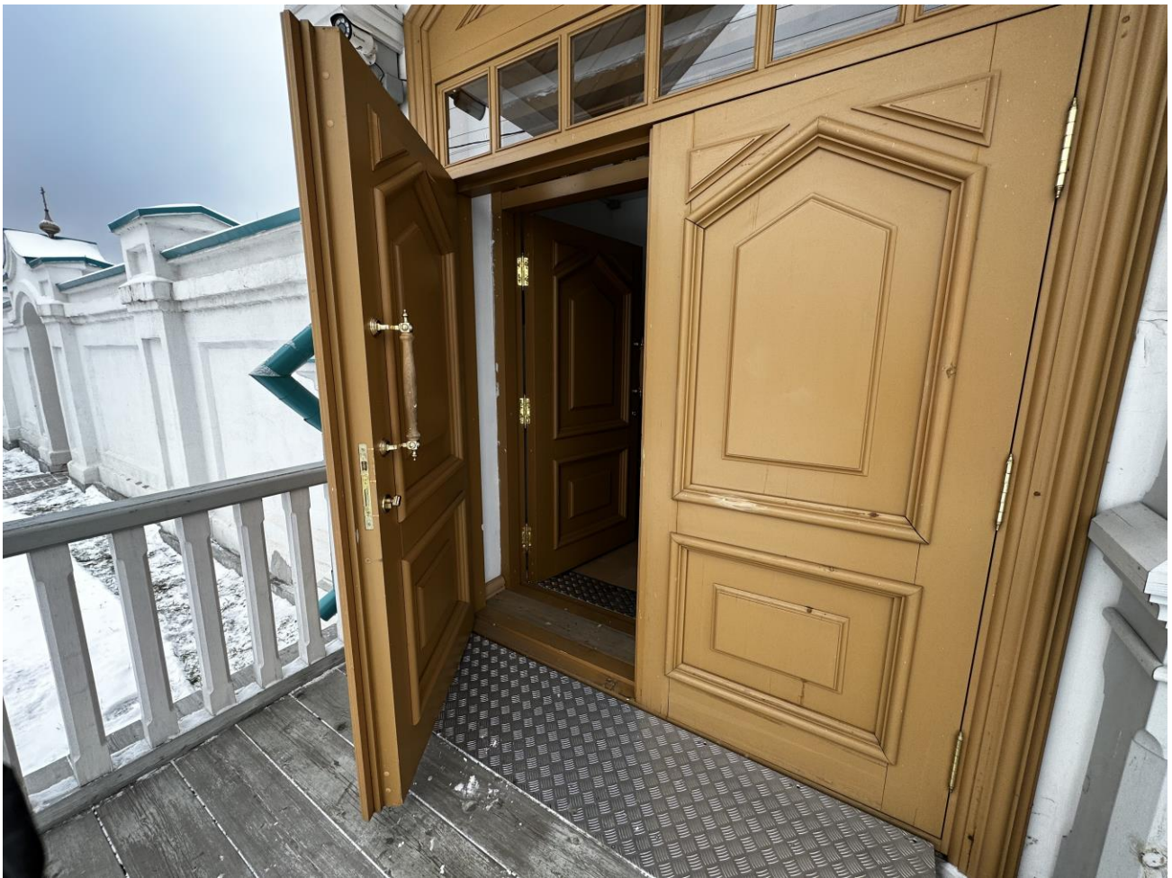
Рисунок 3.27 Эвакуационный выход № 2. Вид с улицы
