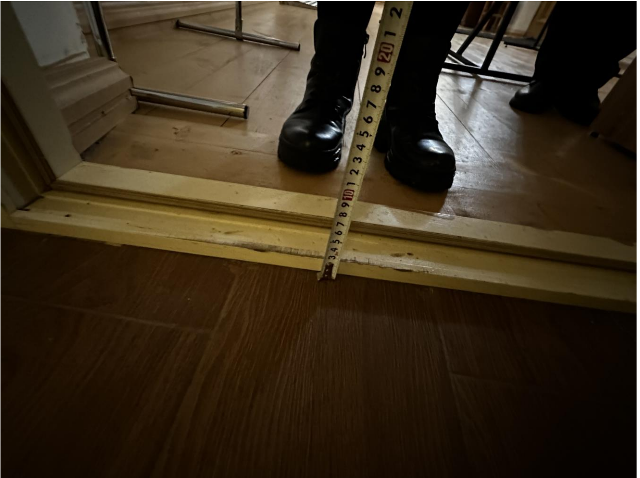
Рисунок 3.11 Высота порога 3 см
