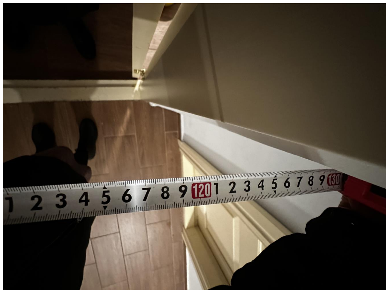
Рисунок 3.14 При открытии двух створок ширина дверного проема 125 см
