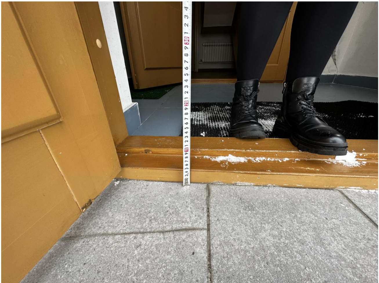
Рисунок 3.21 Высота порога 7 см
