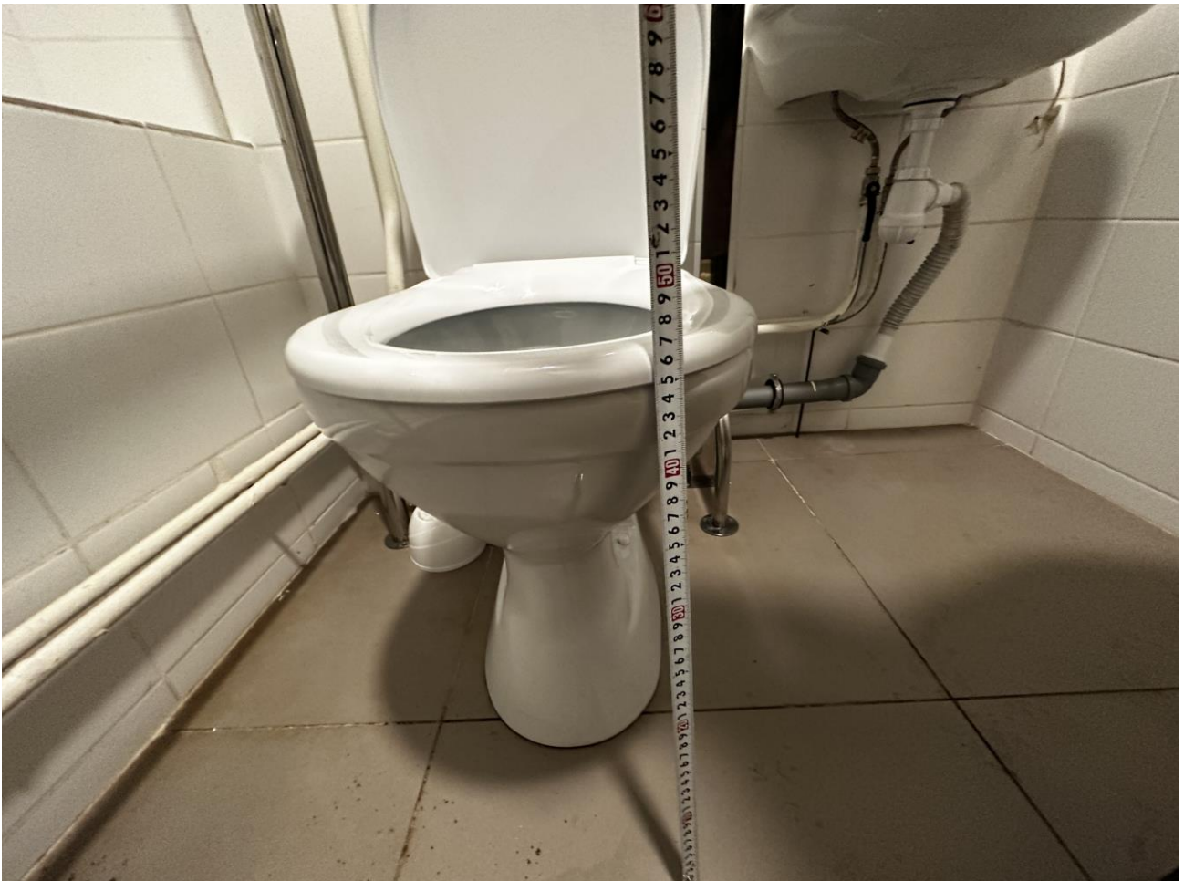
Рисунок 5.6 Высота унитаза соответствует требованиям
