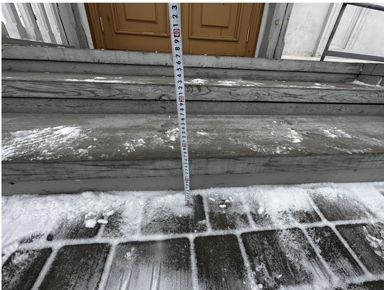
Рисунок 2.2.3 Высота ступени 17 см
