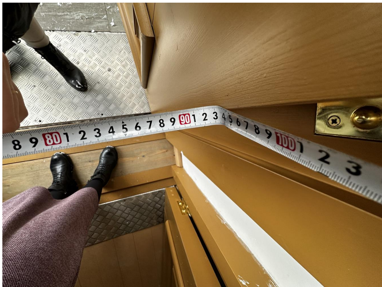
Рисунок 2.2.13 Ширина дверной створки 93 см
