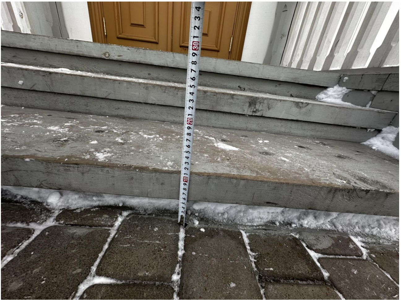
Рисунок 2.1.2 Высота ступени 11 см
