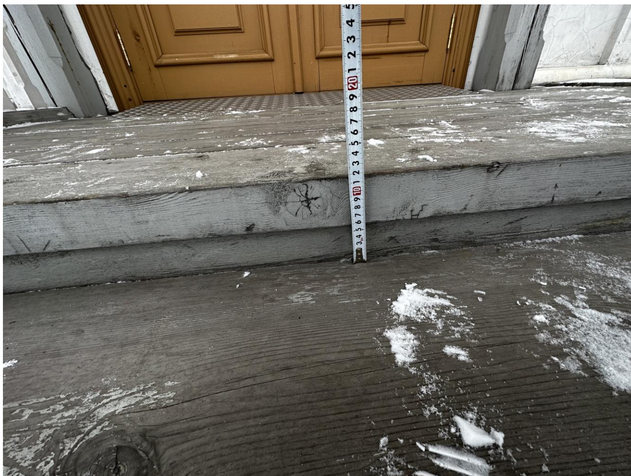
Рисунок 2.2.4 Высота ступени 12 см
