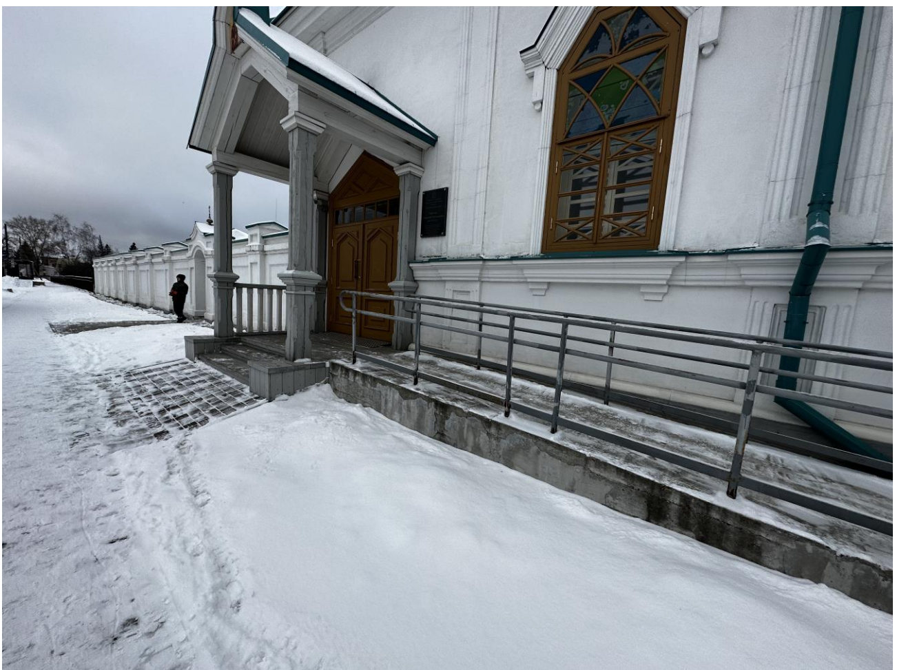
Рисунок 3.28 Эвакуационный выход №2. Вид с улицы
